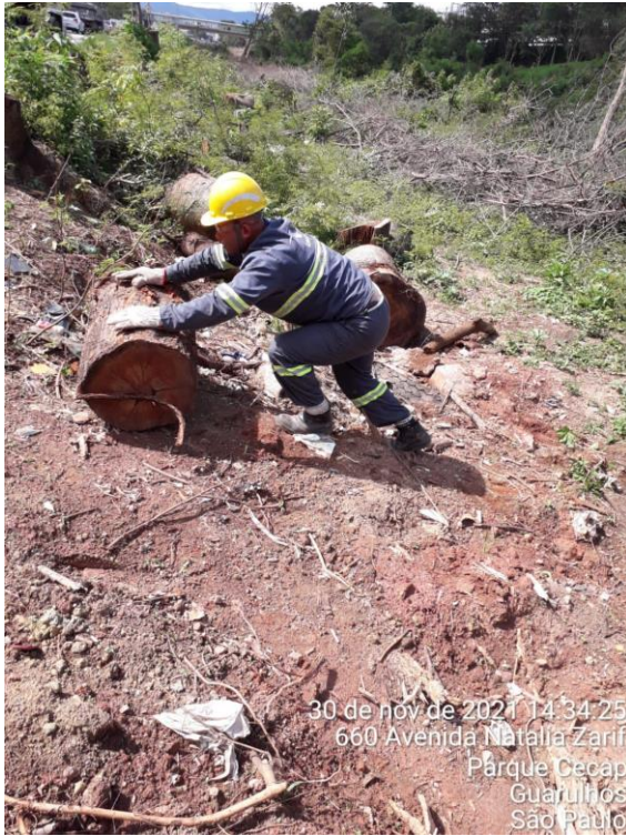
FOTO 1 – EXECUÇÃO DE ROÇADA E ENLEIRAMENTO
