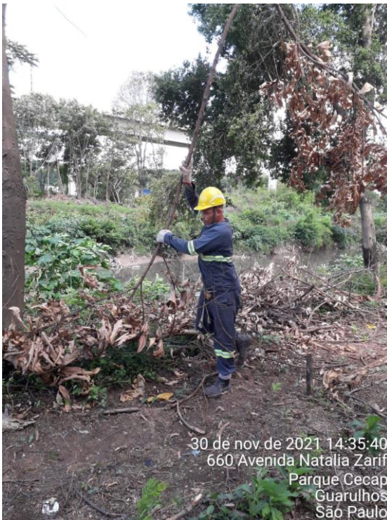
FOTO 4 – EXECUÇÃO DE ROÇADA E ENLEIRAMENTO
