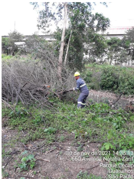
FOTO 3 – EXECUÇÃO DE ROÇADA E ENLEIRAMENTO
