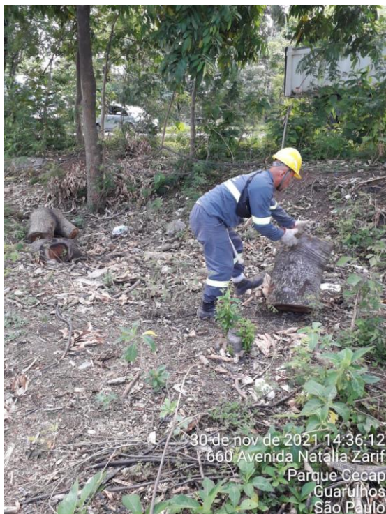
FOTO 2 – EXECUÇÃO DE ROÇADA E ENLEIRAMENTO
