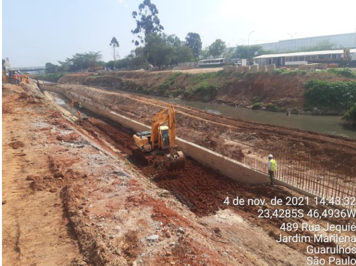
FOTO 1 – EXECUÇÃO DO ATERRO
