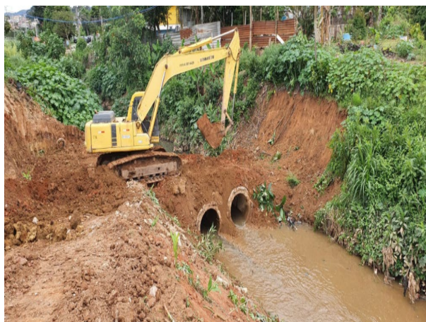
Foto 1: Execução da passagem molhada, no Córrego Cachoeirinha (12/11/2021)
