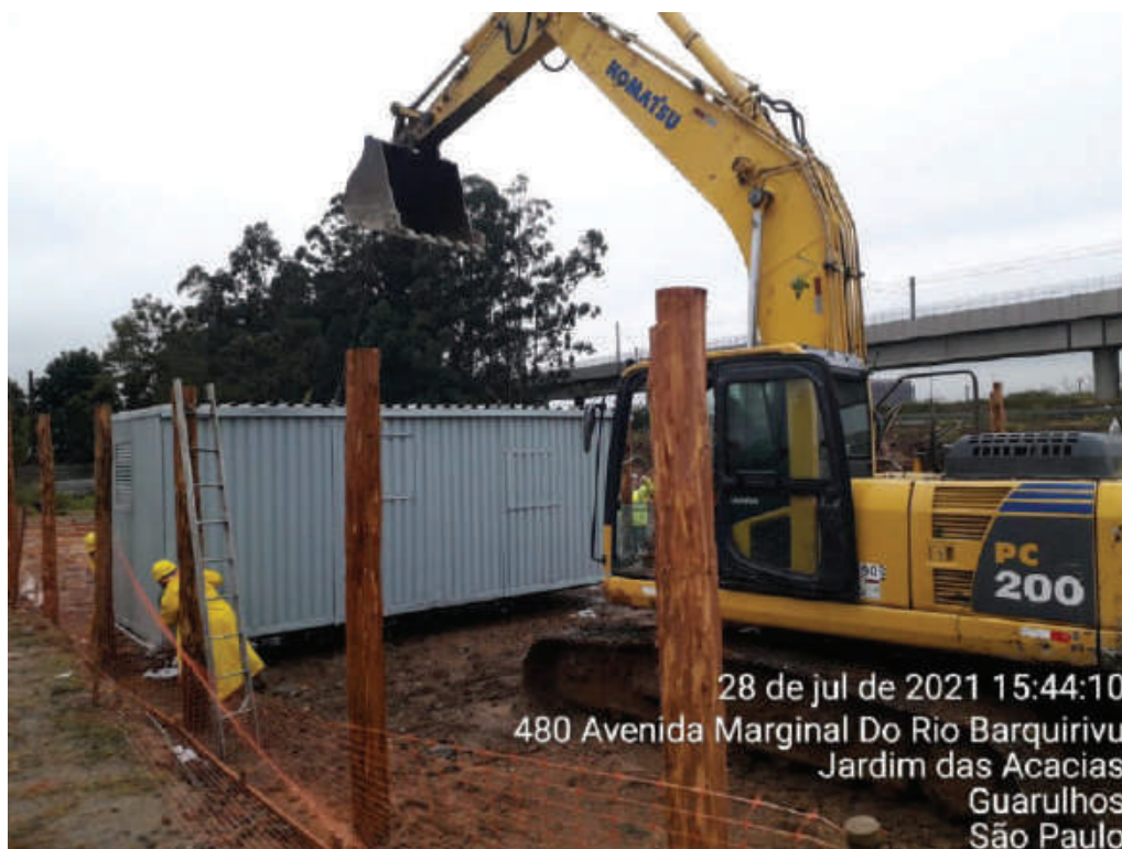
FOTO 5 – INÍCIO DE INSTALAÇÃO DE CANTEIRO – 28/07/2021
