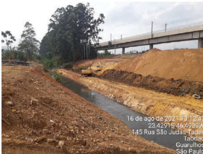
FOTO 9 –EXECUÇÃO DA ENSECADEIRA 16/08/2021
