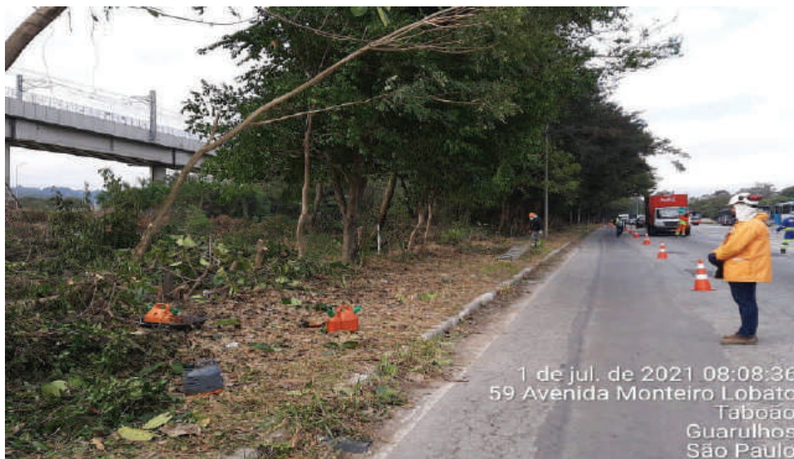
FOTO 2 – ISOLAMENTO DA ÁREA DE TRABALHO – 01/07/2021
