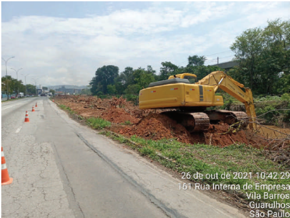
FOTO 6 – LIMPEZA DA ÁREA – 26/10/2021
