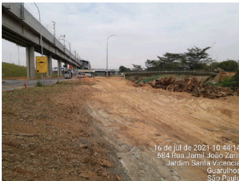
FOTO 3 - LIMPEZA DA ÁREA – 16/07/2021
