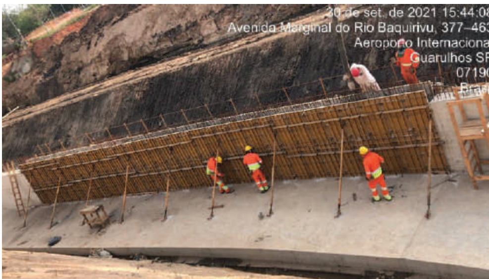
FOTO 11 – CONCRETAGEM DA PAREDE COM USO DE BOMBA-LANÇA 30/09/2021
