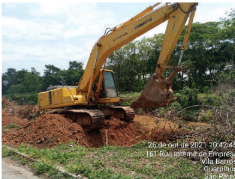
FOTO 13 – LIMPEZA DA ÁREA 26/10/2021
