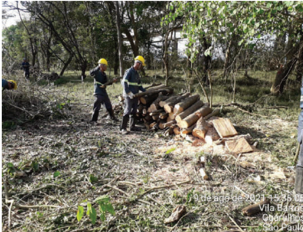
FOTO 4 – SUPRESSÃO VEGETAL/ ENLEIRAMENTO– 09/08/2021
