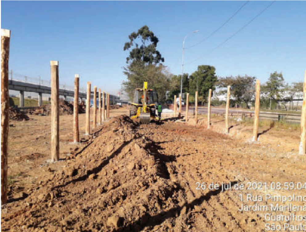
FOTO 4 - INÍCIO DE INSTALAÇÃO DE CANTEIRO – 26/07/2021
