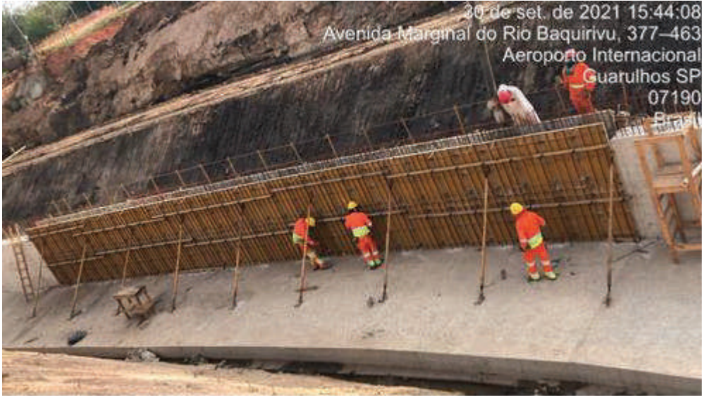
FOTO 12 – CONCRETAGEM DA 1ª ETAPA DA PAREDE - 30/09/2021
