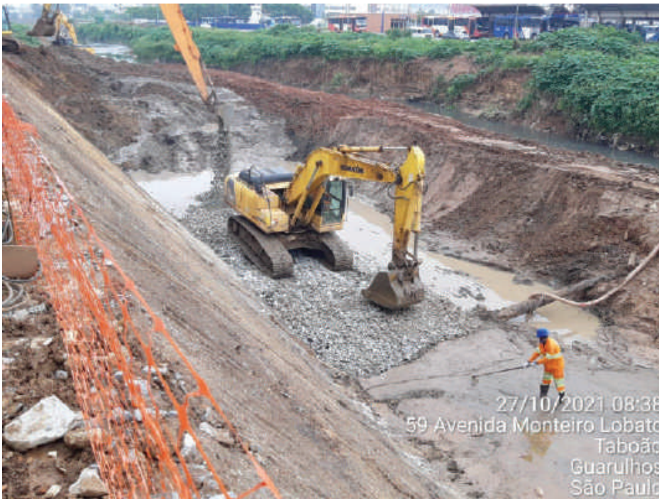
FOTO 14 – REALIZAÇÃO DE CONCRETAGEM 27/10/2021
