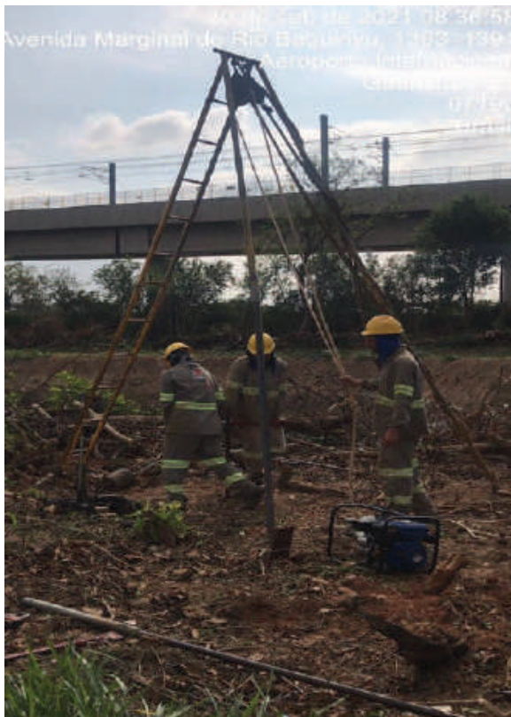
FOTO 12 – EQUIPE DA EMPRESA GEOSITU REALIZANDO SONDAGEM DE SOLO 30/09/2021
