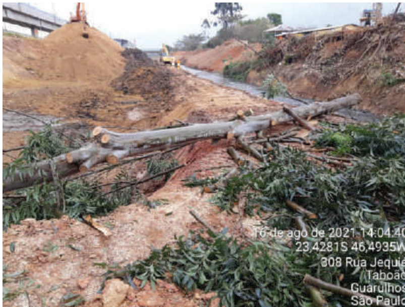
FOTO 8 –MATERIAL SUPRIMIDO RETIRADO DE CONTATO COM O LEITO DO RIO 16/08/2021
