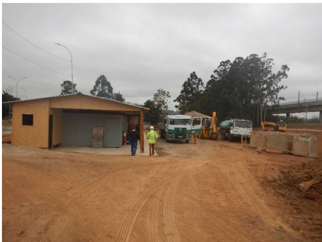
Foto 1: Canteiro de obras (Autorização nº 38393/2021).
