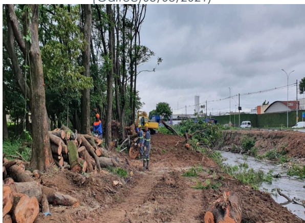
Foto 4: Limpeza da área estaca 237 ME (20/10/2021)
