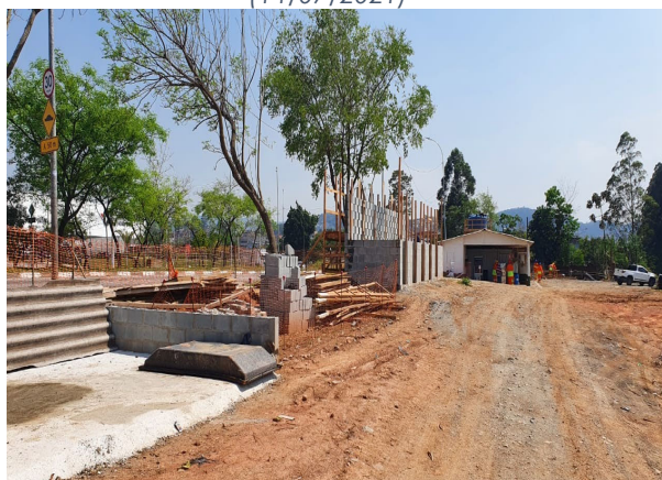
Foto 3: Execução das baias de resíduos e produtos químicos (27/09/2021)
