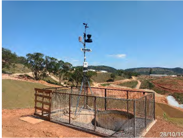
Estação Meteorológica Automática -EMA da Barragem Pedreira.
