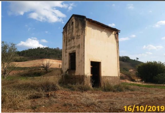
Foto 1 - Vista geral da casa de força
