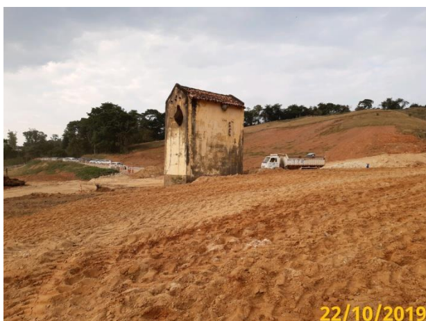
Foto 9 – Vista da casa 11 no dia da demolição (Data: 22/10/19)
