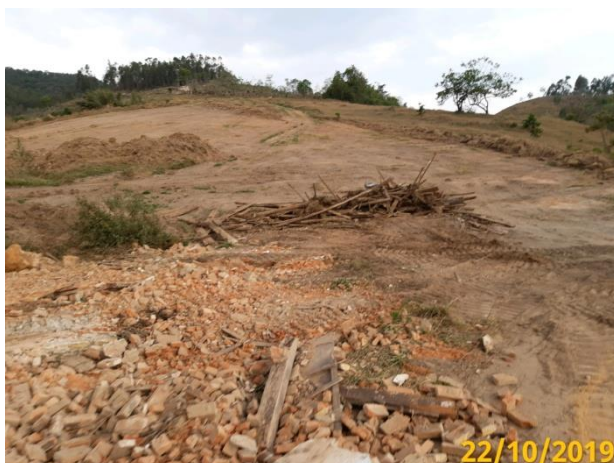
Foto 7 – Vista dos resíduos de demolição da casa 13.3 (Data: 22/10/19)
