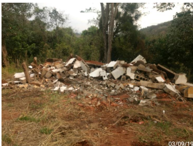
Foto 5 – Vista geral da demolição da casa 34.1. (Data: 03/09/2019).
