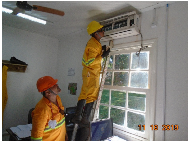
Foto 11 – Limpeza e higienização dos aparelhos de ar condicionado (11/10/2019).
