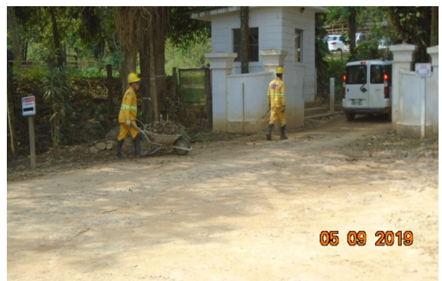
Foto 2 – Limpeza e organização do canteiro de obras (05/09/2019).
