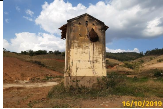
Foto 2 - Vista geral da casa de força
