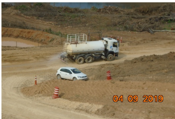
Foto 1 – Umectação da via interna do canteiro de obras (04/09/2019).
