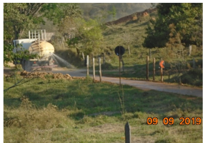
Foto 4 – Umectação da via interna do canteiro de obras (09/09/2019).
