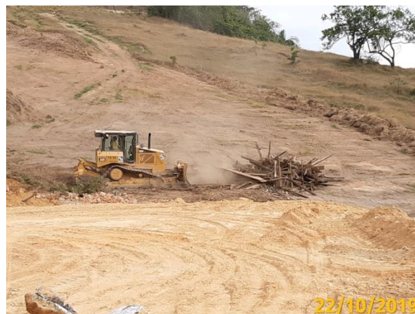
Foto 8 – Vista da segregação dos resíduos da casa 13.3 (Data: 22/10/19)
