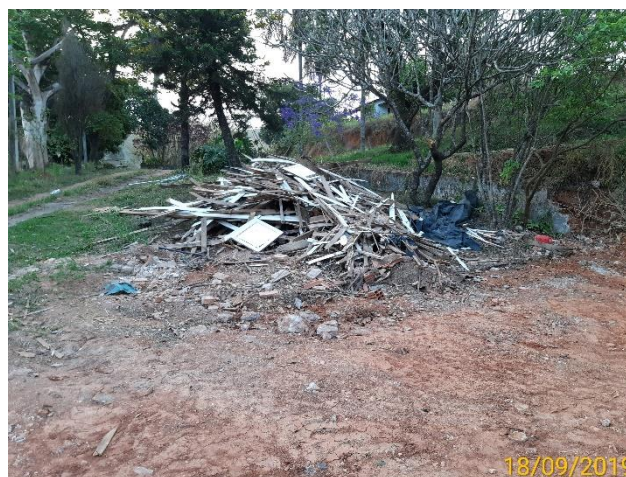
Foto 2 - Vista do resíduo de demolição da casa 33. (Data: 18/09/2019).
