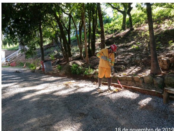
Foto 17 – Limpeza do canteiro de obras (18/11/2019)
