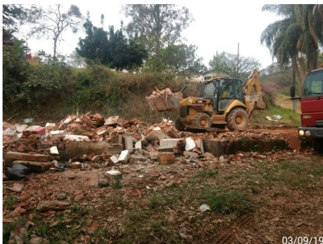
Foto 3 - Vista geral da demolição da casa 34. (Data:03/09/2019).
