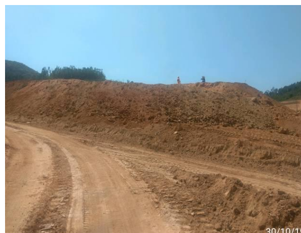
Foto 10 – Vista do local da demolição da casa 11 após a demolição (Data: 30/10/19)
