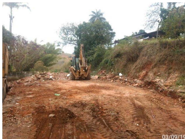
Foto 4 - Vista geral da limpeza da casa 34. (Data:03/09/2019).
