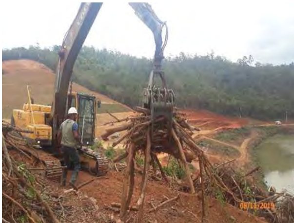
Foto 35 – Acompanhamento da atividade de limpeza de galhada. (Data: 08/11/19)
