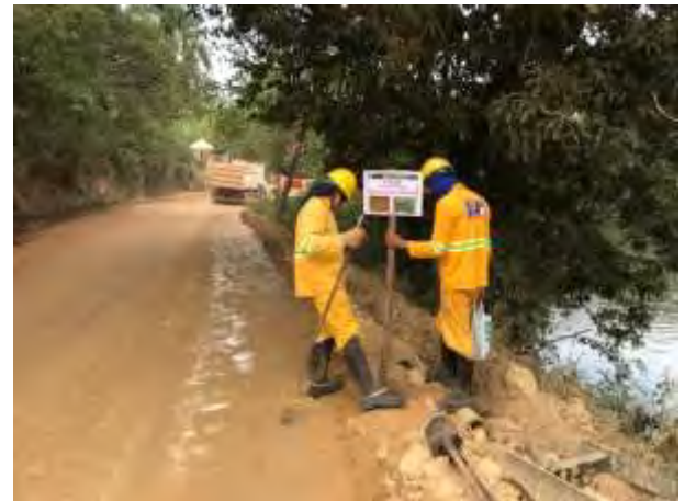
Foto 56 – Funcionário do Consórcio BP instalando placas de sinalização ao longo da via (22/10/2019).
