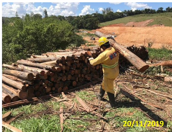
Foto 16 – Empilhamento manual das toras.
