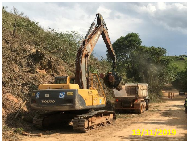
Foto 13 – Colaborador executando o bosqueamento.
