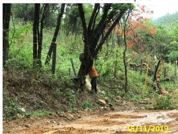
Foto 9 – Operador de Motosserra realizando a supressão no Acesso MD01.
