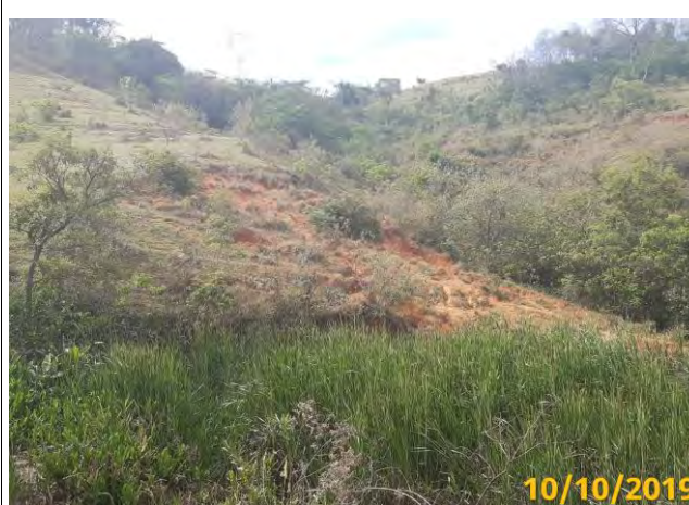
Foto 02: Detalhe das ravinas/sulcos presentes na área.
