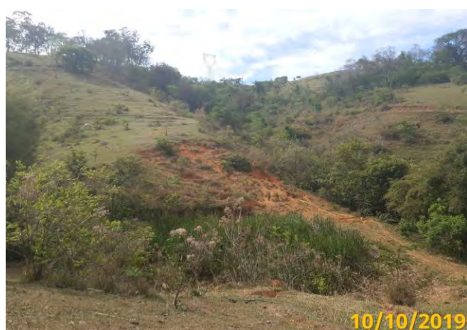
Foto 01: Visada geral da área de passivo ambiental.
