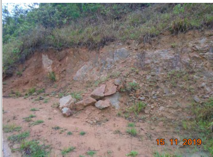
Foto 01 Vista das feições erosivas no talude Foto 02 Detalhe do deslocamento rochoso
