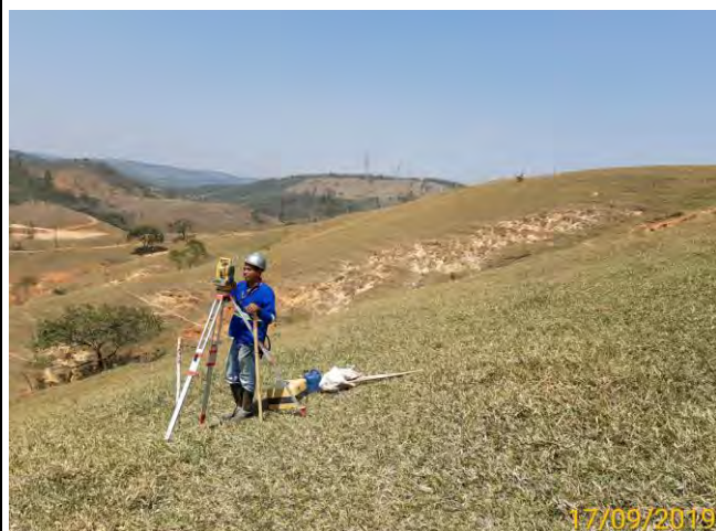
Foto 01: Equipe de topografia realizando a levantamento do passivo ambiental.
