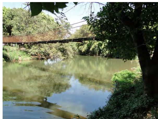
Foto 6 – Ponto P06 - Rio Jaguari, na Cidade de Pedreira, no Local de Captação de Água para Abastecimento. (Foto: 03/10/2019)
