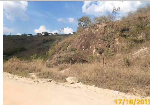
Foto 02: Risco de deslocamento do maciço rochoso.
