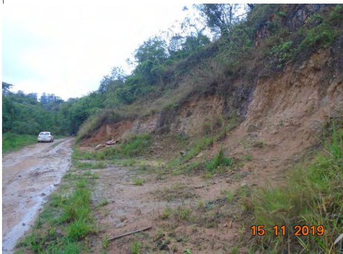
Foto 01 Vista das feições erosivas no talude Foto 02 Detalhe do deslocamento rochoso
