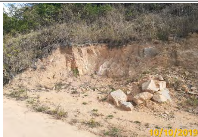
Foto 02: Risco de deslocamento no maciço/terroso.
