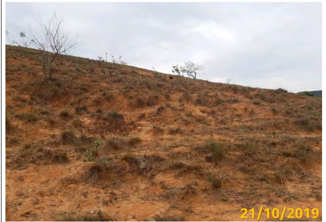
Foto 02: Detalhe das ravinas e sulcos.
