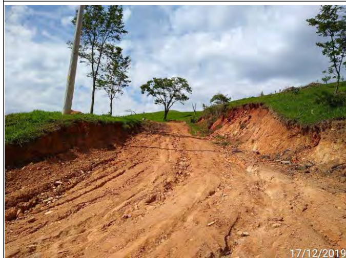
Foto 01 Vista dos sulcos erosivos e talude de corte. Foto 02 Detalhe do processo erosivo no talude.
