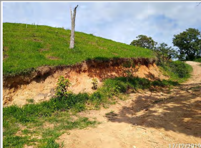
Foto 01 Vista dos sulcos erosivos e talude de corte. Foto 02 Detalhe do processo erosivo no talude.
