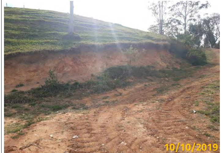
Foto 02: Panorama da formação de sulcos erosivos formados pela concentração do escoamento. Nota-se feições erosivas no corte do talude.
