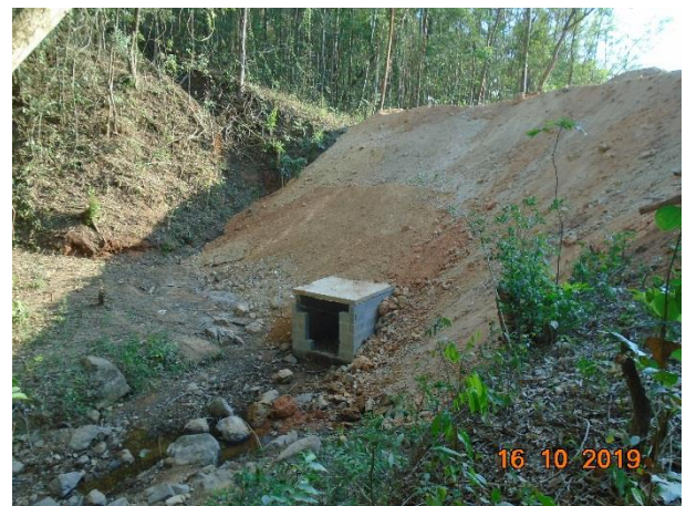
Foto 8 – Monitoramento de ictiofauna preventivo durante implantação de Aterro (Bota-fora 2). (Data: 16/10/2019)
