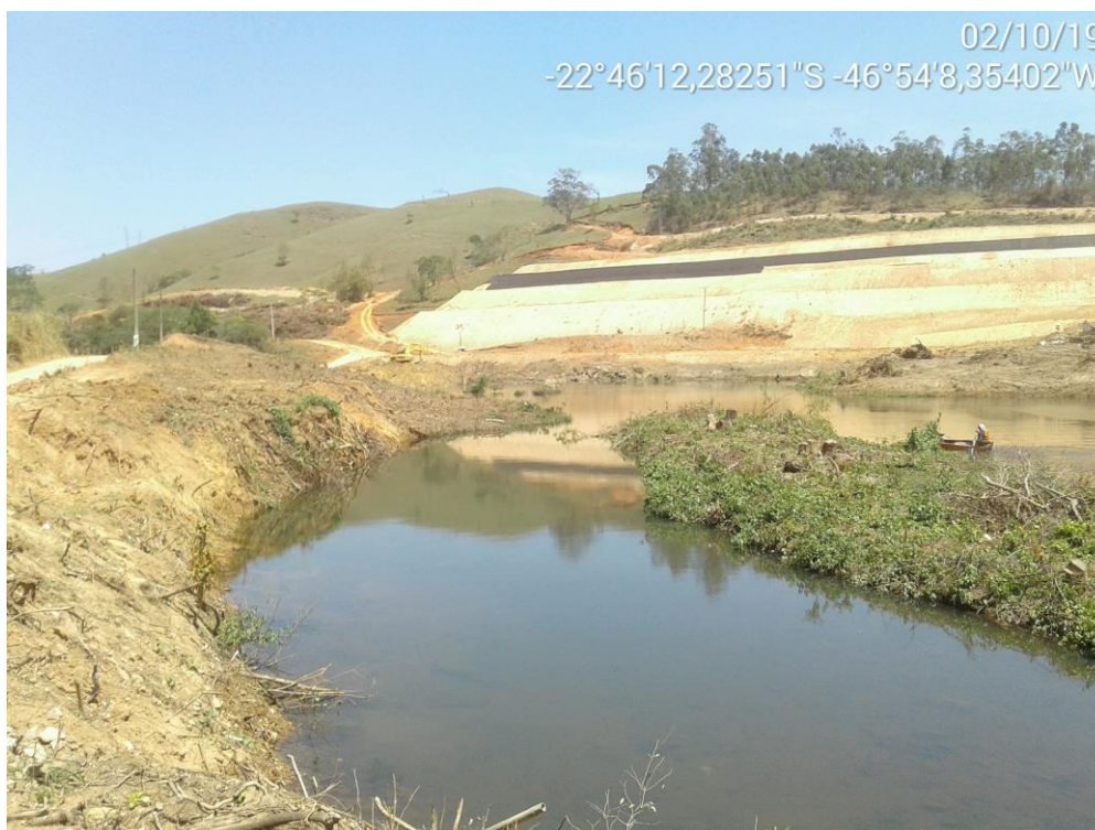
FOTO 2.2-2: Vista do ponto amostral IC02, destacando o avanço das obras na margem do rio
