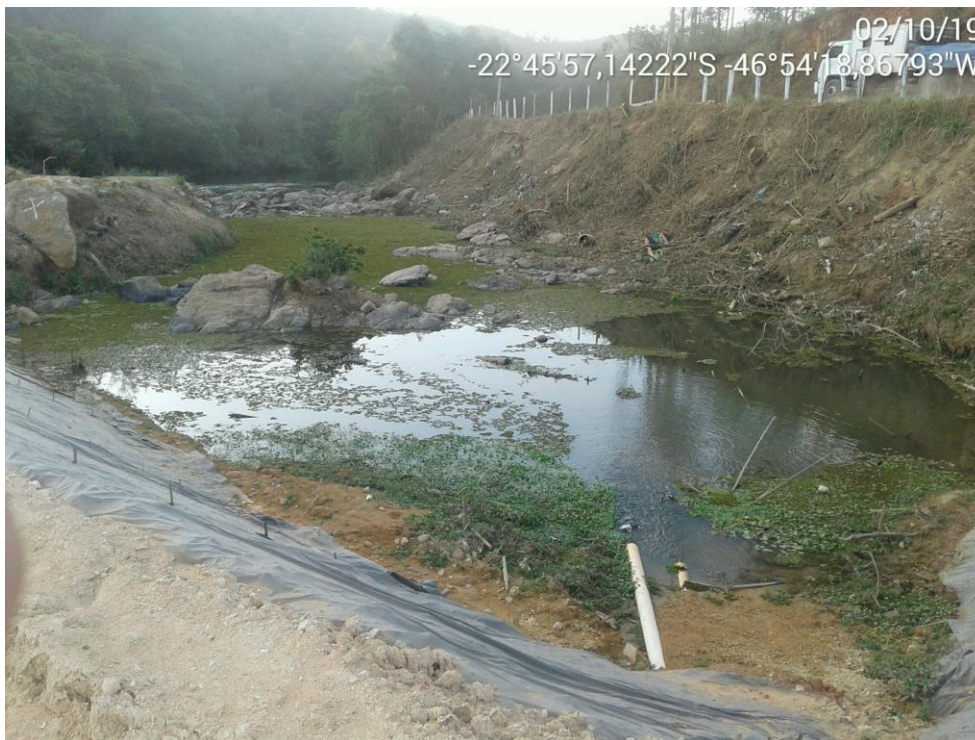
FOTO 2.2-3: Vista do ponto amostral IC03, evidenciando atividades das obras para a implantação da barragem
