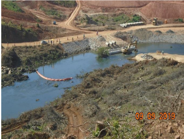
Foto 5 – Visada geral para implantação da ponte tipo passagem molhada acompanhada por especialista. (Data 09/09/2019)
