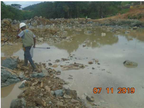
Foto 9 – Ictiólogo acompanhando atividade de desmonte de rocha na Ilha-04. (Data: 07/11/2019).
