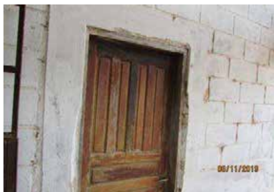
Ambiente interno 02 s/ acesso
