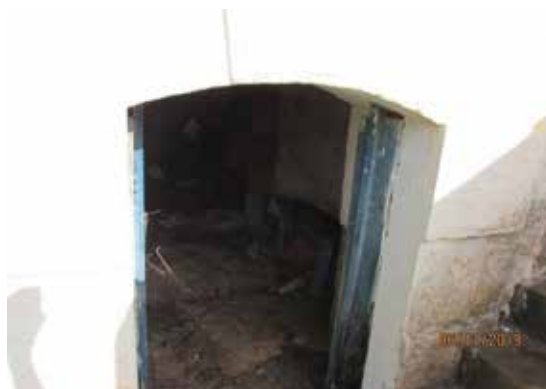
Porão s/ acesso
