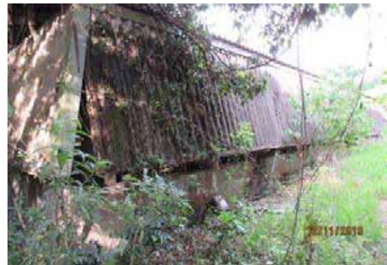
Fachada - Lateral Direita
