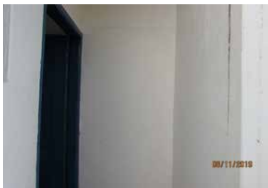
Hall de acesso 02
