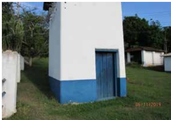
Cabine de energia
