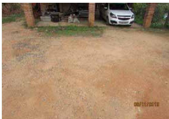
Pav. do acesso
