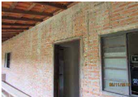
Acesso à Sala de estar
