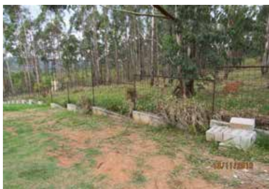
Cerca de delimitação lateral - Vista 2
