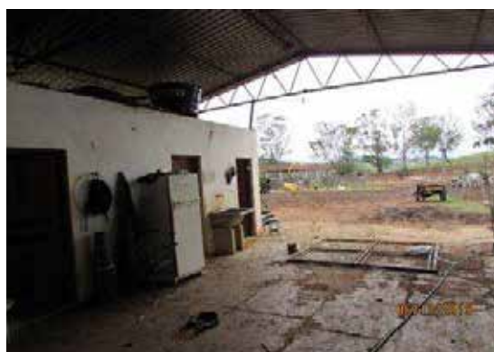
Ambiente interno 01 - Vista 02
