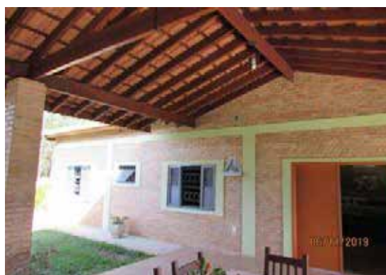
Acesso aos dormitórios
