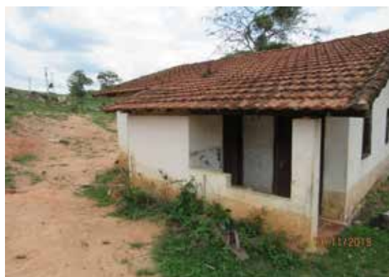
Lateral do imóvel - Vista 1
