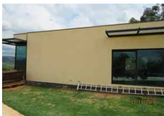
Lateral do imóvel - Vista 1
