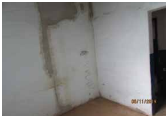
Ambiente interno 03 - Vista 02
