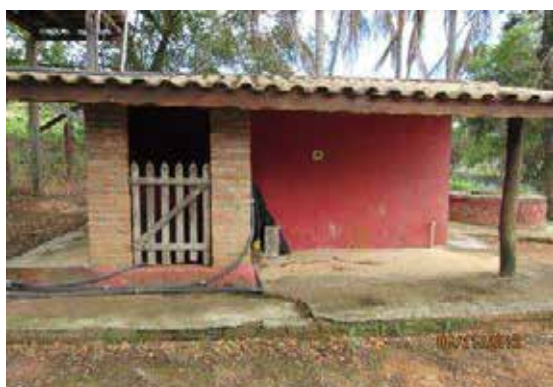
Vista à esquerda do imóvel
