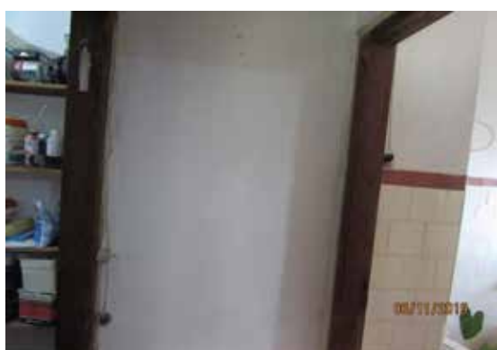
Acesso ao banheiro 03
