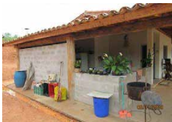
Vista aos fundos do imóvel
