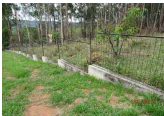
Cerca de delimitação lateral - Vista 3
