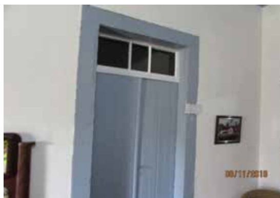
Depósito 02 s/ acesso
