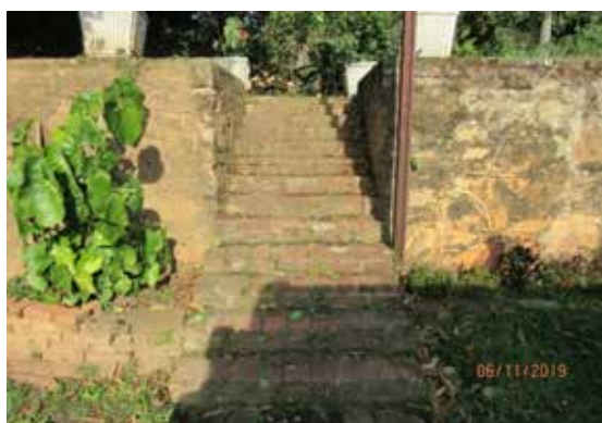
Escada de acesso 01
