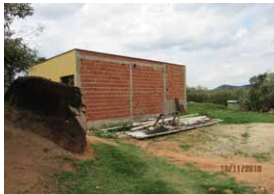
Edícula - Vista dos fundos
