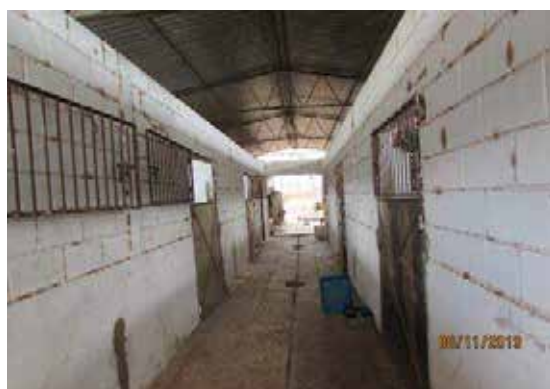
Corredor interno - Vista 02
