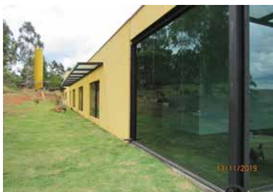
Lateral do imóvel - Vista 8
