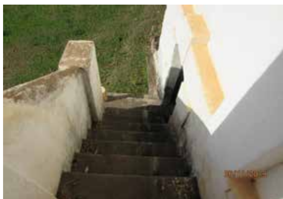
Escada de acesso 01
