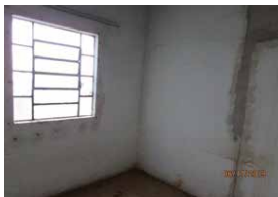
Ambiente interno 03 - Vista 01
