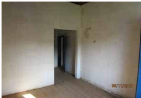
Ambiente interno 06 - Vista 02
