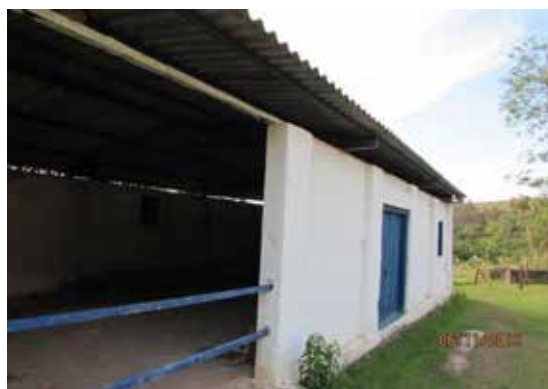
Acesso ao galpão
