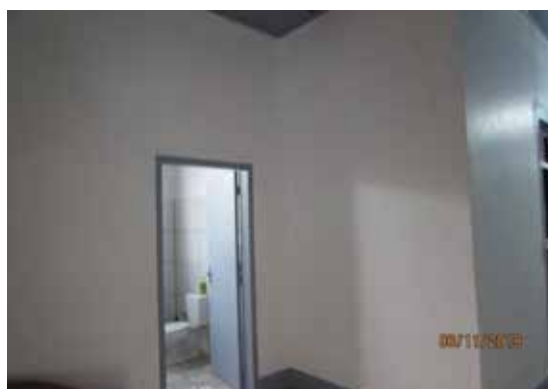
Ambiente interno 02 - Vista 02
