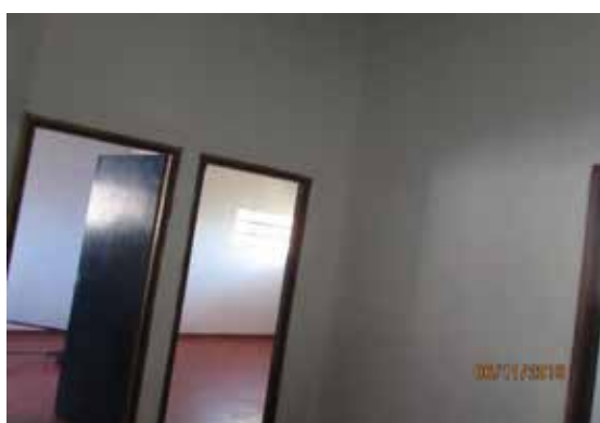
Ambiente interno 04 - Vista 01
