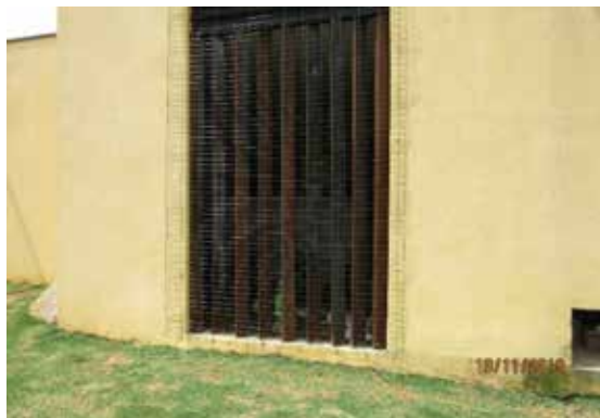
Lateral do imóvel - Vista 4
