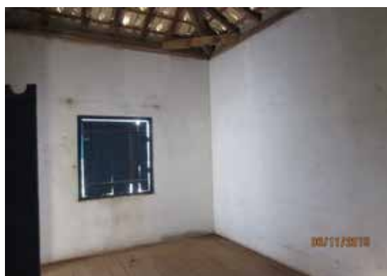
Ambiente interno 06 - Vista 01
