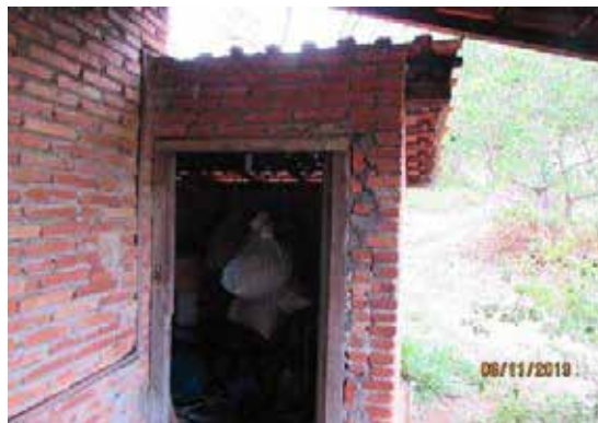
Acesso ao depósito
