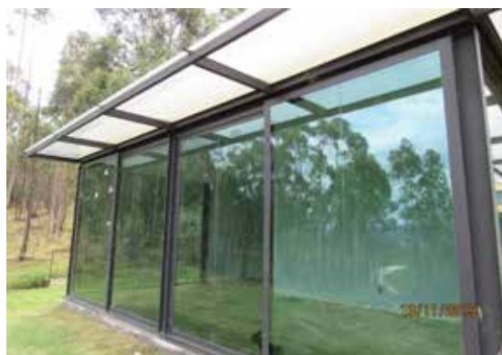
Lateral do imóvel - Vista 7
