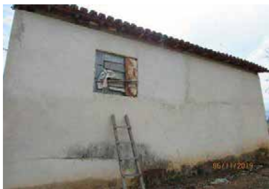
Vista aos fundos do imóvel
