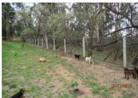
Cerca de delimitação fundos - Vista 3
