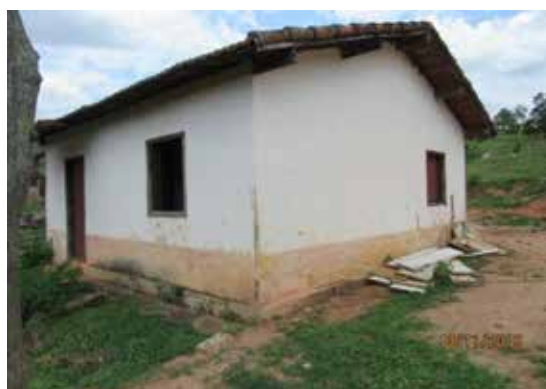
Lateral do imóvel - Vista 3
