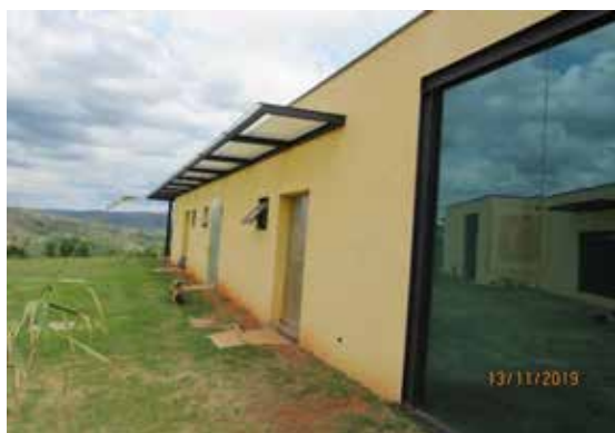
Lateral do imóvel - Vista 6
