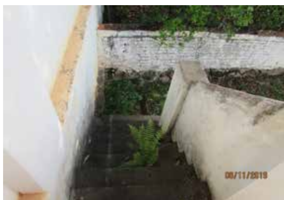
Escada de acesso 02
