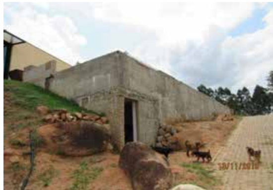
Fachada da casa de máquinas
