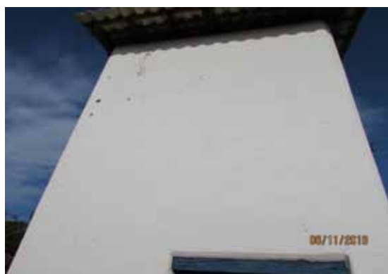
Acesso á Cabine de energia
