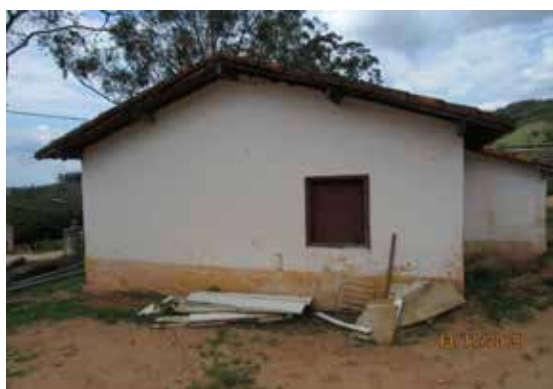
Lateral do imóvel - Vista 2
