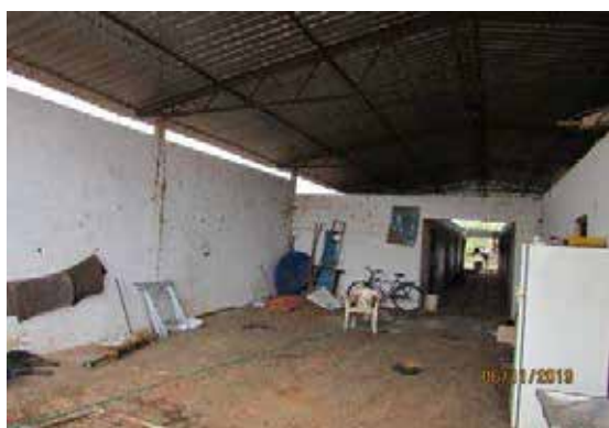
Ambiente interno 01 - Vista 01
