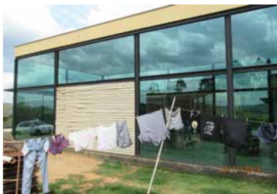
Lateral do imóvel - Vista 11
