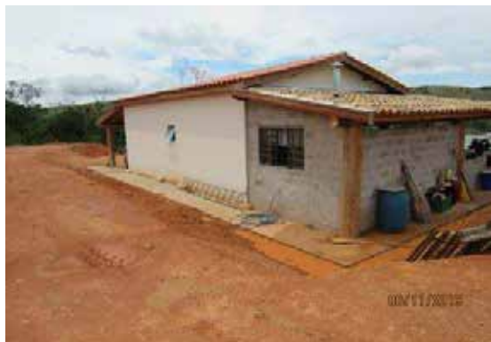
Vista à esquerda do imóvel
