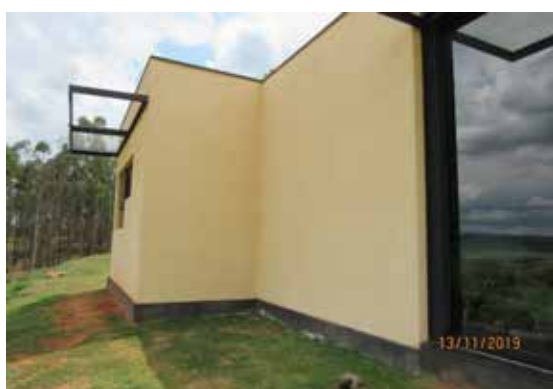
Lateral do imóvel - Vista 2
