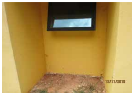
Lateral do imóvel - Vista 9
