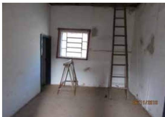
Ambiente interno 02 - Vista 01
