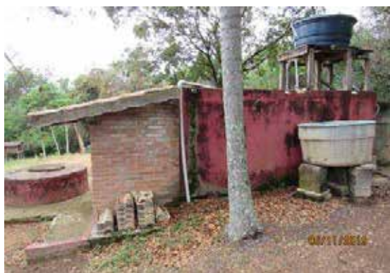
Vista à direita do imóvel
