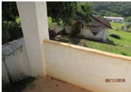
Hall de acesso
