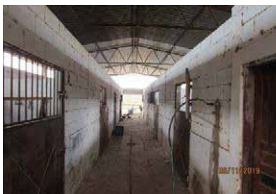
Corredor interno - Vista 01
