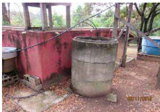
Vista aos fundos do imóvel
