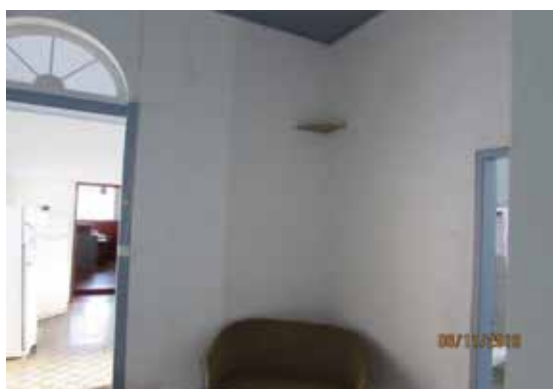
Ambiente interno 02 - Vista 01
