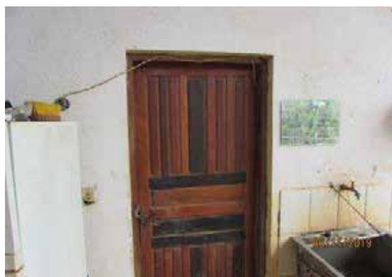
Depósito 02 s/ acesso
