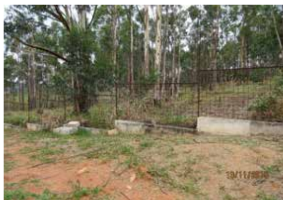
Cerca de delimitação lateral - Vista 1
