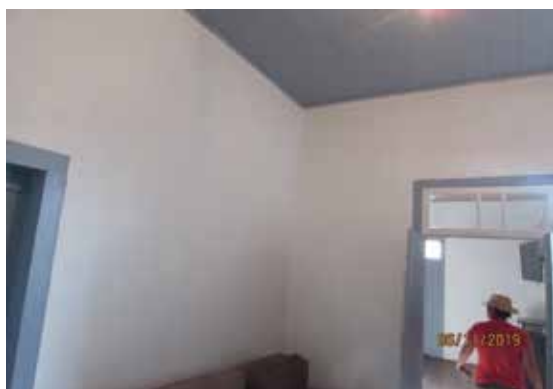
Ambiente interno 01 - Vista 01
