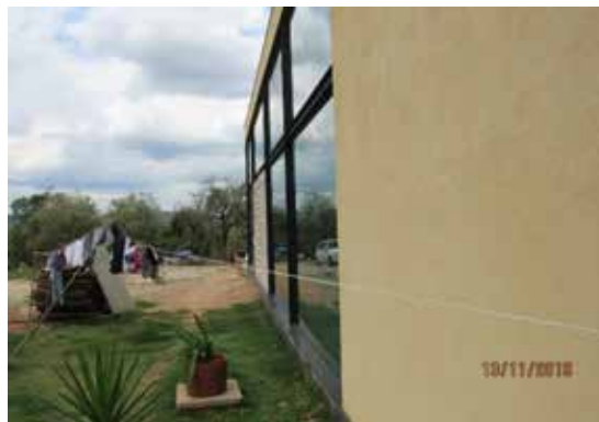
Lateral do imóvel - Vista 10
