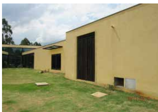
Lateral do imóvel - Vista 3
