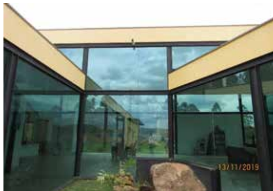
Lateral do imóvel - Vista 5
