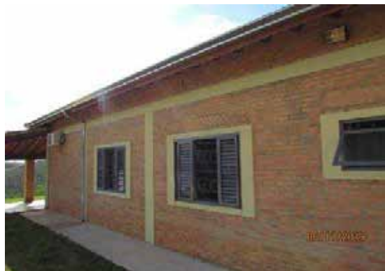
Dormitórios - Fachada fundos
