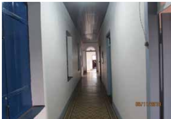
Corredor interno - Vista 01
