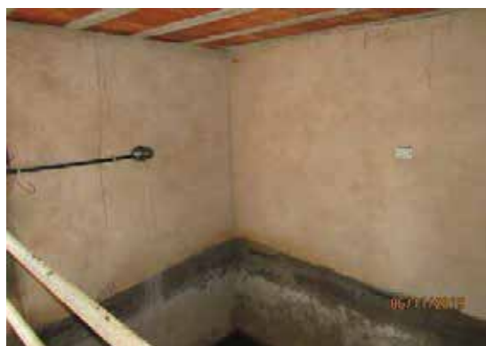
Caixa D'água - Vista 04
