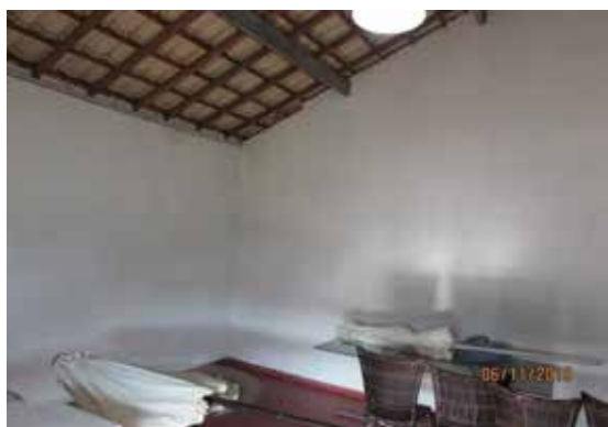
Ambiente interno 05 - Vista 01
