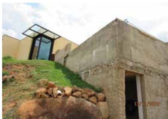
Vista lateral da casa de máquinas
