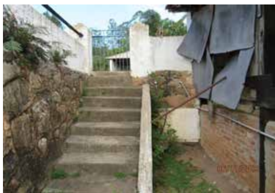
Escada de acesso
