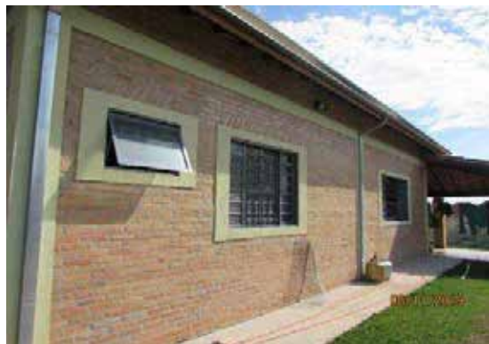
Cozinha - Fachada fundos
