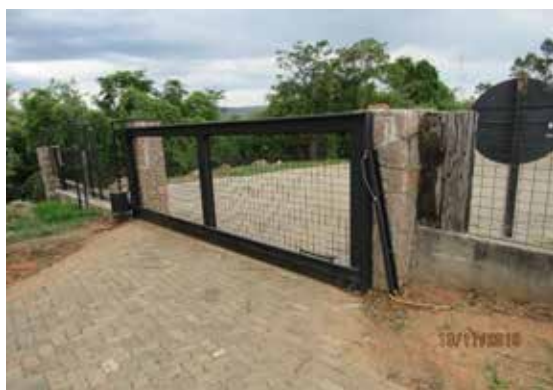
Portão de acesso - Vista ampla
