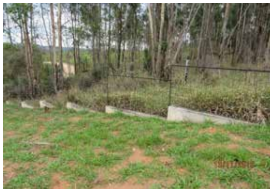
Cerca de delimitação lateral - Vista 4
