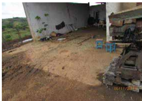
Pav. Do acesso
