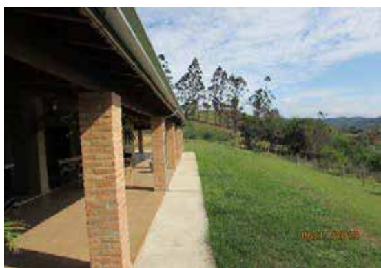
Pav. Do acesso ao Corredor externo
