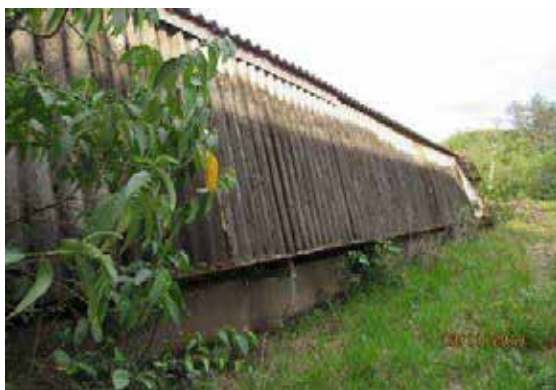
Fachada - Lateral Direita
