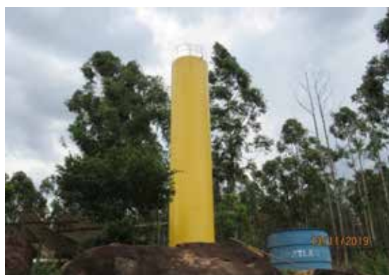
Vista da caixa de água
