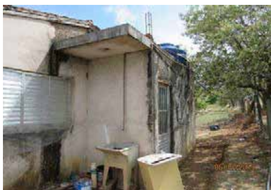
Vista à esquerda do imóvel 02
