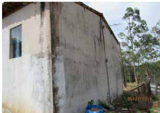
Vista à direita do imóvel
