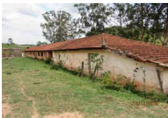
Fachada dos fundos - Vista ampla
