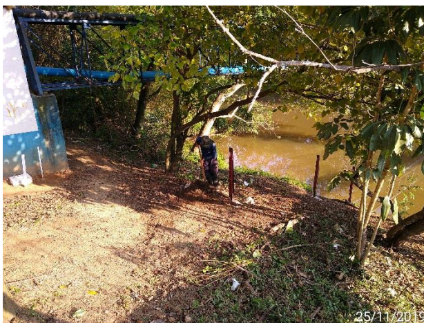
Foto 21 – Vista das atividades de limpeza da estação no PHJ -2°C (Data: 25/11/19).
