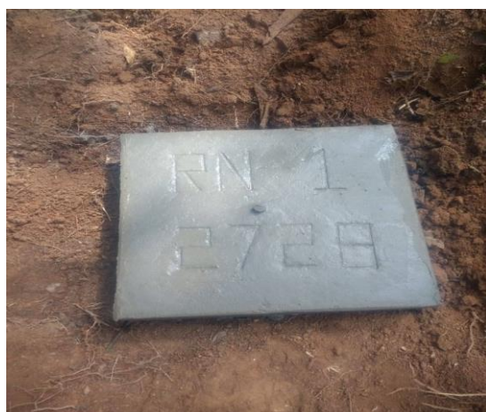
Foto 5 – Detalhe do marco de referência de nível (05/09/2019)
