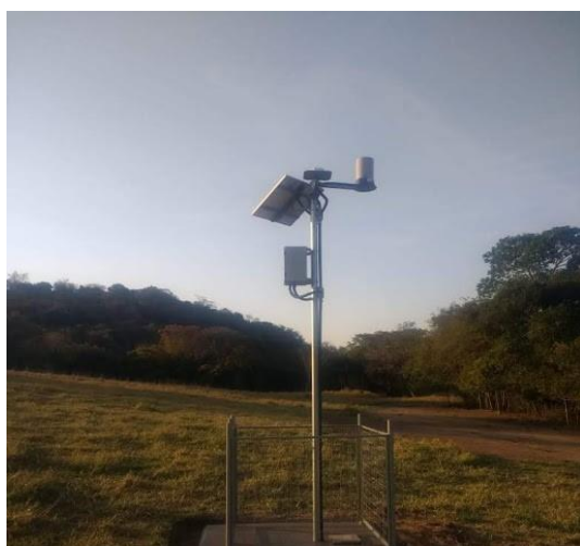
Foto 1 – Vista do Posto Hidrométrico (05/09/19).
