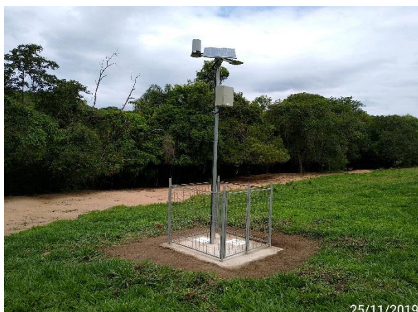
Foto 23 – Vista do PHM após a manutenção -3°C (Data:25/11/19)
