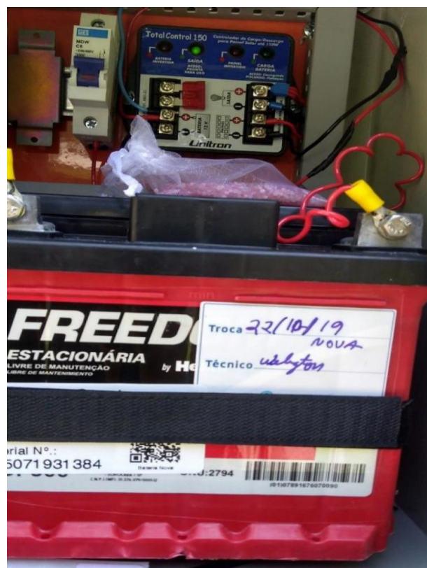
Foto 25 - Estação Telemétrica Limpa (perto)
