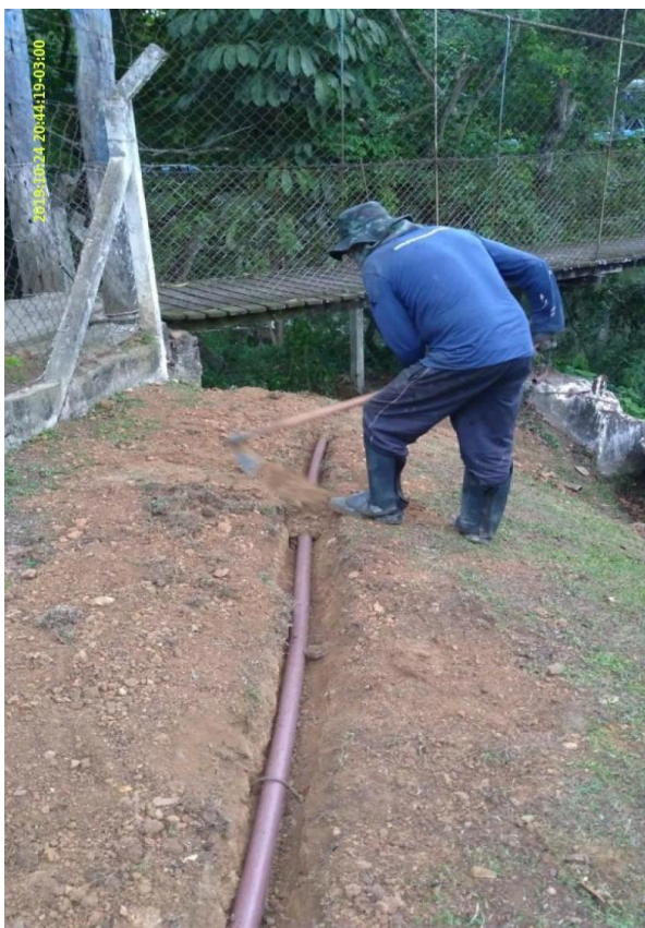
Foto 44 – Tubulação da Sonda Sendo Aterrada
