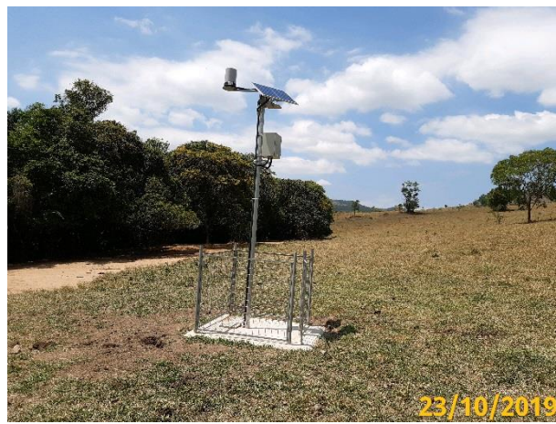
Foto 20 – Vista do PHM após a manutenção – 2°C (Data: 23/10/19)
