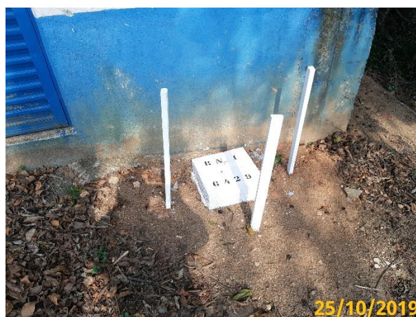
Foto 10 – Vista do referencial de nível-RN (Data: 25/10/19)
