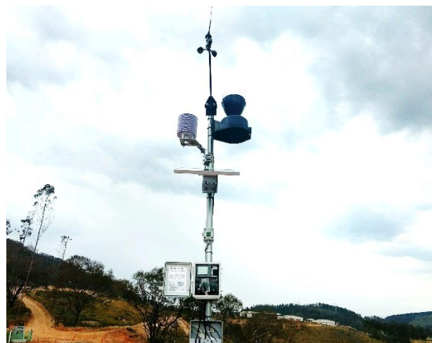
Foto 2 – Detalhe dos sensores da EMA. Foto tirada no dia da instalação – 06/09/2019.
