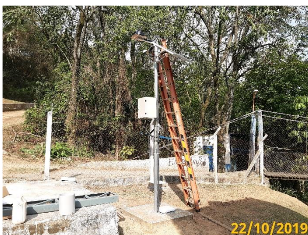
Foto 7 – Instalação dos equipamentos do PHJ na área da SAAE (Data: 22/10/19)
