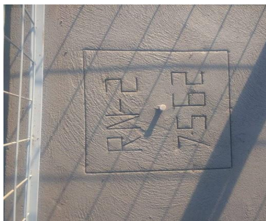
Foto 5 – Detalhe do marco de referência de nível (05/09/19).
