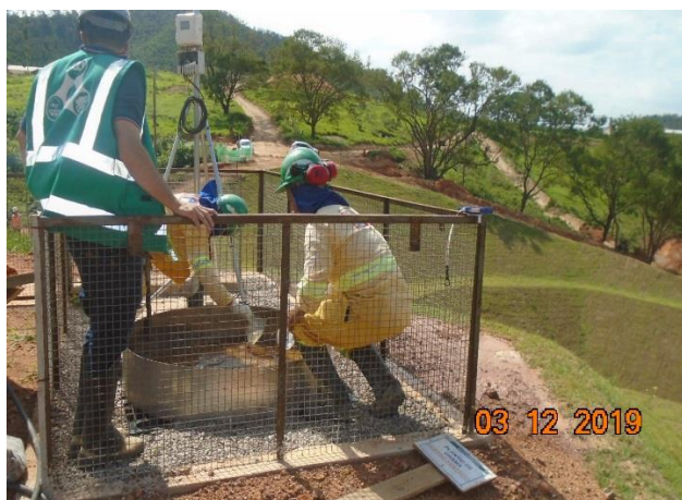
Foto 3 – Detalhe da limpeza do tanque. (Data:03/12/19)
