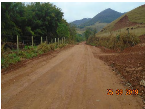
Foto 205 —Inspeção em dia de chuva na via externa próxima ao bota-fora V. (Data:25/09/19)
