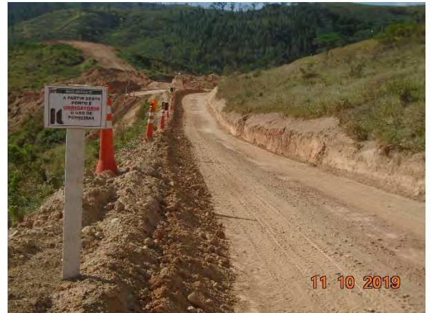
Foto 156 –Sinalização com cones na via interna, margem direita. (Data:11/10/19)
