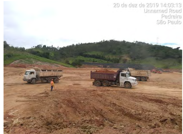
Foto 332 —Movimentação de terra próximo ao eixo do projeto. (Data:20/12/19)
