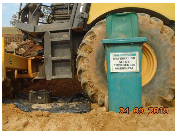
Foto 39 –Manutenção em equipamento com contenção ambiental. (Data:04/09/2019)
