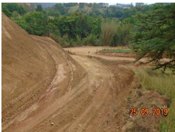
Foto 207 —Inspeção em dia de chuva no bota-fora IV. (Data:25/09/19)
