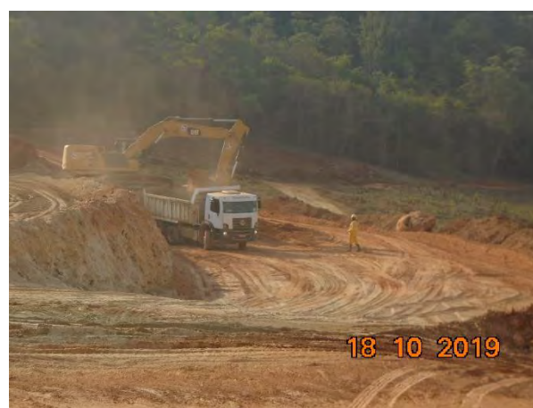
Foto 312 —Movimentação de terra na margem esquerda. (Data:18/10/19)
