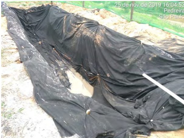
Foto 241 –Área da lavagem da calha de betoneira no canteiro operacional (Data: 22/11/19)
