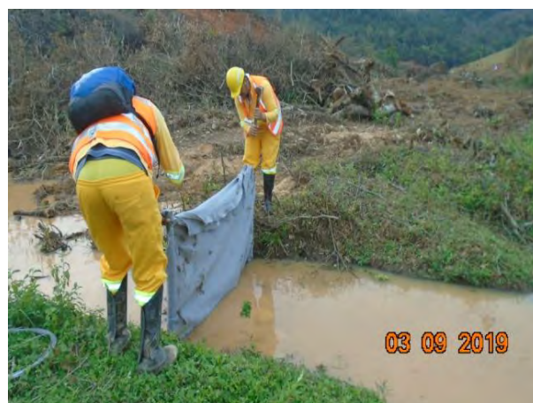
Foto 166 —Instalação de contenção ambiental na margem esquerda. (Data:03/09/19)
