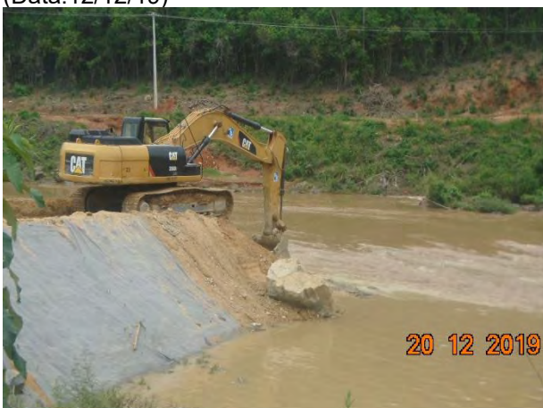
Foto 237 —Conformação de talude após chuva, ensecadeira J0. (Data:20/12/19)
