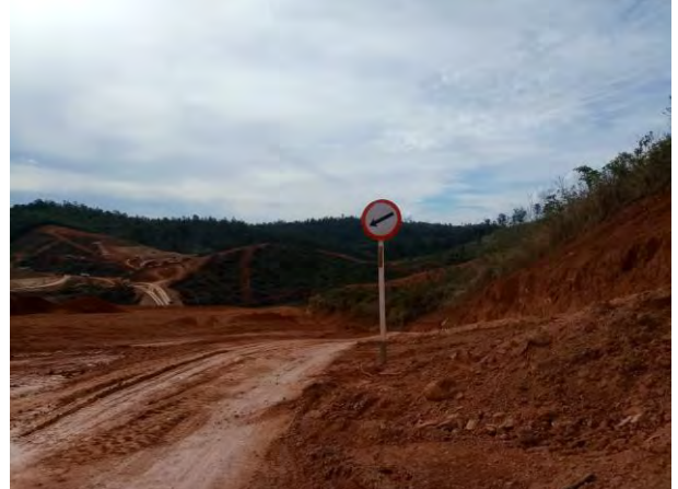
Foto 154 –Sinalização de sentido obrigatório no acesso para área do canteiro operacional (Data:04/10/19)
