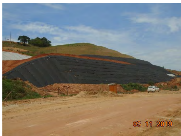
Foto 186 —Taludes do bota-espera M.D. recobertos por manta geotêxtil. (Data:05/11/19)
