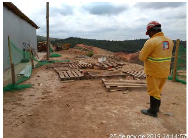
Foto 94 –Membro da CIPA realizando inspeção em campo. (Data:25/11/19)
