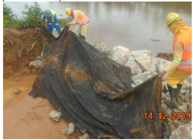
Foto 236 —Adequação de contenção na margem direita. (Data:14/12/19)
