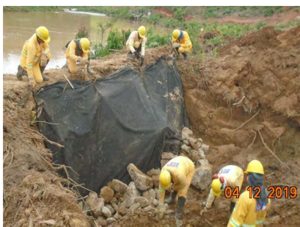
Foto 197 —Instalação de barreira de contenção na margem esquerda. (Data:04/12/19)
