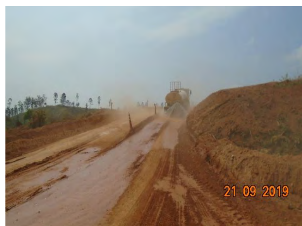
Foto 266 – Umectação nas vias internas de acesso ao canteiro operacional.
