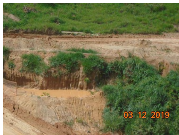
Foto 196 —Cacimba próxima ao canteiro operacional. (Data:03/12/19)
