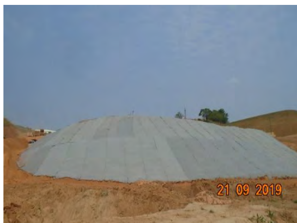
Foto 171 –Talude protegido com manta geotêxtil para evitar carreamento de sedimento/formação de erosões. (Data:21/09/19)
