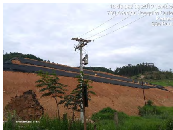
Foto 202 –Instalação de manta geotêxtil no talude do bota fora VII margem direita. (Data:18/12/19)
