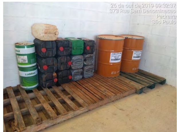
Foto 292 –Baía de resíduos perigoso no canteiro operacional. (Data:26/10/19)
