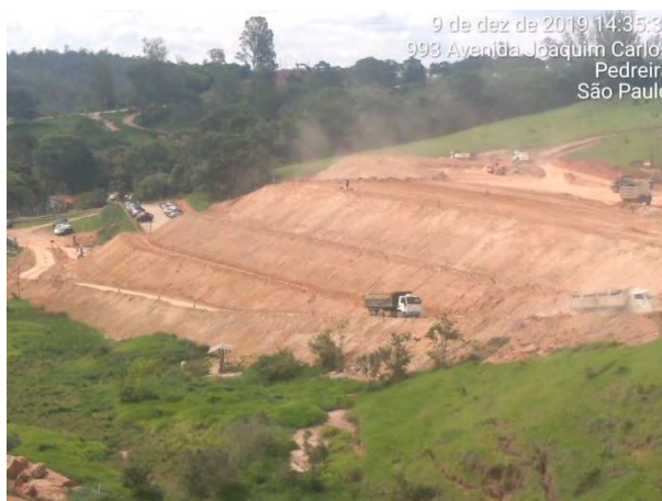
Foto 327 —Movimentação de terra no bota fora VII (Data:09/12/19)
