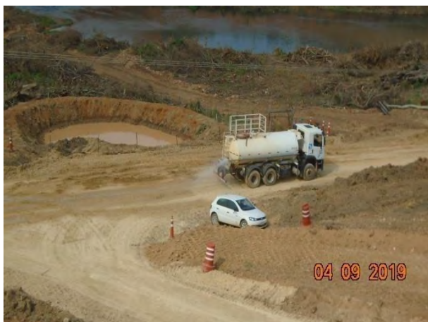
Foto 261 - Umectação das vias internas, próximo à área do eixo.
