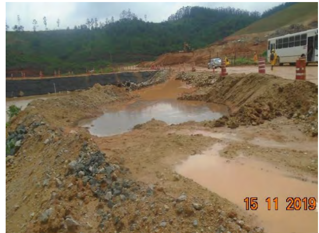
Foto 228 —Cacimbas recebendo água direcionada das áreas a jusante, retendo material da margem direita. (Data:15/11/19)
