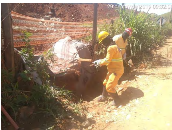
Foto 231 —Regularização de contenção. (Data:29/11/19)
