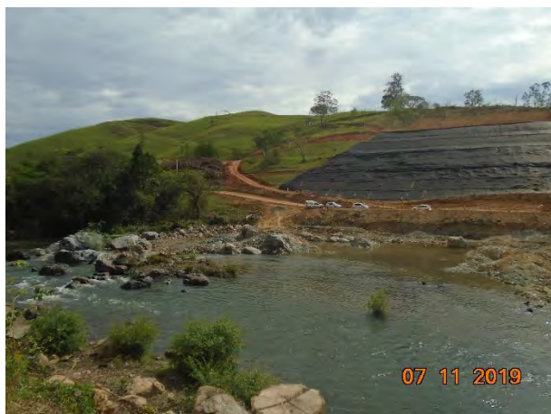
Foto 101 –Área antes da detonação. (Data:07/11/19)
