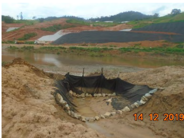
Foto 201 –Talude de corte na margem esquerda, gramado. (Data:14/12/19)
