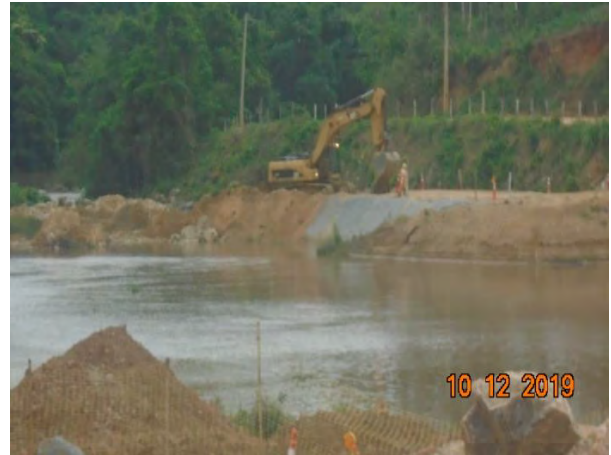
Foto 234 —Conformação de talude após erosões de chuva na passagem molhada na margem direita. (Data: 10/12/19)
