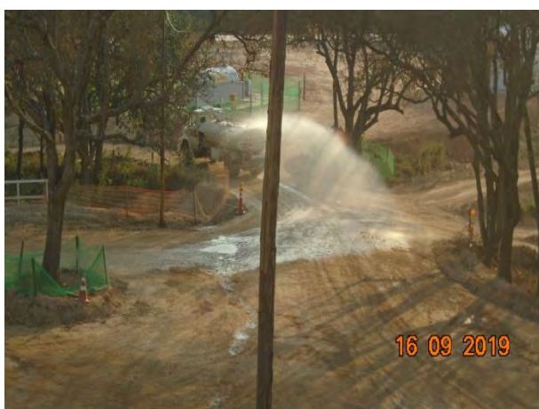
Foto 265 – Umectação nas vias internas de acesso ao canteiro operacional.
