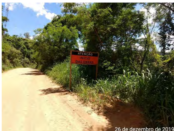
Foto 151 –Sinalização de início de obras na estrada municipal de Pedreira. (Data:26/12/19)
