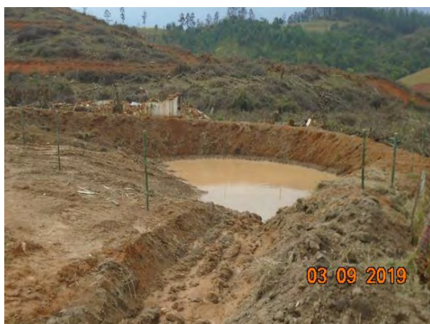
Foto 165 —Cacimba instalada na margem esquerda. (Data:03/09/19)
