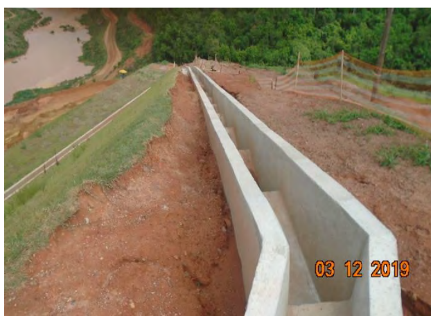
Foto 195 —Escada hidráulica instalada no talude de corte da margem direita. (Data:03/12/19)
