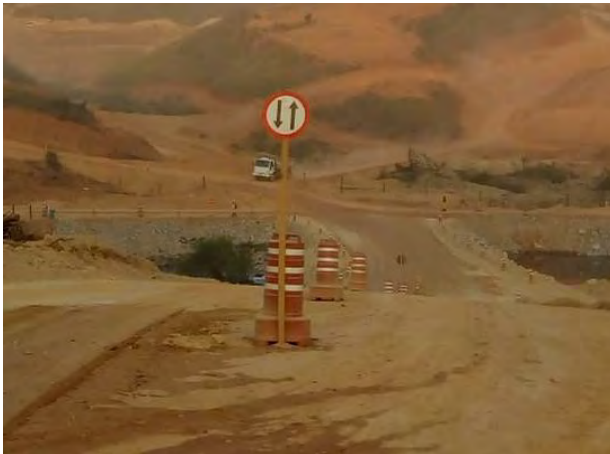
Foto 155 –Sinalização demonstrando sentido da via na passagem molhada. (Data:11/10/19)
