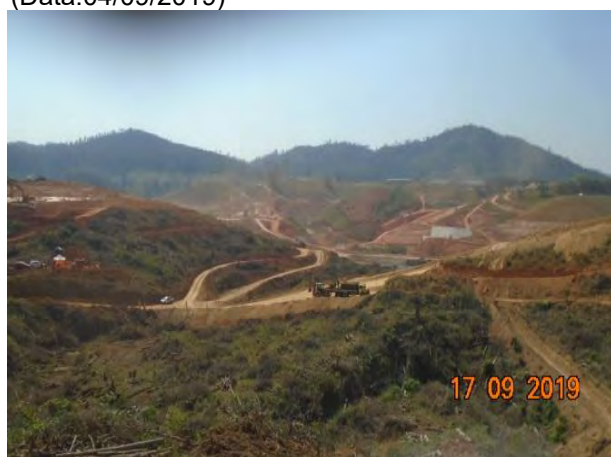
Foto 303 –Movimentação de terra na margem direita. (Data:17/09/2019)
