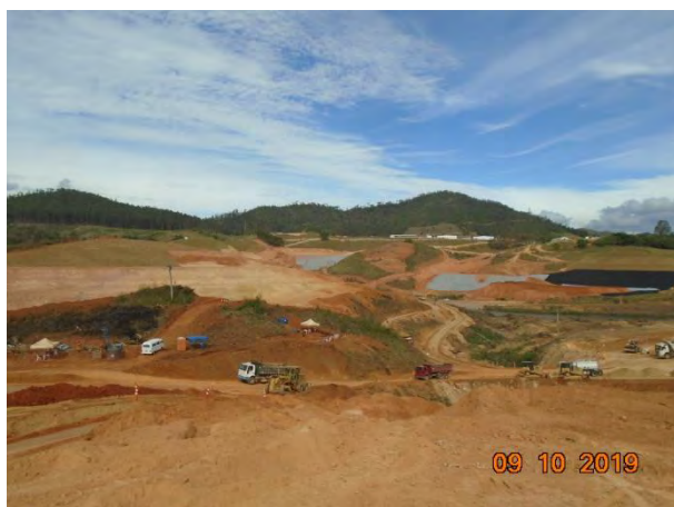
Foto 309 —Movimentação de terra no empreendimento, margem esquerda. (Data:09/10/19)
