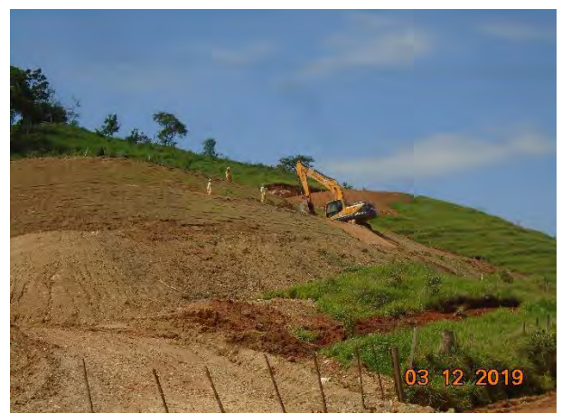
Foto 232 —Correção de talude no bota fora IV após chuva, margem direita. (Data:03/12/19)
