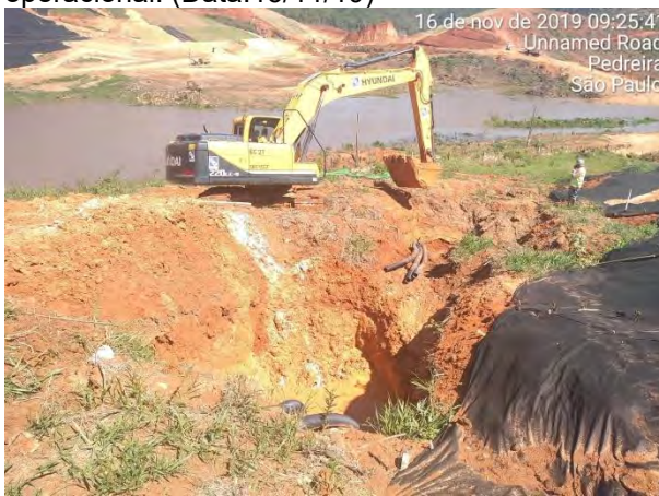
Foto 229 —Cacimba com recebendo águas da chuvas do direcionamento no acesso do canteiro operacional. (Data:15/11/19)
