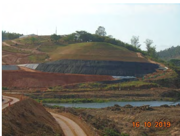
Foto 177 –Manta geotêxtil instalada no talude do bota-espera do núcleo, na margem direita. (Data:16/10/19)
