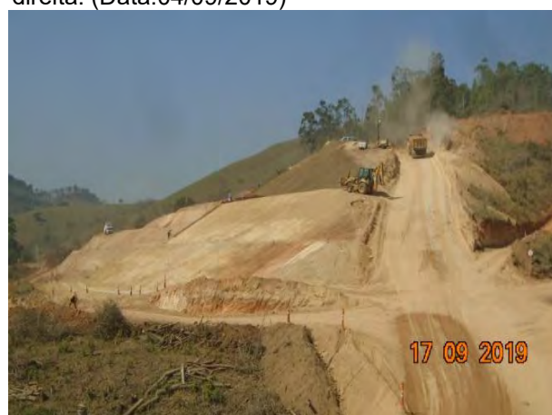
Foto 304 –Movimentação de terra na margem esquerda. (Data:17/09/2019)
