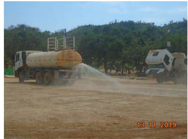
Foto 268 —Umectação de vias internas. (Data:13/11/19)
