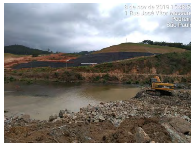
Foto 318 —Movimentação de terra na margem esquerda próximo a área do eixo (Data:08/11/19)
