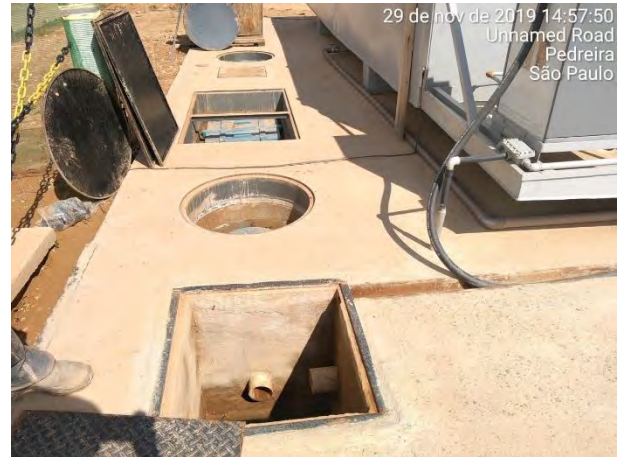
Foto 242 –Inspeção na caixa SAO localizada no posto de abastecimento do canteiro operacional. (Data:29/11/2019)
