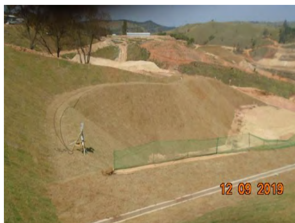
Foto 169 —Talude de corte na margem direita gramado. (Data:12/09/19)
