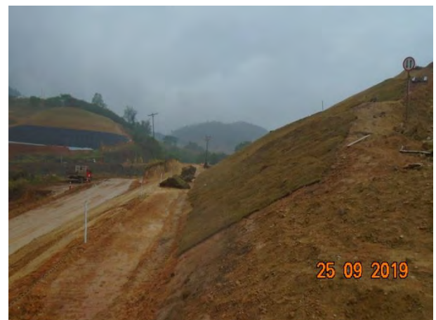
Foto 214 —Inspeção em dia de chuva no talude de corte na margem esquerda. (Data:25/09/19)
