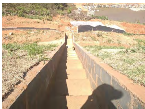
Foto 193 –Escada hidráulica instalada no talude de corte da M.D. (Data:16/11/19)
