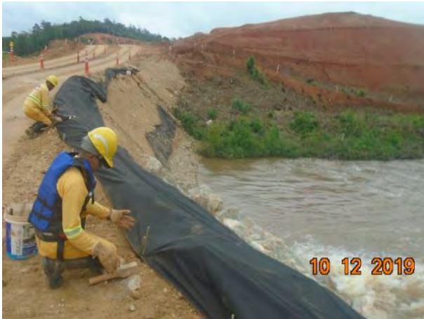
Foto 233 —Recolocação de manta geotêxtil no talude da passagem molhada. (Data:10/12/2019)
