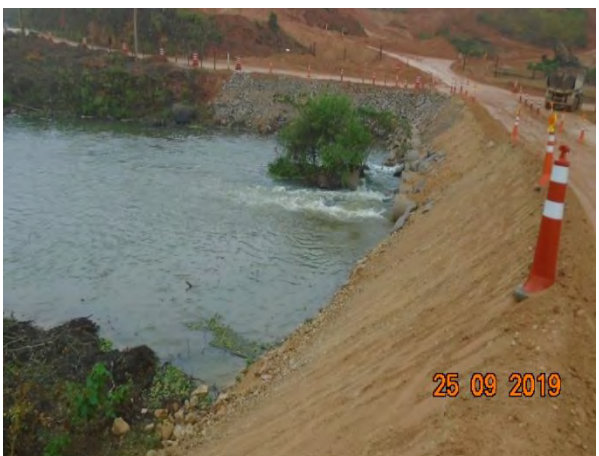
Foto 213 —Inspeção em dia de chuva na passagem molhada. (Data:25/09/19)
