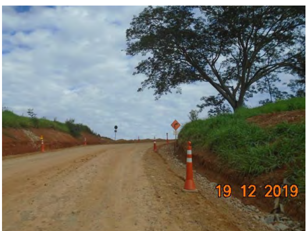
Foto 162 –Sinalização com cones na via de acesso ao canteiro operacional. (Data:19/12/19)
