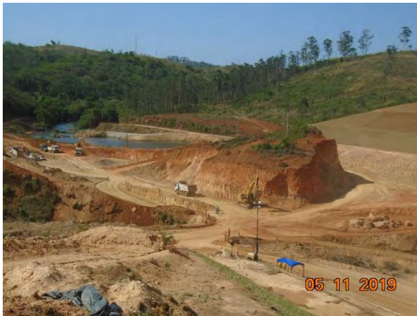
Foto 319 —Movimentação de terra no empreendimento, margem esquerda. (Data:05/11/19)
