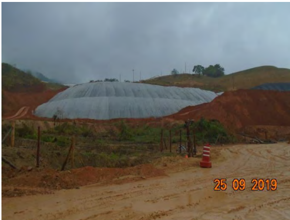
Foto 211 —Inspeção em dia de chuva nos bota-espera margem direita, cobertos por manta geotêxtil. (Data:25/09/19)
