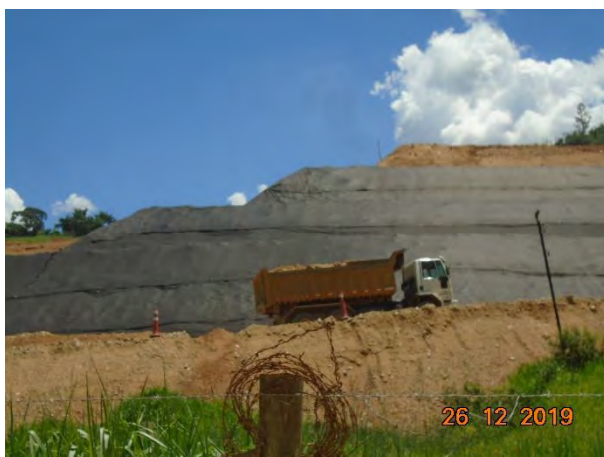
Foto 335 —Movimentação de terra no bota fora III, margem direita. (Data:26/12/19)
