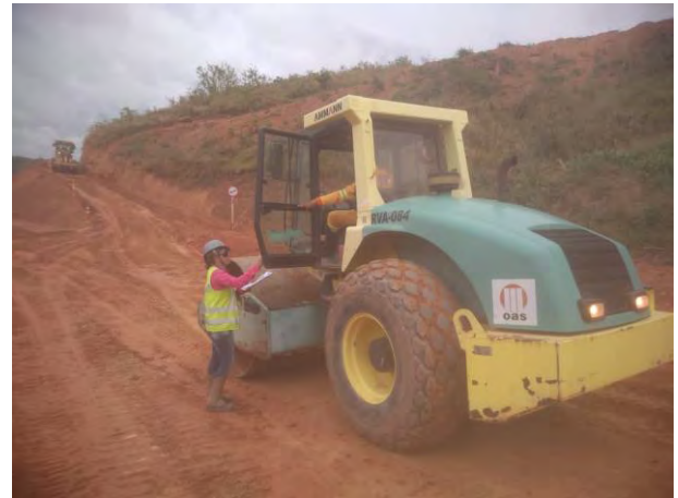
Foto 84 –Técnica de segurança realizando inspeção em rolo compactador. (Data:08/11/19)
