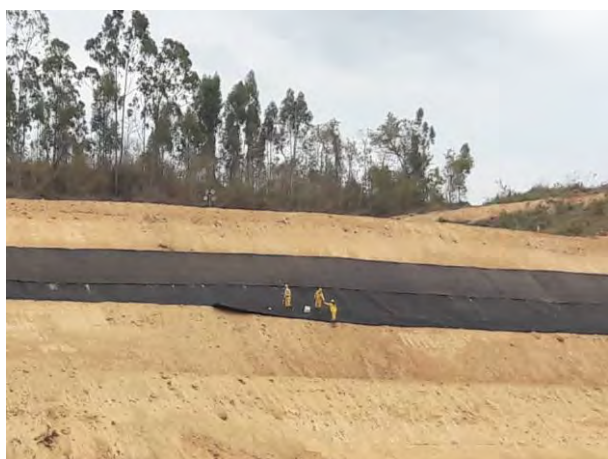
Foto 173 –Instalação de manta geotêxtil no talude do bota-fora 1 da margem esquerda. (Data:09/10/19)
