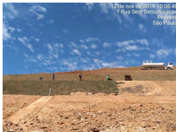
Foto 192 –Aplicação de grama no talude de corte M.E. (Data:12/11/19)
