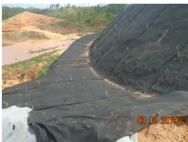
Foto 199 —Taludes do bota-espera da margem direita recobertos por manta geotêxtil. (Data:03/12/19)
