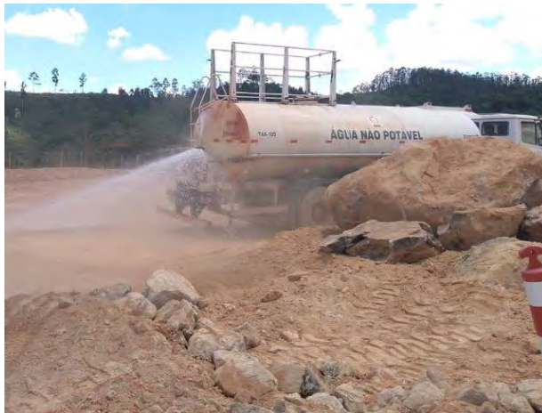
Foto 269 —Umectação de vias internas. (Data:18/12/19)
