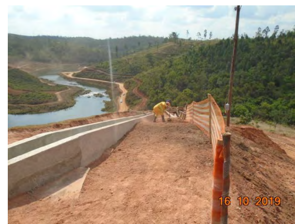
Foto 176 –Drenagem definitiva para escoamento de água pluvial. (Data: 16/10/19)
