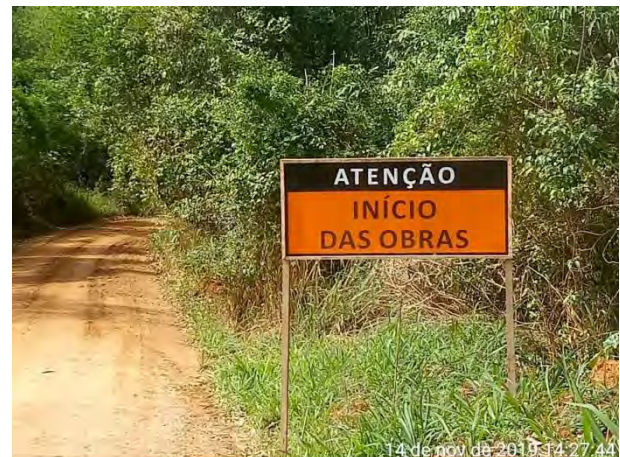
Foto 146 –Sinalização de início de obra. (Data: 14/11/19)
