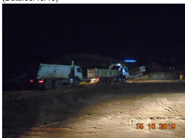
Foto 311 —Movimentação de terra segundo turno margem esquerda. (Data:15/10/19)
