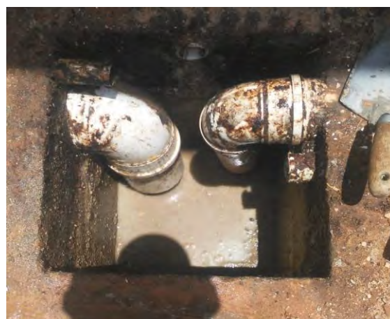
Foto 258 —Caixa de gordura do canteiro operacional após limpeza. (Data:29/11/2019)
