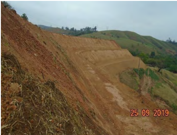
Foto 209 —Inspeção em dia de chuva no bota-fora III. (Data:25/09/19)
