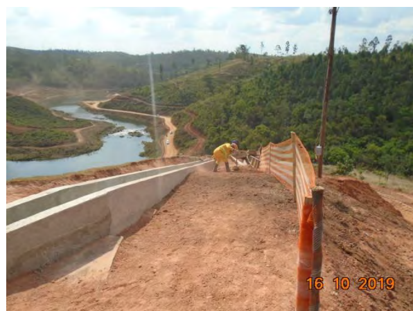
Foto 180 –Drenagem definitiva para escoamento de água pluvial. (Data:16/10/19)
