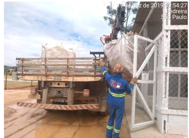
Foto 300 —Retirada de resíduos para serem encaminhados à reciclagem na Cooperativa Eco Pedreira. (Data:19/12/19)
