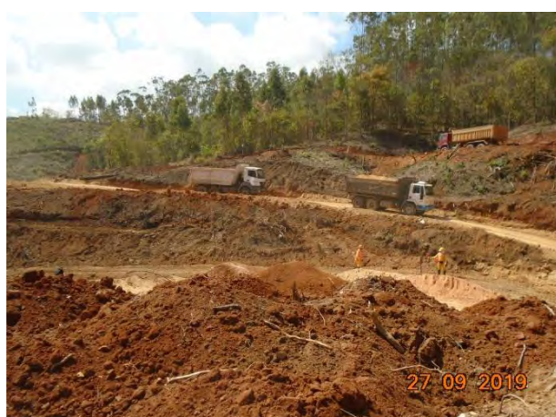
Foto 305 –Movimentação de terra na margem esquerda. (Data:27/09/2019)
