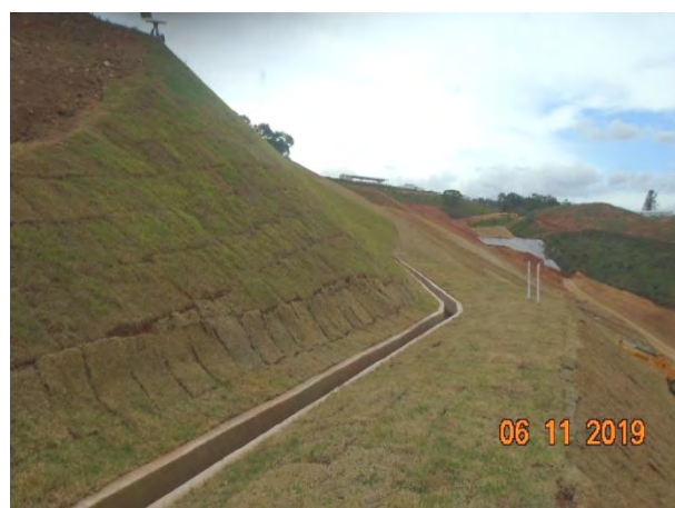
Foto 190 –Registro de drenagem definitiva para água pluvial na margem direita. (Data:06/11/2019)
