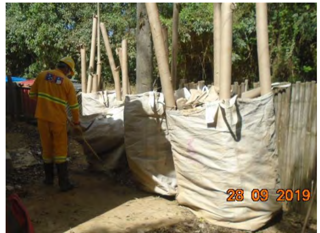
Foto 50 —Limpeza e organização na área de armazenamento temporário de resíduos sólidos.
