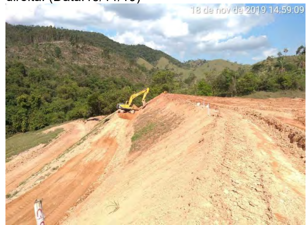
Foto 230 —Conformação de talude após erosões de chuva no bota-fora III M.D. (Data:18/11/19)
