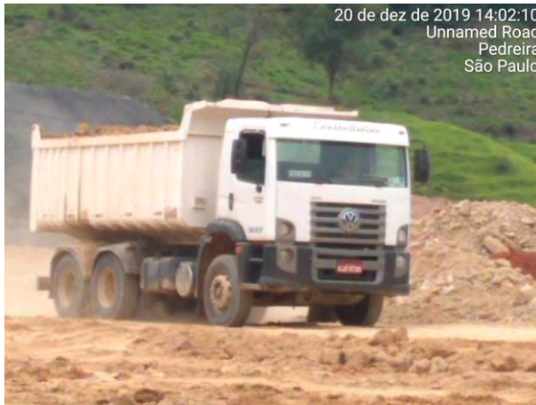
Foto 331 —Movimentação de terra na margem esquerda. (Data:20/12/19)
