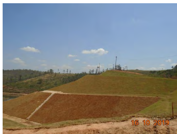
Foto 178 –Grama aplicada no talude de corte da margem direita. (Data:16/10/19)
