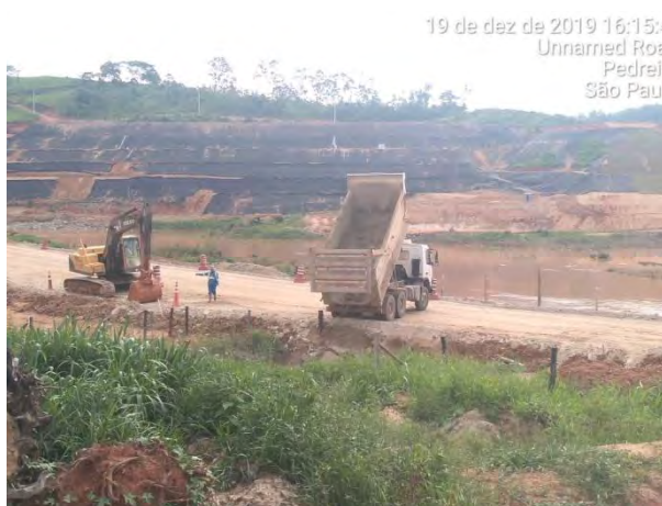
Foto 329 —Movimentação de terra na área do eixo. (Data:19/12/19)
