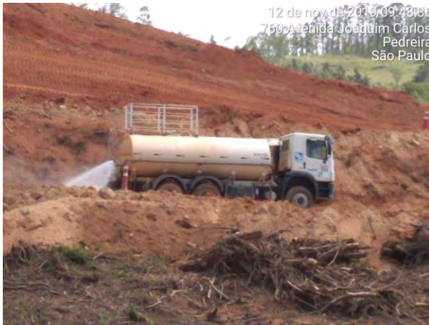
Foto 267 —Umectação de vias internas. (Data:12/11/19)
