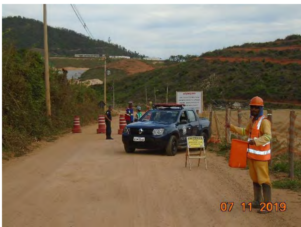
Foto 99 —Bloqueio temporário. (Data:07/11/19)
