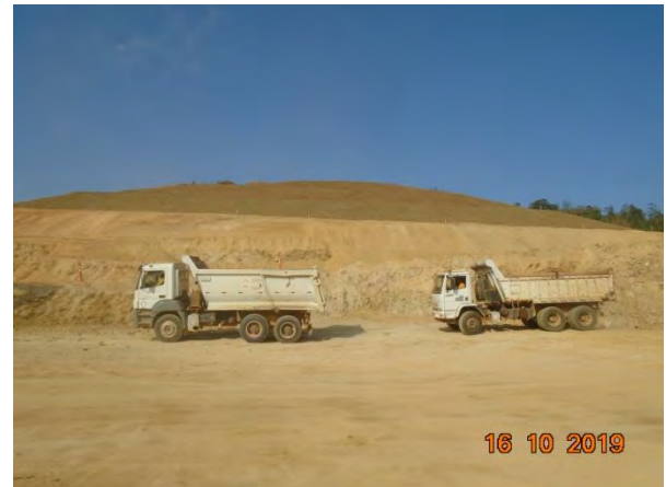
Foto 314 —Movimentação de terra próximo a área do eixo na margem direita. (Data: 16/10/19)
