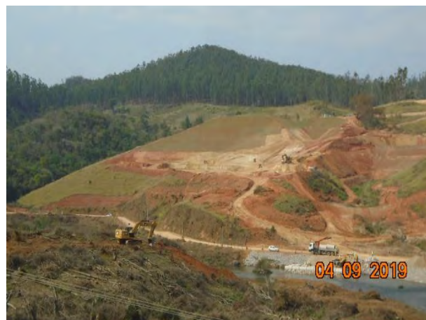
Foto 302 –Movimentação de terra na margem direita. (Data:04/09/2019)
