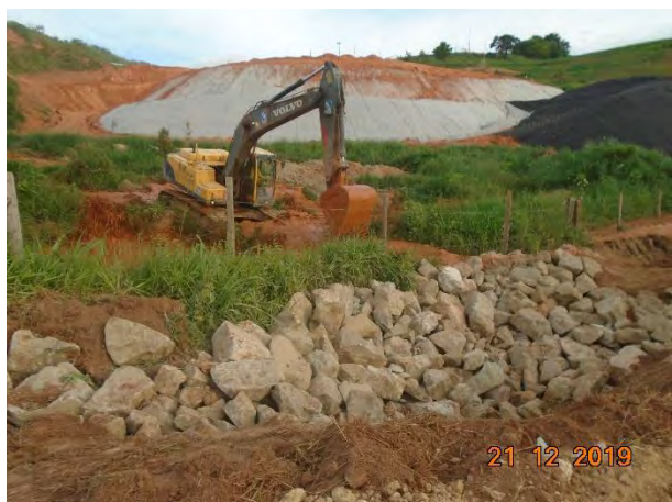
Foto 238 —Limpeza de cacimba na margem esquerda, próxima a estrada municipal de Pedreira. (Data:21/12/19)
