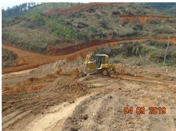
Foto 301 –Terraplenagem na margem esquerda. (Data:04/09/2019)
