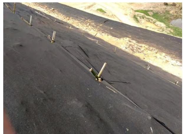
Foto 70 —Bambu sendo utilizado para fixar a manta geotêxtil nos taludes. (Data:19/11/19)
