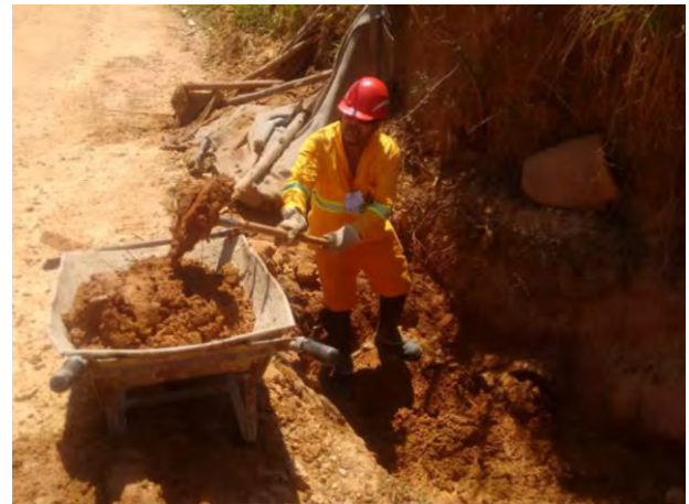
Foto 222 –Limpeza da drenagem da via, após chuva. (Data:29/10/19)
