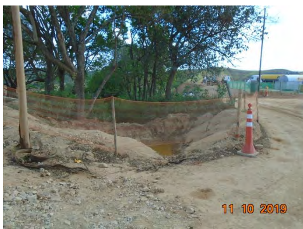
Foto 175 –Cacimba próximo ao canteiro operacional. (Data:11/10/19)
