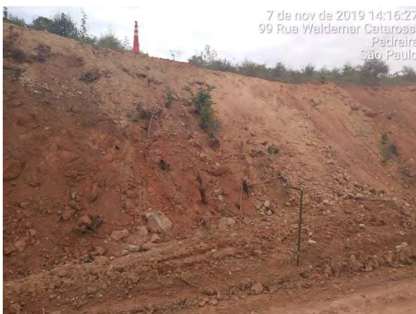
Foto 225 –Talude de acesso para bota-fora II M.E. corrigido. (Data:07/11/2019)
