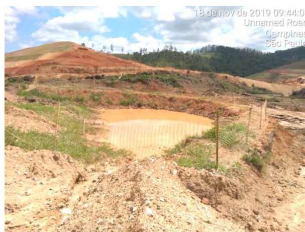
Foto 194 –Cacimba contendo material carreado com a chuva na margem esquerda. (Data:18/11/2019)
