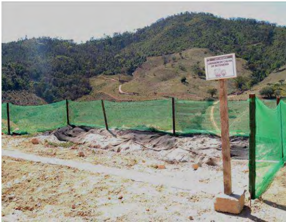
Foto 243 –Área de lavagem da calha do caminhão betoneira. (Data:07.12.2019)
