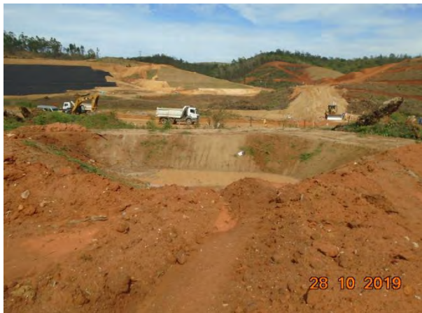
Foto 315 —Movimentação de terra na margem esquerda próximo a área do eixo (Data: 28/10/19)
