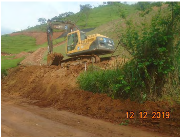
Foto 235 —Adequação de curva de nível após chuva no bota fora V da margem direita. (Data:12/12/19)
