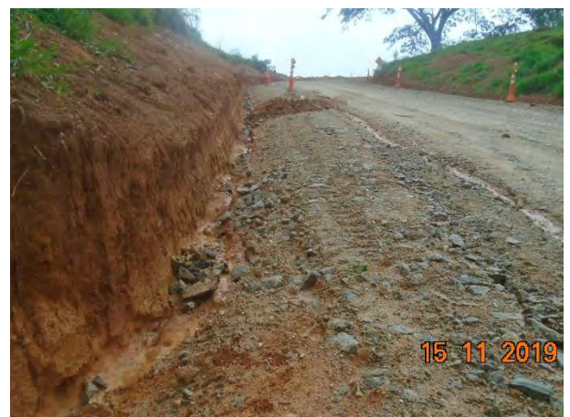
Foto 226 –Drenagem provisória, direcionamento de água para cacimba no acesso ao canteiro operacional. (Data:15/11/19)
