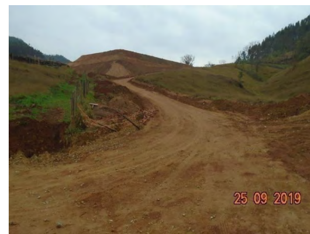
Foto 208 —Inspeção em dia de chuva no bota-fora III. (Data:25/09/19)
