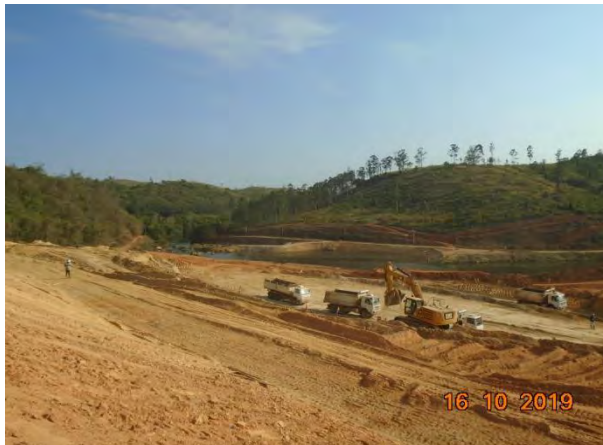
Foto 313 —Movimentação de terra próximo a área do eixo na margem esquerda. (Data:16/10/19)
