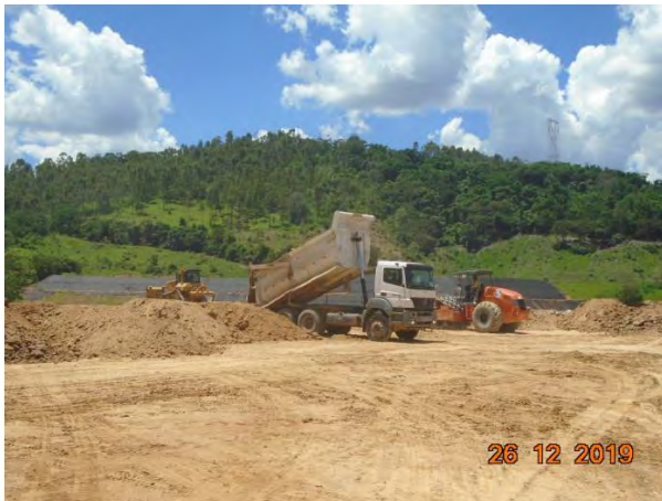
Foto 333 —Movimentação de terra no bota fora IV. (Data:26/12/19)
