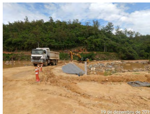
Foto 330 —Movimentação de terra na enseadeira J0. (Data:19/12/19)
