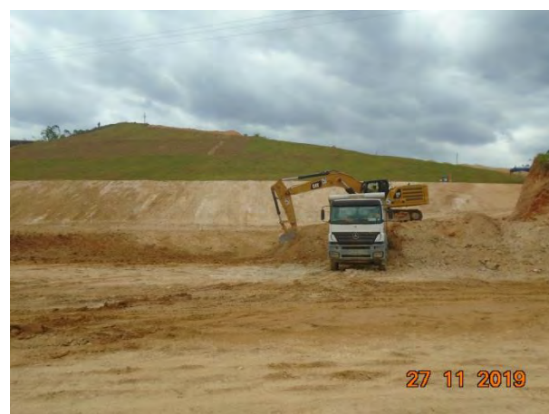
Foto 326 —Movimentação de terra na margem direita, próximo à área do eixo. (Data:27/11/19)
