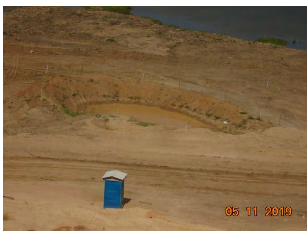
Foto 183 —Cacimba próxima ao canteiro operacional. (Data:05/11/19)
