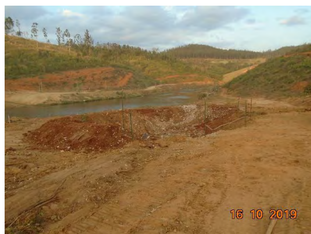
Foto 216 –Cacimba instalada a margem esquerda. (Data:16/10/19)
