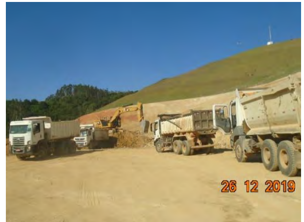
Foto 334 —Movimentação de terra próximo ao eixo do projeto, margem direita. (Data:26/12/19)
