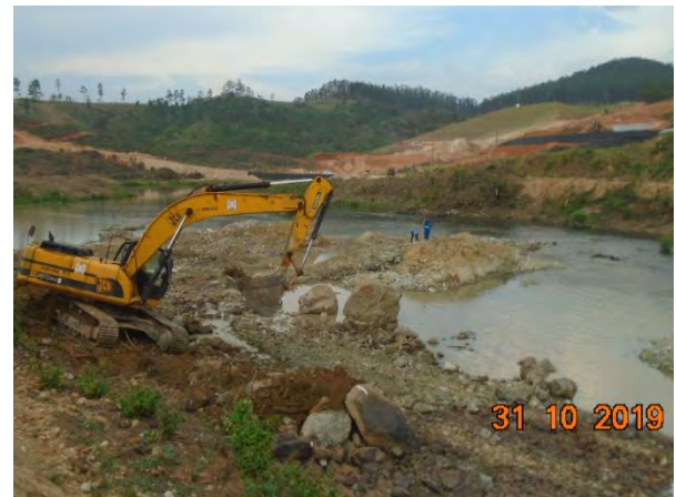
Foto 316 —Movimentação de terra na margem esquerda próximo a área do eixo (Data: 31/10/19)
