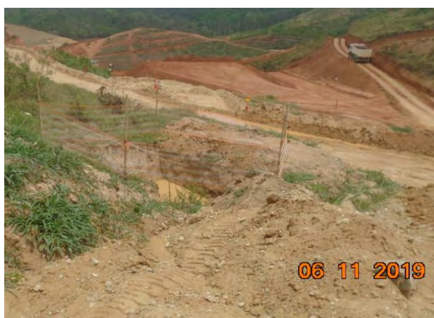
Foto 189 –Cacimba na margem esquerda, próximo ao bota-espera. (Data:06/11/19)
