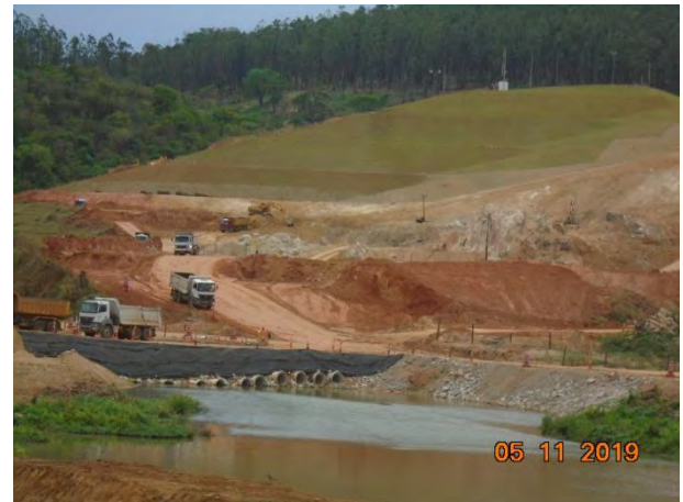
Foto 320 —Movimentação de terra no empreendimento, bota-espera colúvio margem direita. (Data:05/11/19)
