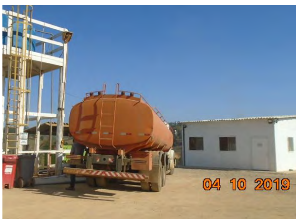
Foto 59 –Abastecimento de água potável no canteiro operacional. (Data:04/10/19)
