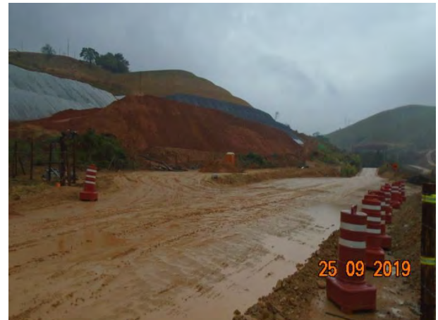
Foto 212 —Inspeção em dia de chuva no bota-espera margem direita. (Data:25/09/19)
