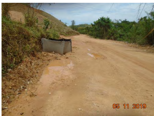
Foto 181 –Instalação de manta geotêxtil na margem direita do Rio Jaguari, próximo ao pátio de toras. (Data:05/11/19)
