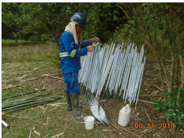
Foto 69 —Uso de bambu para marcações topográficas. (Data:08/11/19)
