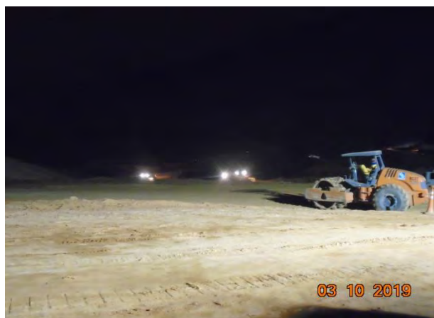
Foto 307 —Movimentação de terra do segundo turno bota-fora II margem direita. (Data: 03/10/19)
