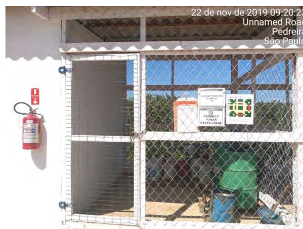
Foto 36 –Baia de produtos químicos no pátio de manutenção de equipamentos. (Data: 22/11/19)
