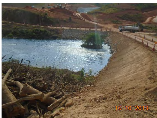
Foto 215 –Talude conformado após chuva. (Data:16/10/19)
