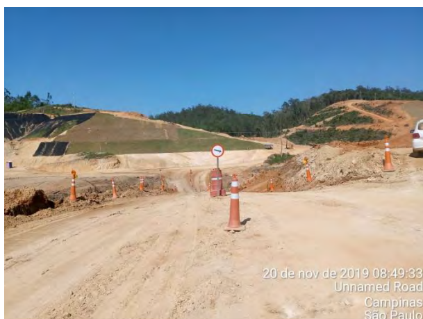
Foto 159 –Sinalização de direção na via interna na área do eixo. (Data: 20/11/19)
