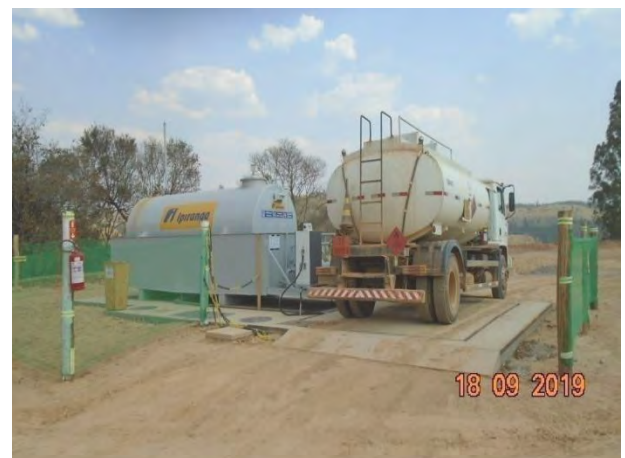
Foto 32 –Posto de abastecimento no canteiro operacional. (Data:18/09/19)
