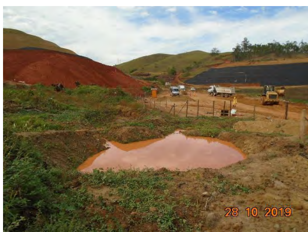
Foto 219 –Cacimba contendo material carreado com a chuva na margem direita. (Data:28/10/19)
