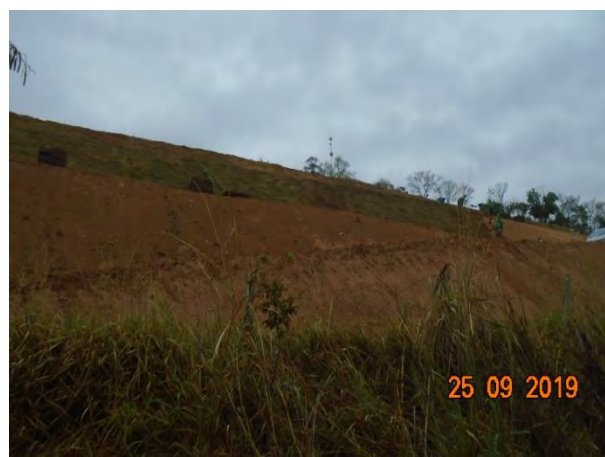
Foto 204 —Inspeção em dia de chuva no bota-fora V. (Data:25/09/19)
