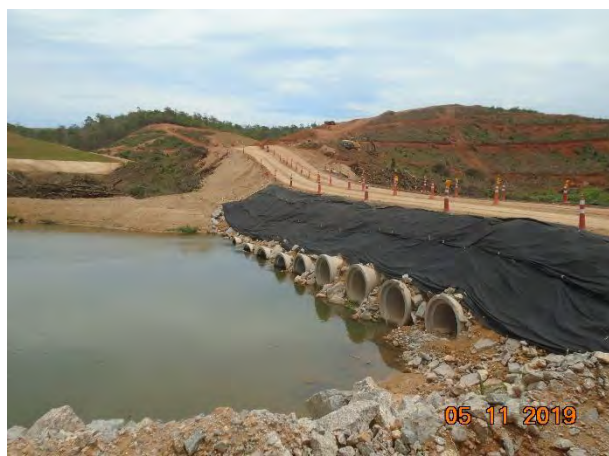
Foto 185 —Talude da passagem molhada recoberto por manta geotêxtil. (Data:05/11/19)
