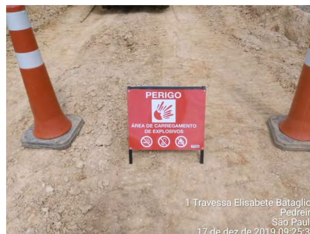
Foto 106 –Isolamento de área durante carregamento de explosivos. (Data:17/12/19)
