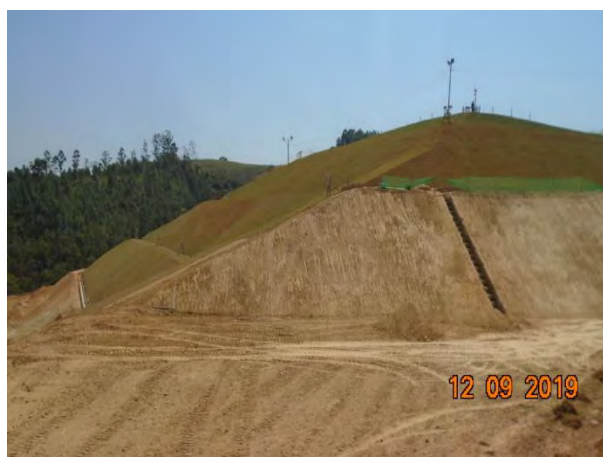
Foto 170 —Talude de corte na margem direita gramado e com drenagem implantada. (Data:12/09/19)
