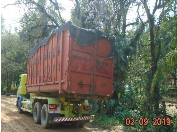
Foto 285 —Registro da troca de caçamba de madeira. (Data:02/09/2019)
