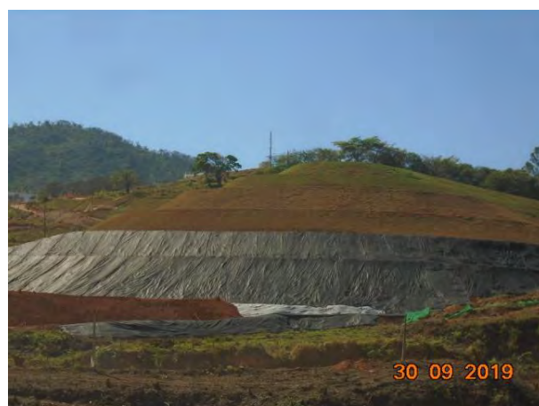
Foto 172 –Talude protegido com manta geotêxtil para evitar carreamento de sedimento/formação de erosões. (Data:30/09/19)
