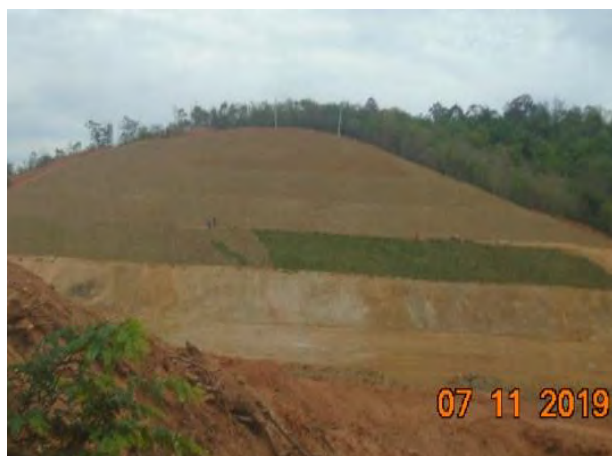
Foto 191 –Grama aplicada no talude de corte da margem esquerda. (Data:07/11/19)
