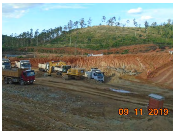
Foto 325 —Movimentação de terra na margem esquerda, próximo à área do eixo. (Data:09/11/19)
