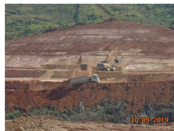
Foto 306 –Movimentação de terra na margem esquerda. (Data:30/09/2019)
