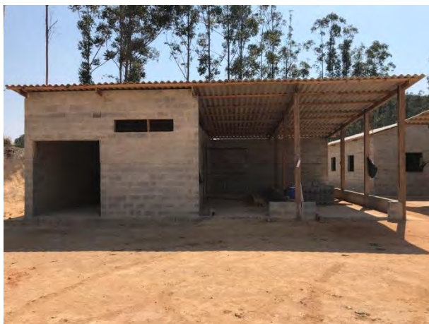
Foto 287 —Baía de resíduos em construção no canteiro operacional. (Data:10/09/2019)
