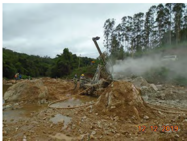
Foto 104 –Perfuração nas rochas para carregamento de explosivos na ensecadeira J0. (Data:12/12/19)
