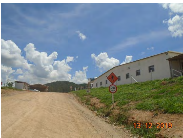
Foto 161 –Sinalização de velocidade máxima permitida na via do canteiro operacional. (Data:13/12/19)
