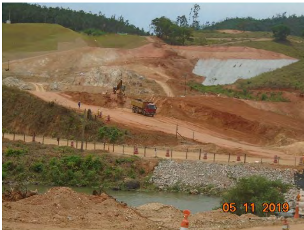
Foto 321 —Movimentação de terra próximo à área do eixo na margem direita. (Data:05/11/19)
