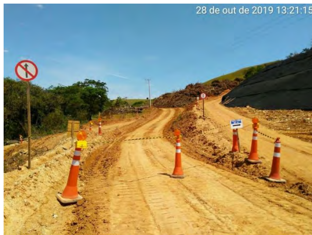
Foto 157 –Sinalização com cones na via interna da margem esquerda. (Data:28/10/19)
