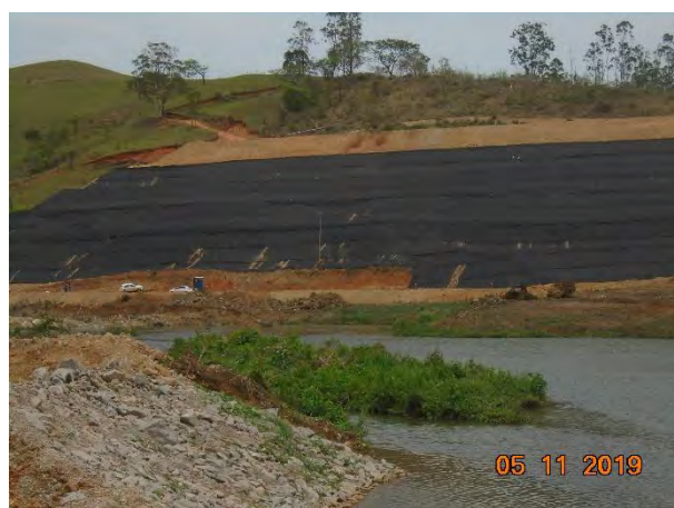
Foto 184 —Taludes do bota-fora 1 M.E. recobertos por manta geotêxtil. (Data:05/11/19)
