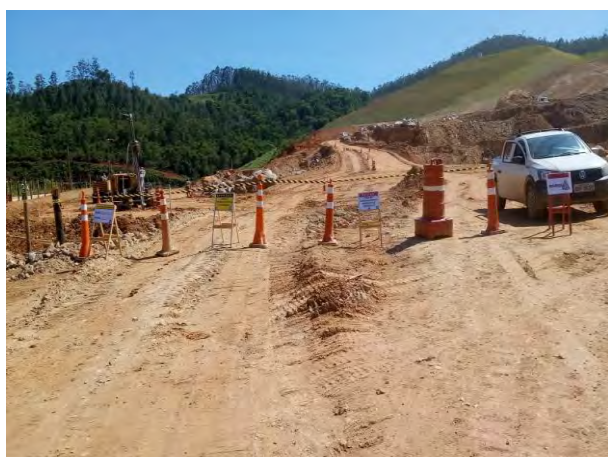
Foto 103 –Isolamento de área durante carregamento de explosivos. (Data:29/11/19)
