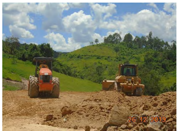
Foto 336 —Movimentação de terra próximo ao eixo do projeto. (Data:26/12/19)
