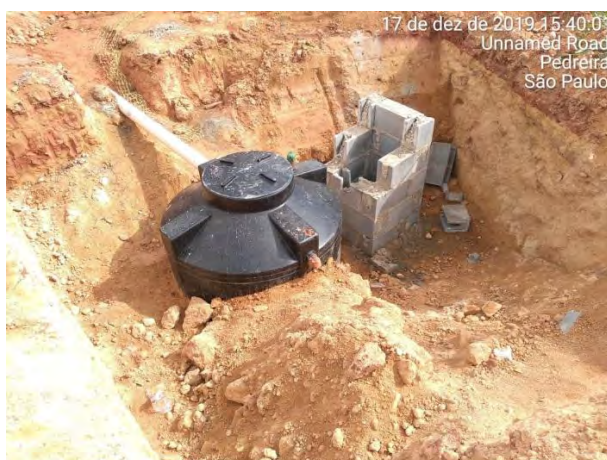
Foto 259 —Instalação de biodigestor no pátio de manutenção. (Data:17/12/19)
