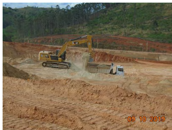
Foto 308 —Movimentação de terra bota-fora II margem direita (Data: 09/10/19)
