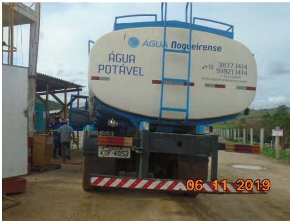
Foto 61 —Abastecimento de água potável no canteiro operacional. (Data:06/11/19)
