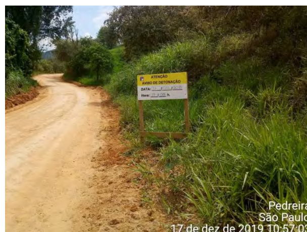
Foto 105 –Placa informativa sobre a atividade de desmonte de rocha na estrada municipal de Pedreira. (Data:17/12/19)
