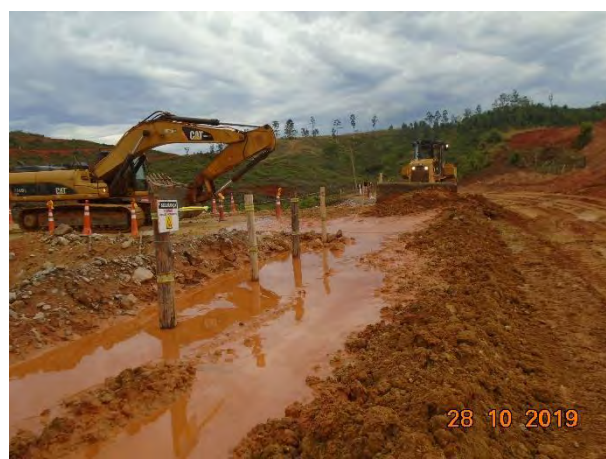
Foto 218 –Via sendo conformada após chuva. (Data: 28/10/19)
