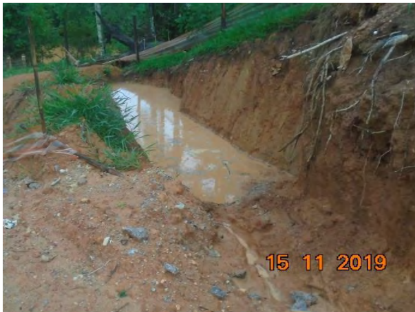
Foto 227 —Cacimba com recebendo águas da chuvas do direcionamento no acesso do canteiro operacional. (Data:15/11/19)
