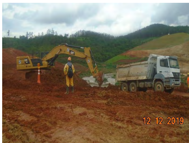
Foto 328 —Movimentação de terra na margem esquerda. (Data:12/12/19)
