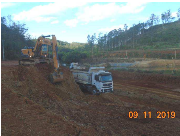
Foto 323 —Movimentação de terra próximo a ensecadeira J0 na margem esquerda. (Data:09/11/19)
