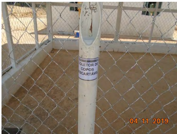
Foto 293 – Coletor para copos plásticos instalado no canteiro industrial. (Data:11/10/19)
