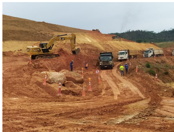
Foto 24- Novembro: escavação do canal de desvio
