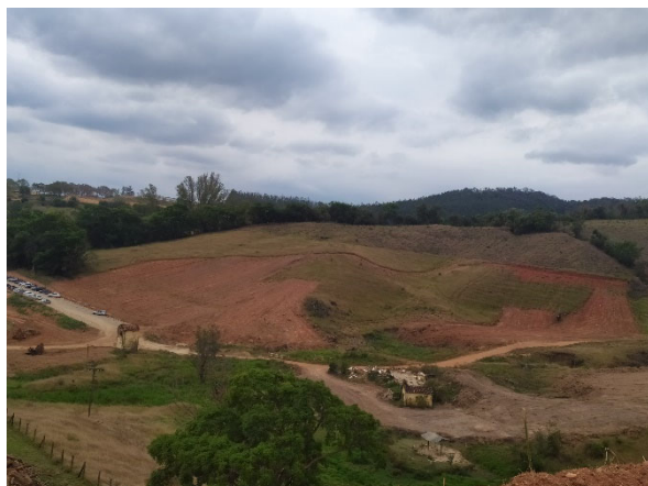
Foto 11 – Outubro: estacionamento dos funcionários e futuro bota-fora 7 na margem direita
