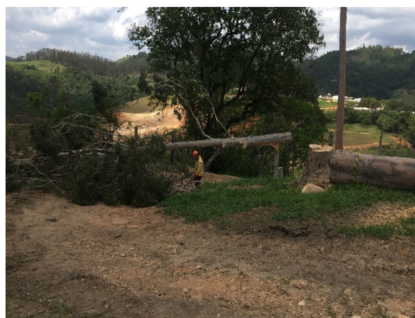
Foto 34: Avanço da Supressão vegetal (06/12/2019)
