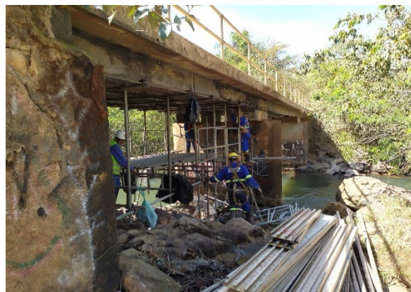
Foto 4- Setembro: manutenção da ponte de acesso entre as margens
