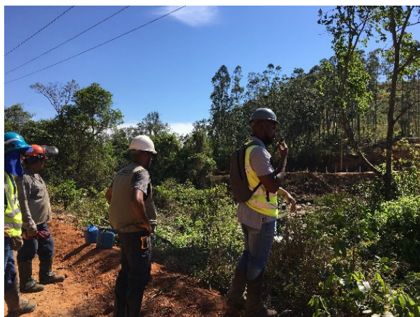
Foto 29: Avanço da Supressão vegetal (11/10/2019)
