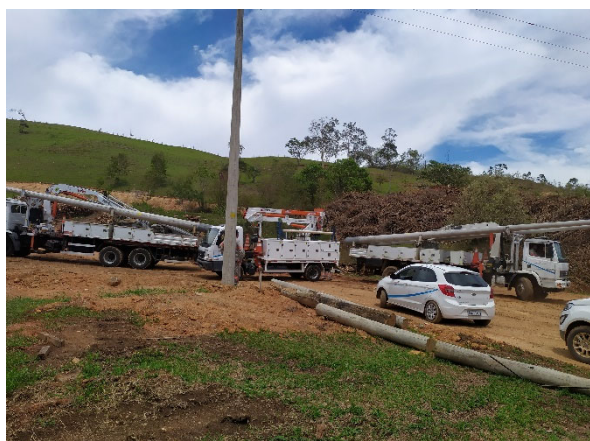
Foto 17- Novembro: remanejamento da rede elétrica de baixa tensão (CPFL)
