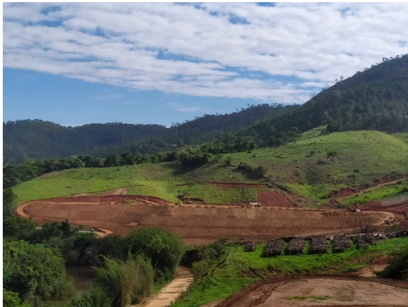
Foto 21- Novembro: bota-fora 7 da margem direita
