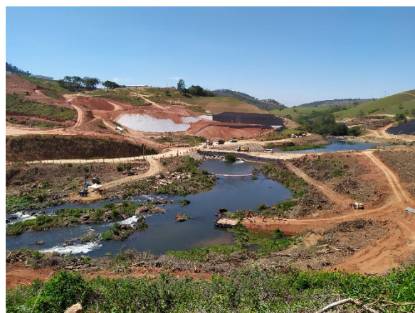
Foto 18- Novembro: vista passagem molhada e margem direita
