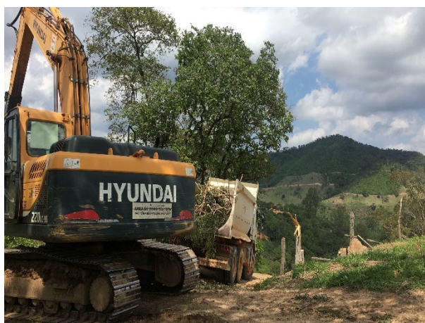
Foto 33: Avanço da Supressão vegetal (06/12/2019)
