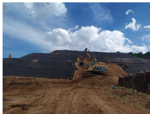
Foto 26- Dezembro: Ajustes no bota-fora 3 da margem direita após fortes chuvas
