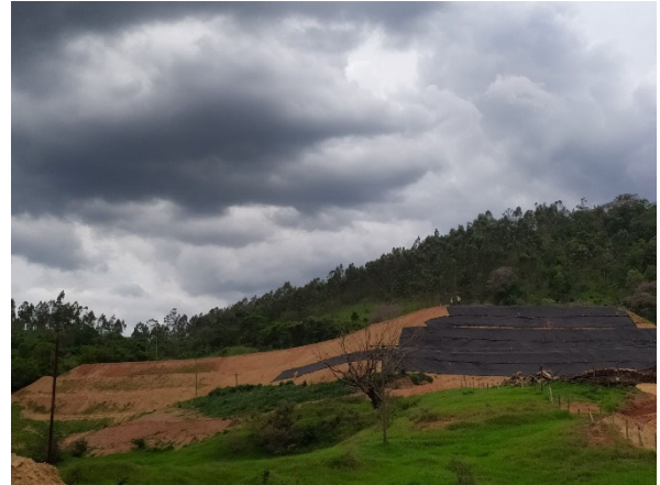
Foto 20- Novembro: Proteção do bota-fora 3
