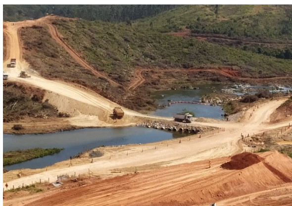
Foto 5- Setembro: passagem molhada finalizada
