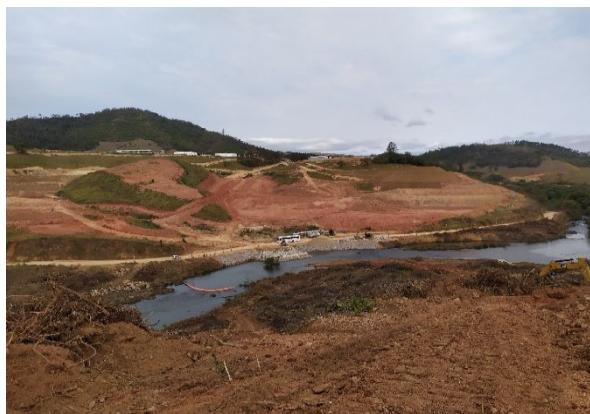
Foto 3- Setembro: Vista da margem direita e continuação da passagem molhada
