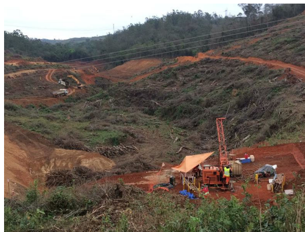
Foto 28: Avanço da Supressão vegetal (26/09/2019)
