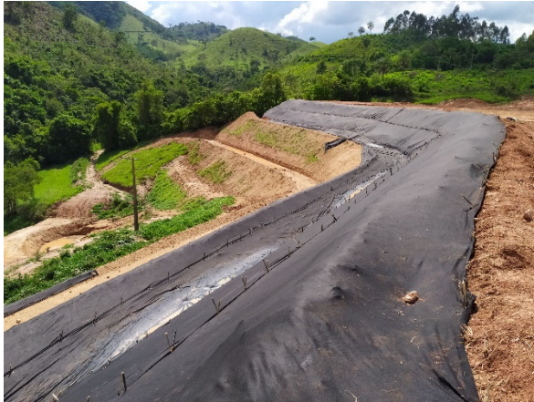
Foto 19- Novembro: Proteção do bota-fora 3
