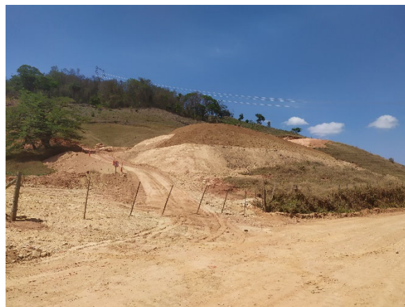
Foto 16 – Outubro: bota-fora 4 da margem direita
