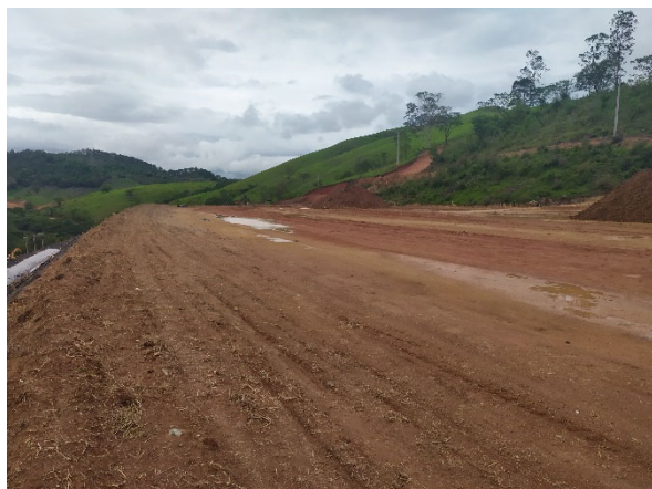
Foto 23- Novembro: bota-fora 1 da margem esquerda e armazenamento provisório do topsoil
