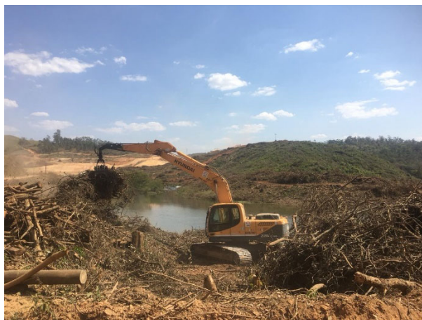
Foto 27: Avanço da Supressão vegetal (12/09/2019)
