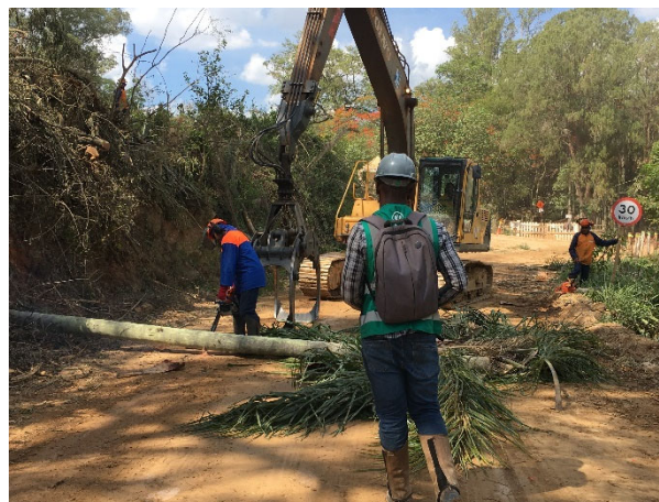
Foto 32: Avanço da Supressão vegetal (18/11/2019)
