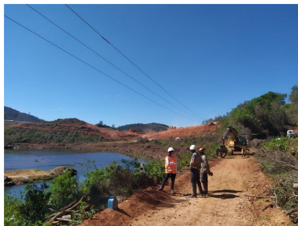
Foto 30: Avanço da Supressão vegetal (11/10/2019)
