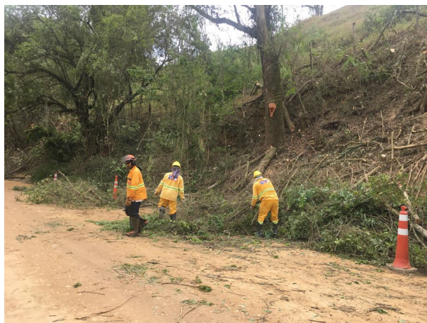
Foto 31: Avanço da Supressão vegetal (13/11/2019)
