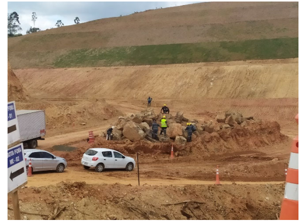
Foto 22- Novembro: Preparação para detonação de rocha do canal de desvio
