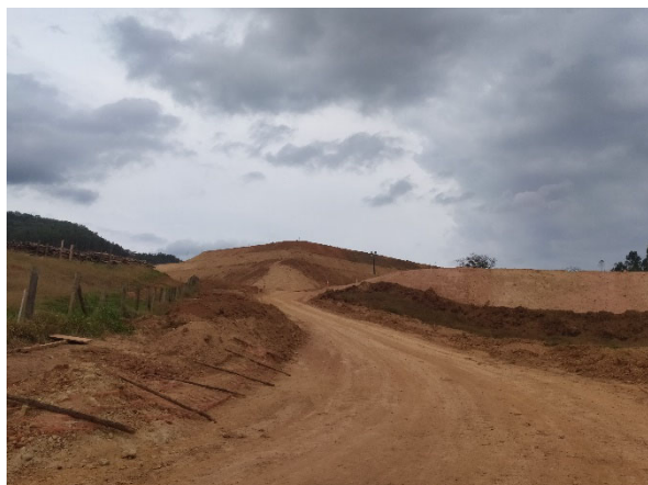
Foto 15 – Outubro: bota-fora 3 e 3A da margem direita
