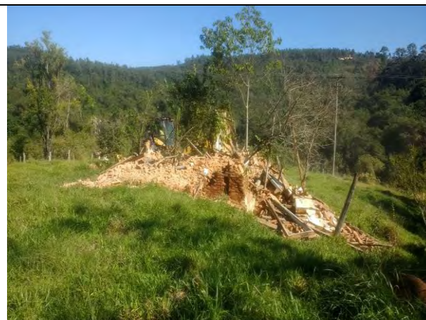
Foto 14 – Vista geral do imóvel durante o processo de demolição – Casa 55 / Lote 24 – 25/06/19.
