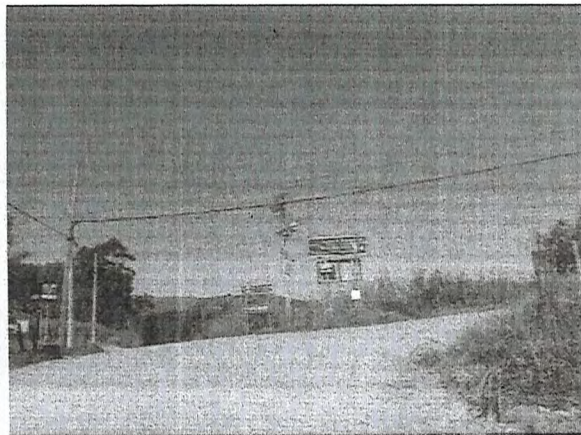
Foto 6 – Bifurcação no início da estrada de terra no novo caminho que será percorrido pelos motoristas após interdição, Pedreira (11/07/2019).
