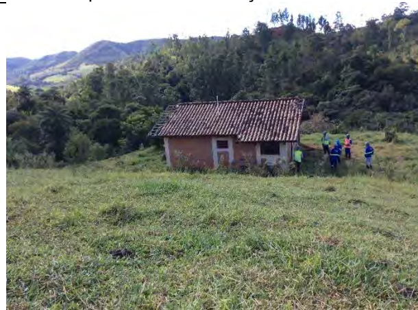
Foto 11 – Vista geral do imóvel antes da demolição – Casa 47 / Lote 35 – 04/06/19.
