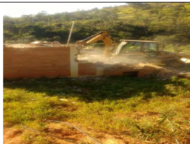
Foto 8 – Vista geral do imóvel durante o processo de demolição – Casa 46 / Lote 35 – 20/06/19.
