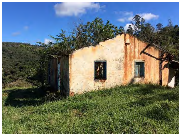
Foto 13 – Vista geral do imóvel antes da demolição – Casa 55 / Lote 24 – 04/06/19.
