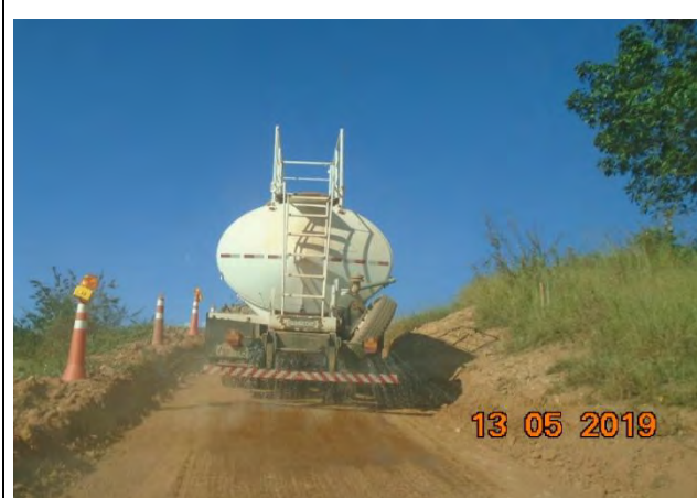
Foto 30 - Umectação da via interna do canteiro de obras.
