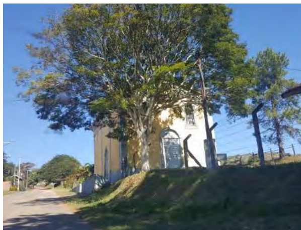
Foto 5 – Parte do desvio que será percorrido pelos motoristas após interdição, Pedreira (11/07/2019).
