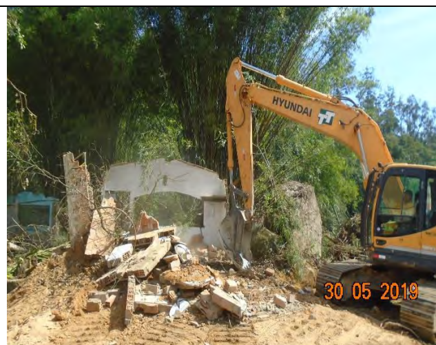
Foto 2 - Vista geral do imóvel durante o processo de demolição – Casa 64 / Lote 2.
