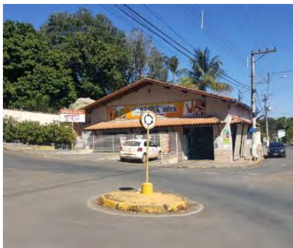
Foto 1- Vista da rua Padre Francisco Salvino, via que ficará somente com trânsito local. (10/07/2019) e início do desvio.
