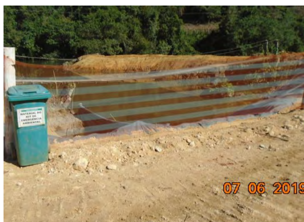
Foto 31 - Kit de mitigação ambiental instalado na área da obra.
