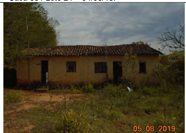
Foto 15 – Vista geral do imóvel antes da demolição – Casa 21/ Lote 4 – 05/08/19.
