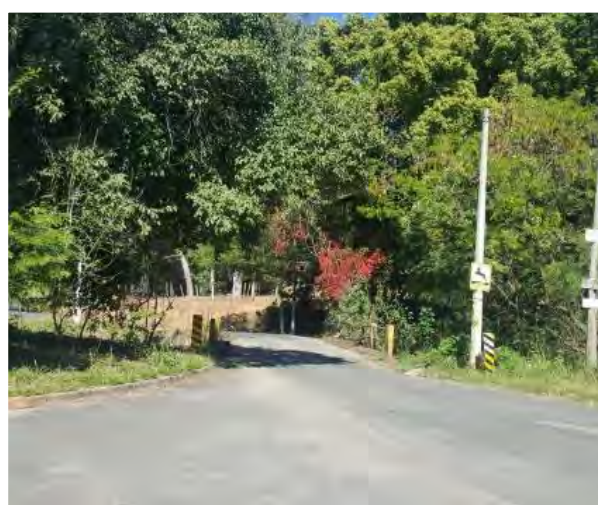
Foto 2 – Trajeto que será percorrido pelos motoristas após a interdição, Pedreira (10/07/2019).
