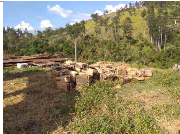
Foto 9 – Segregação de material da Casa 46 durante o processo de demolição -20/06/19.
