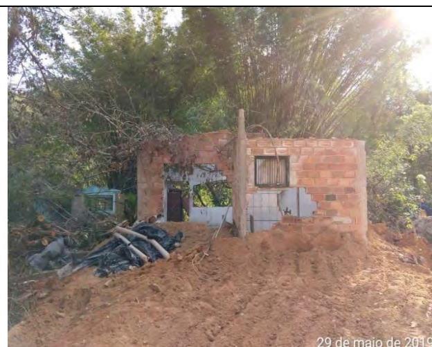
Foto 1 - Vista geral do imóvel antes a demolição – Casa 64 / Lote 2.
