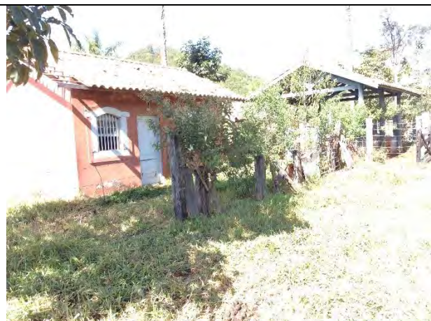
Foto 7 – Vista geral do imóvel antes da demolição – Casa 46 / Lote 35 – 04/06/19.
