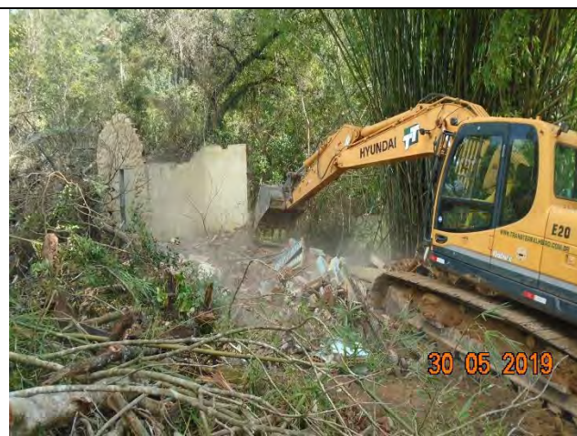
Foto 4 - Vista geral do imóvel durante o processo de demolição – Casa 65 / Lote 2.
