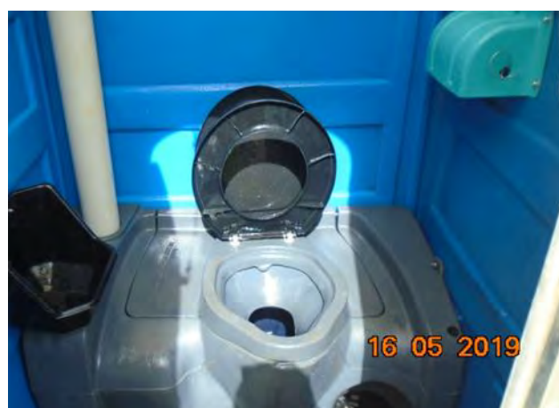
Foto 29 - Banheiro químico do canteiro industrial higienizado.
