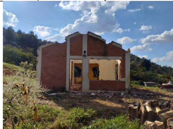
Foto 12 – Vista geral do imóvel durante o processo de demolição – Casa 47 / Lote 35 – 20/06/19.
