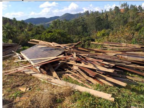
Foto 10 – Segregação de material da Casa 46 durante o processo de demolição -20/06/19.
