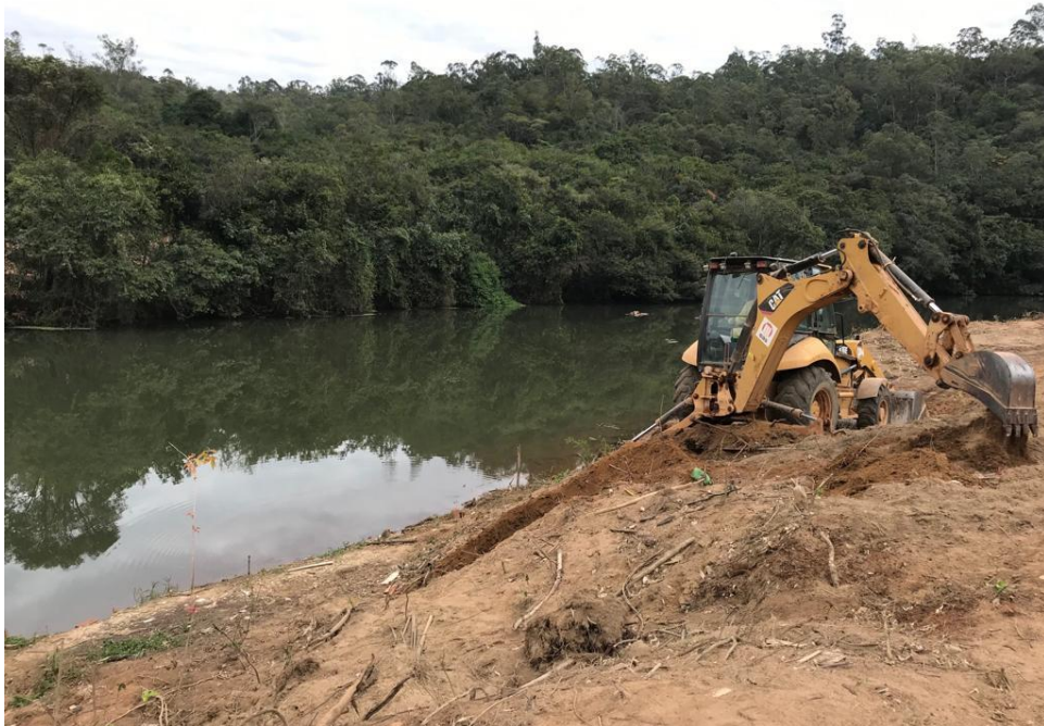
Foto 2.2-3: Vista do ponto amostral IC03, evidenciando atividades das obras para a implantação da barragem
