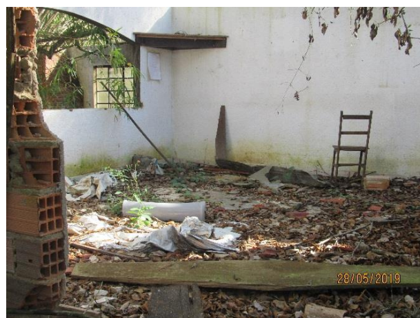
Foto 6 - Busca ativa na área do entorno do empreendimento. Residência desaproprada em fase de demolição.
