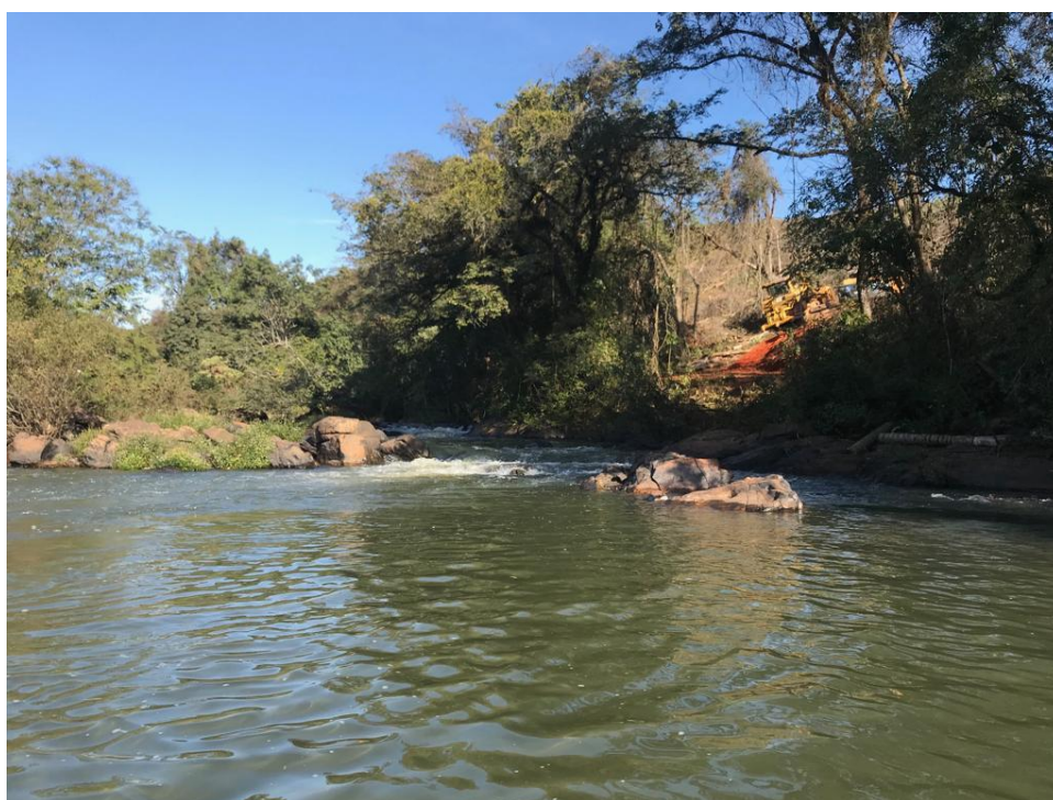
Foto 2.2-2: Vista do ponto amostral IC02, com destaque para as atividades das obras na margem do rio
