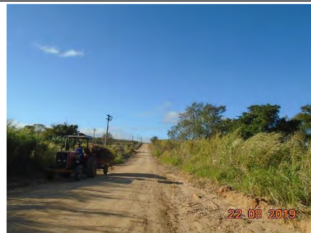
Foto 117: Percurso percorrido estrada sem pavimentação com transito de moradores.
