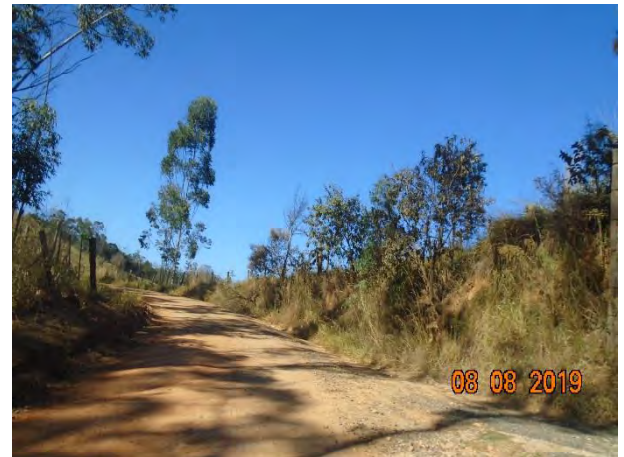
Foto 73: Percurso percorrido – Estrada Municipal Campinas.
