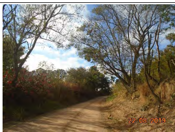
Foto 136: Percurso percorrido estrada sem pavimentação.
