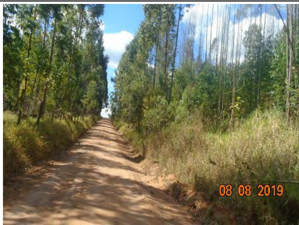
Foto 102: Estrada sem pavimentação com mata auxiliar em ambos os lados.
