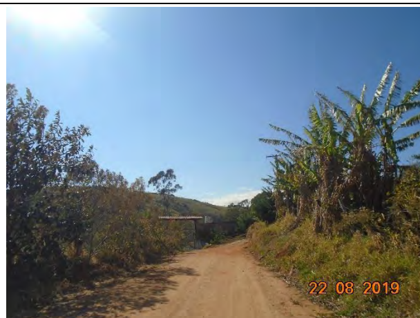
Foto 143: Percurso percorrido estrada sem pavimentação, próximo a moradias.
