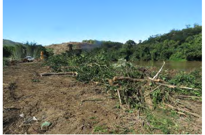
3.2 - Remoção de solo e material lenhoso.
