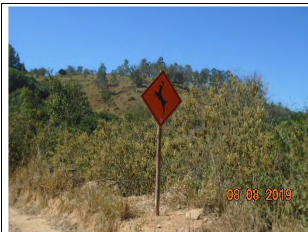
Foto 59 – Sinalização de passagem de fauna.
