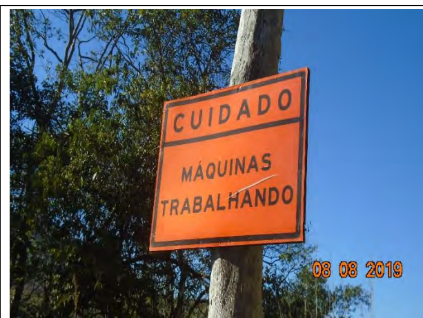
Foto 55 – Sinalização vertical instalada na Área de Influência direta do empreendimento.
