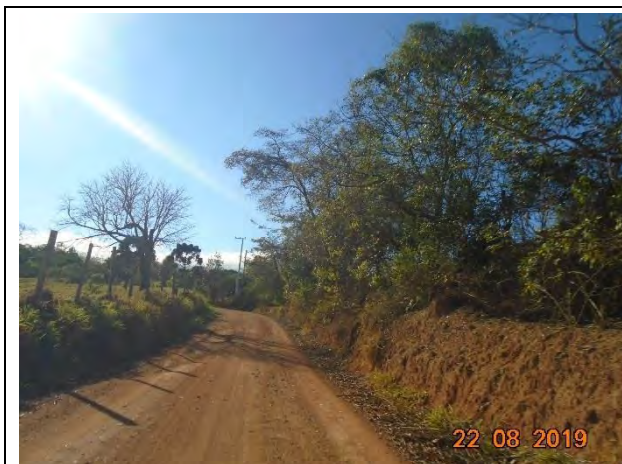
Foto 123: Percurso percorrido estrada sem pavimentação.
