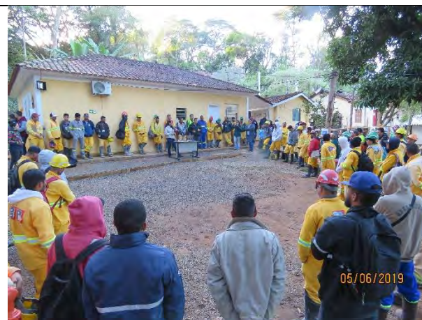
Foto 8 - Atividades executadas pela Equipe de fauna na Obra.
