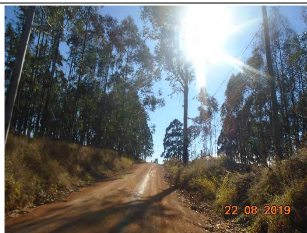
Foto 116: Percurso percorrido estrada sem pavimentação, com mata auxiliar em ambas as margens.
