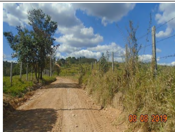
Foto 105: Percurso percorrido estrada sem pavimentação.
