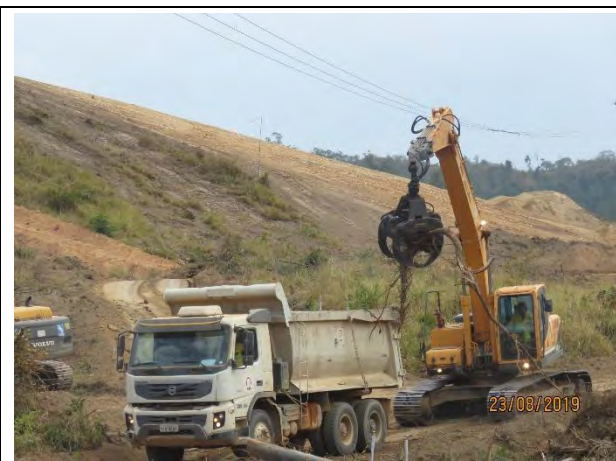
Foto 81 – Escavadeira-pinça no carregamento de resíduos florestais.
