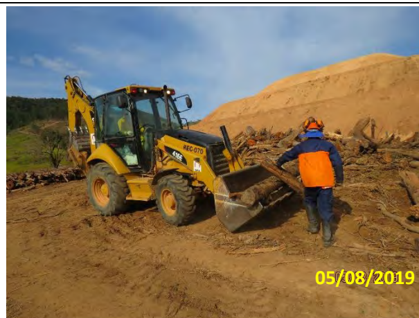
Foto 58 – Retroescavadeira na atividade de empilhamento de madeiras.
