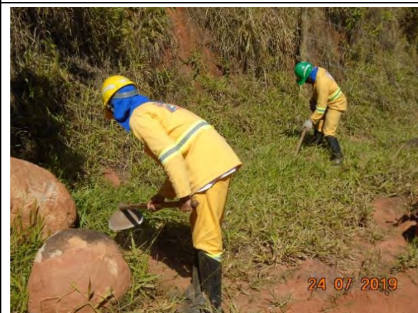
Foto 41 – Equipe desenvolvendo as atividades de manutenção no lote 4.
