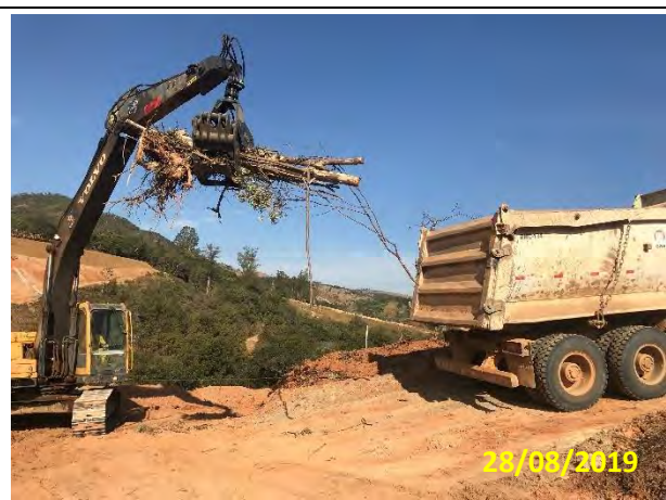
Foto 82 – Caminhão basculante aguardando o carregamento dos resíduos florestais.
