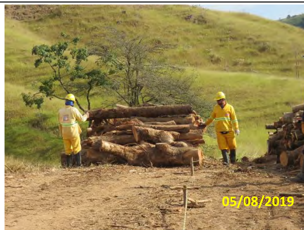
Foto 60 – Colaboradores na atividade de empilhamento de madeiras.
