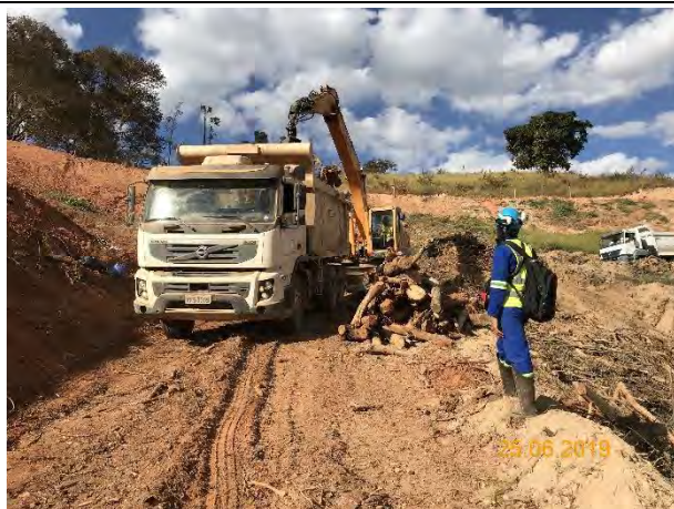
Foto 43: Carregamento do material lenhoso em caminhão basculante (25/06/2019).
