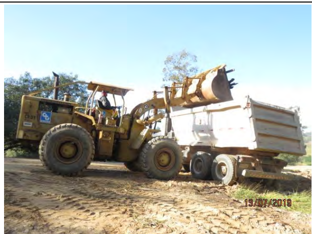
Foto 46: Caminhão basculante e pá carregadeira na atividade de transporte do material lenhoso.
