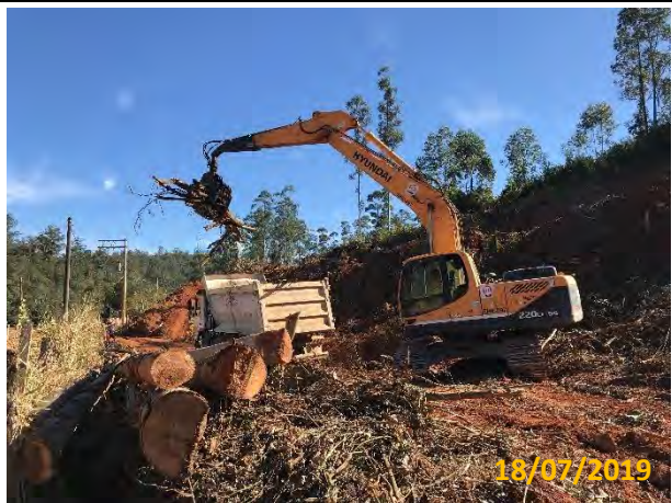
Foto 47: Caminhão basculante e escavadeira hidráulica na atividade de transporte.
