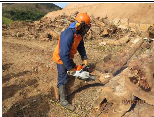
Foto 55 – Operador de motosserra realizando traçamento.
