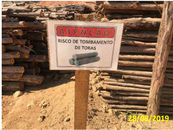
Foto 63 – Placas de advertência próxima às pilhas de madeiras.
