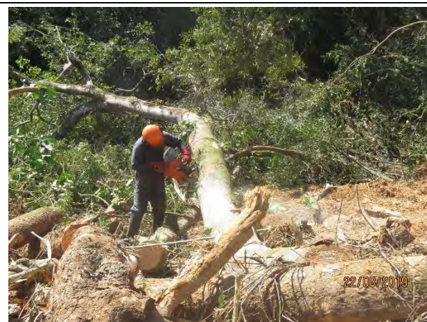
Foto 31: Seccionamento realizado de forma semi-mecanizada (22/05/2019).
