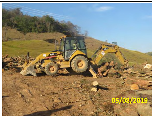
Foto 56 – Retroescavadeira na atividade de triagem do material florestal no Pátio de Estocagem 01.
