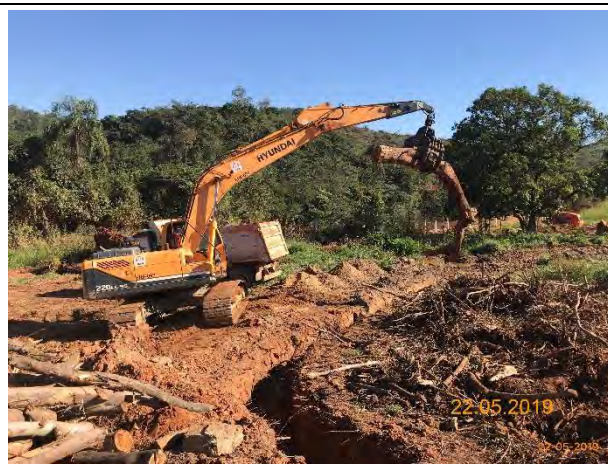
Foto 32: Escavadeira hidráulica utilizada para a remoção das toras e galhadas (22/05/2019).
