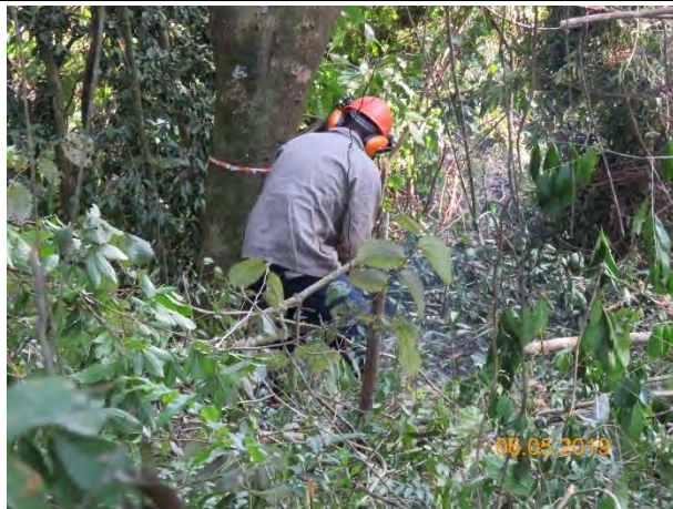
Foto 13: Operador de motosserra executando a supressão arbórea, após a atividade de bosqueamento.
