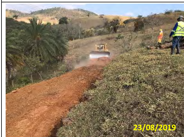
Foto 77 – Trator de esteira executando o aceiro no Pátio de Madeiras 02.
