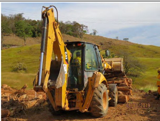
Foto 59 – Retroescavadeira na atividade de empilhamento de madeiras.
