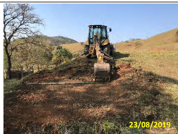
Foto 78 – Colaboradores na atividade de manutenção de aceiro do Pátio de Madeira 02.
