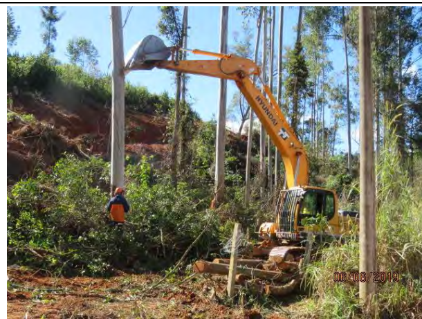
Foto 17: Escavadeira concha utilizada para direcionamento da queda do indivíduos arbóreo (08/06/2019).
