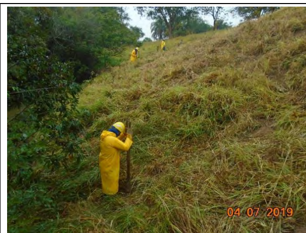
Foto 26 – Equipe realizando o preparo do solo no Lote 4.
