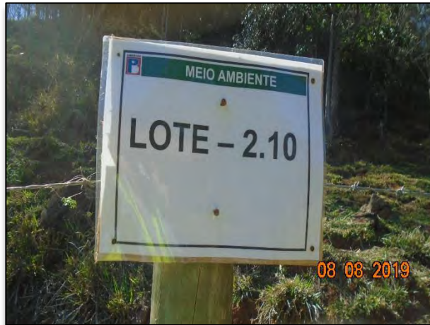
Foto 01: Colaborador realizando a instalação da placa de identificação do sublote.
