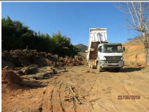
Foto 89 – Caminhão basculante na atividade de descarregamento das raízes no estoque temporário.
