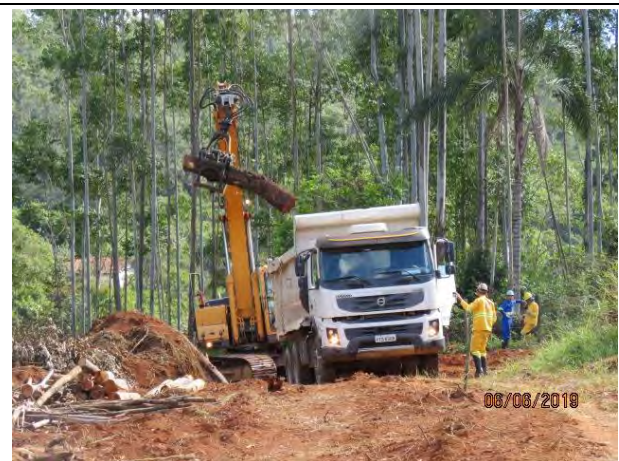
Foto 45: Caminhão cascualente e escavadeira hidráulica na atividade de transporte.
