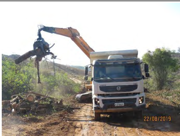
Foto 49: Carregamento do caminhão basculante.
