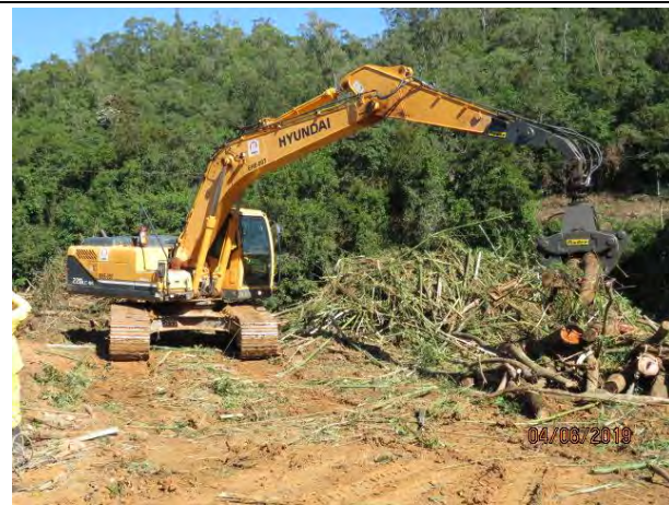
Foto 33: Escavadeira hidráulica durante as atividades de remoção dos exemplares arbóreos suprimidos.
