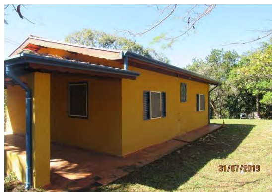
Fachada lateral direita do imóvel
