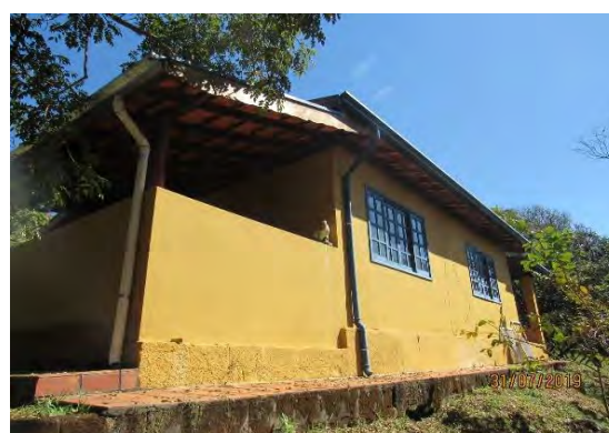
Fachada lateral esquerda do imóvel
