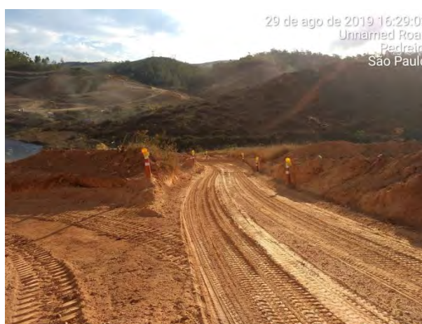
Foto 116 - Sinalização nas vias internas da obra.
