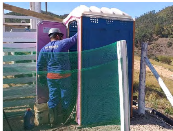
Foto 148 - Retirada de efluente de banheiro químico no canteiro industrial (Foto:26/08/2019).
