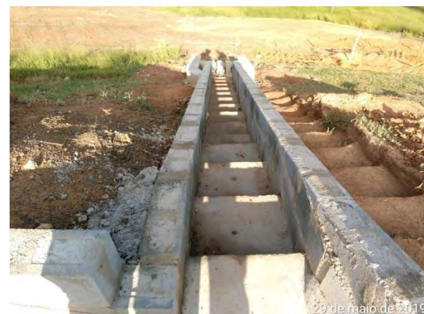
Foto 122 - Escada hidráulica compondo o sistema de drenagem definitiva de água pluvial no canteiro operacional.
