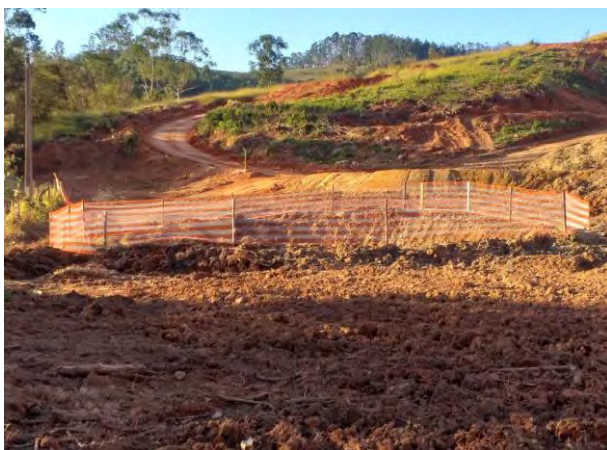
Foto 131 - Instalação cacimba na margem direita, próximo ao eixo. (Foto:19/07/2019)
