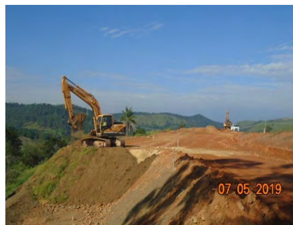
Foto 184 - Registro de atividades de terraplenagem no canteiro operacional.
