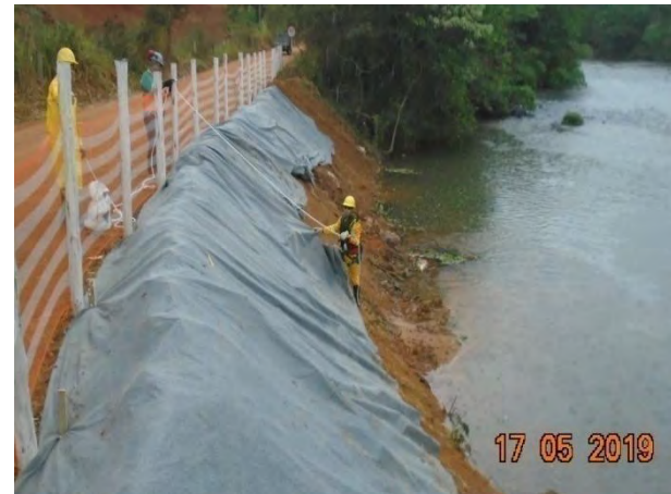
Foto 120 - Talude conformado, com crista volta para dentro, evitando carreamento de sedimento durante chuva.
