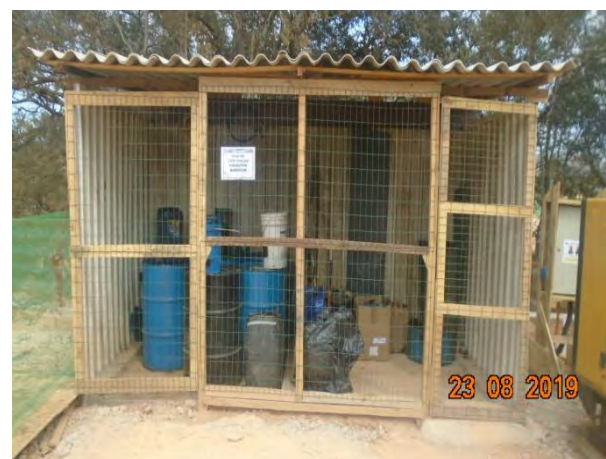
Foto 22 – Baía de produtos químicos temporária na frente de serviço de manutenção.
