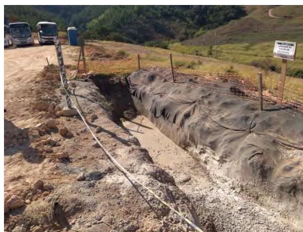
Foto 140 - Evidência de que as lavagens das calhas de betoneiras estão ocorrendo no local adequado. (Foto: 28/05/2019)
