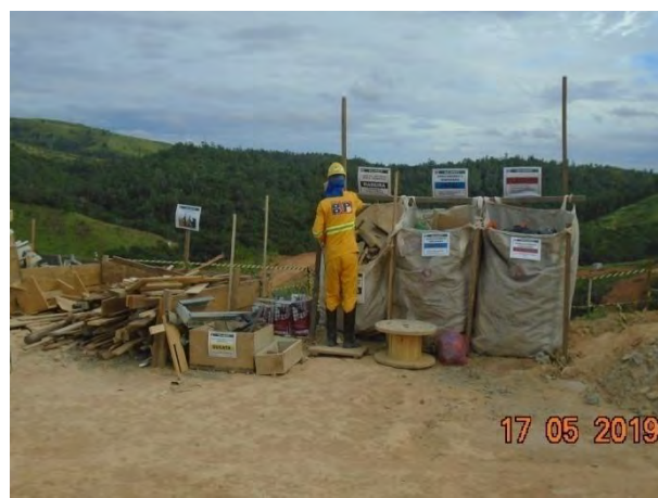
Foto 176 - Segregação de resíduos recicláveis presentes no canteiro operacional.
