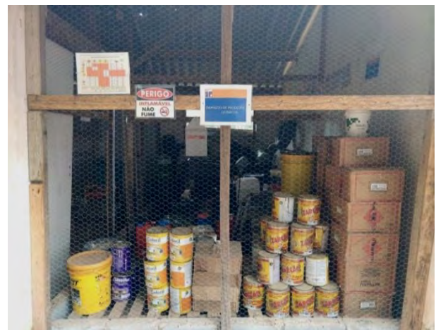
Foto 18- Baía de produtos químicos instalada no canteiro administrativo. (Foto: 28.06.2019)
