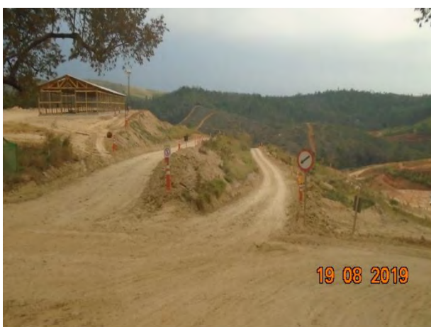
Foto 115 - Sinalização nas vias internas da obra.
