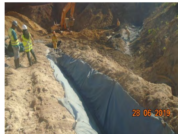
Foto 128 - Instalação de drenagem provisória na área da escavação obrigatória.
