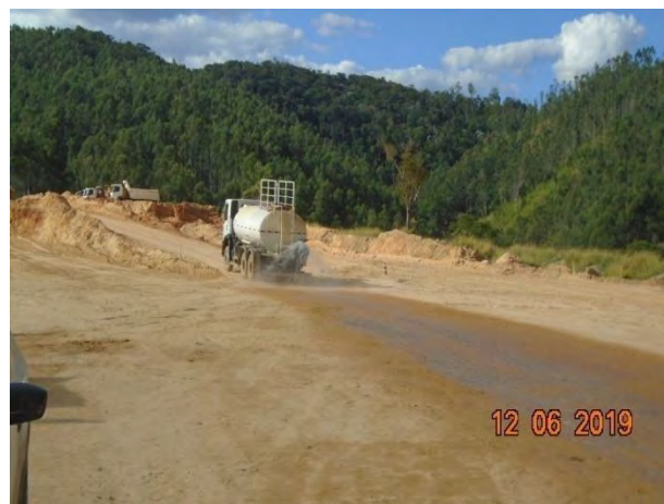
Foto 166 - Umectação das vias internas de acesso ao canteiro industrial.
