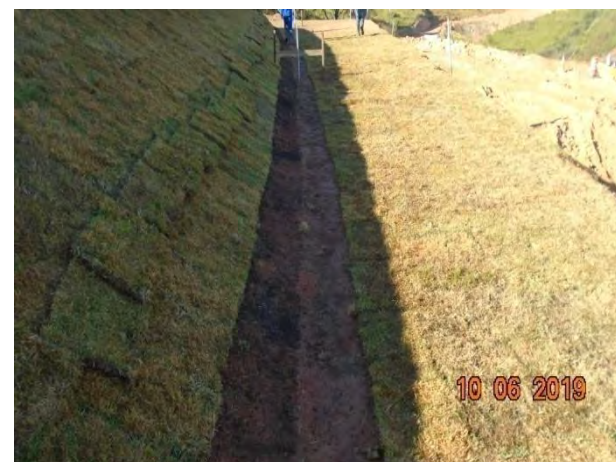
Foto 127 - Instalação de grama em placas para proteção do talude.
