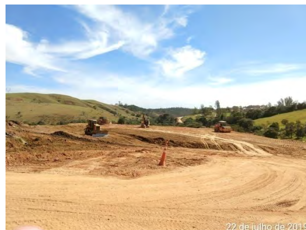
Foto 198 - Registro de movimentação de terra do bota-fora III.
