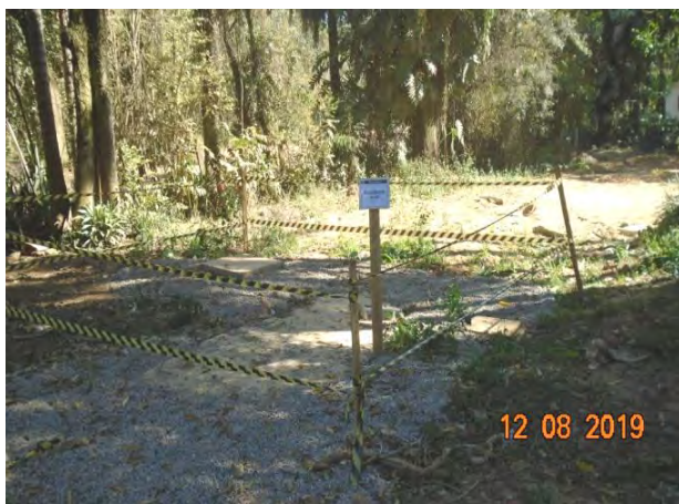
Foto 151 - Registro da área do biodigestor do canteiro administrativo.
