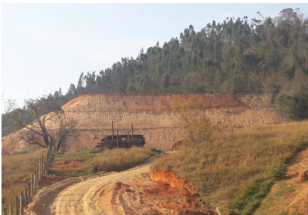
Foto 204 – Bota-fora III Margem Direita. (Foto:28.08.2019)
