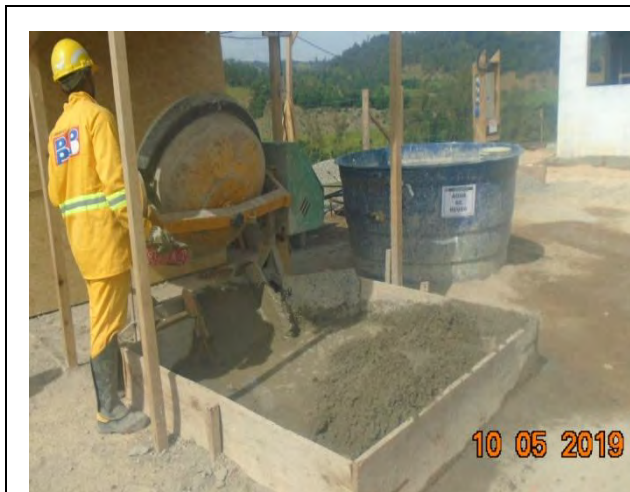
Foto 17- Betoneira de concreto instalada no canteiro industrial, com a devida contenção.
