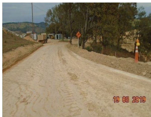
Foto 114 - Sinalização nas vias internas da obra.
