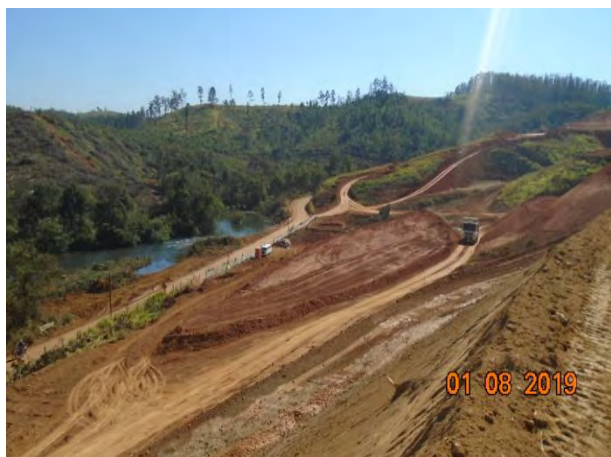
Foto 199 – Movimentação de terra próxima à área do eixo.
