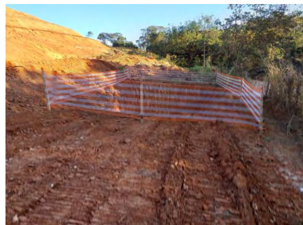
Foto 132 - Instalação cacimba margem direita. (Foto:19/07/2019)
