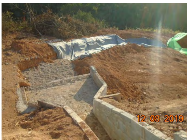
Foto 133 - Dissipador dando continuidade ao direcionamento da água que chega pela escada hidráulica.
