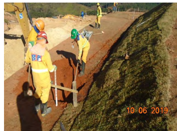
Foto 125 - Instalação de drenagem provisória na área de escavação obrigatória.
