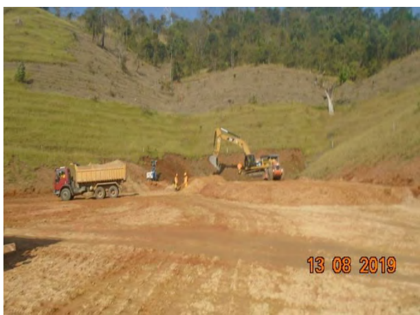
Foto 201 – Movimentação de terra no bota fora V.
