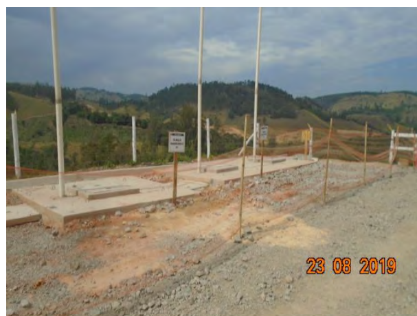
Foto 159 - Filtros anaeróbicos instalados no canteiro operacional.
