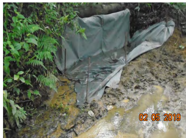
Foto 118 - Instalação de manta geotêxtil na ombreira esquerda, a fim de evitar carreamento de sedimento no curso hídrico.
