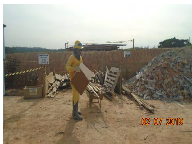
Foto 35- Limpeza e organização no armazenamento de resíduos sólidos no canteiro industrial.
