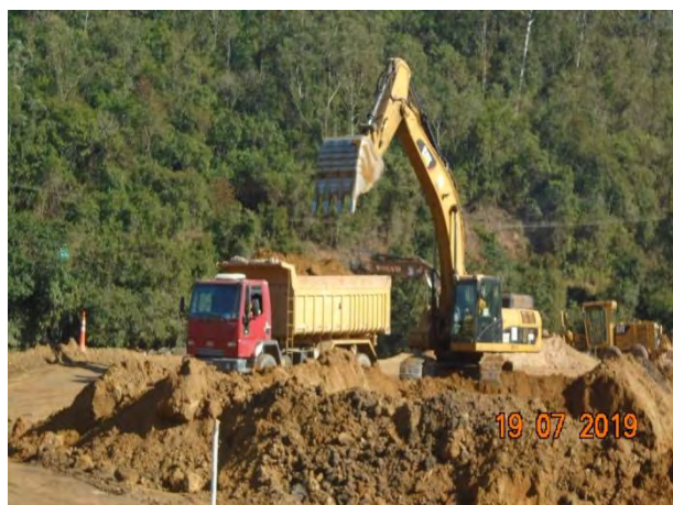
Foto 197 - Atividade de escavação na área da ensecadeira J0.
