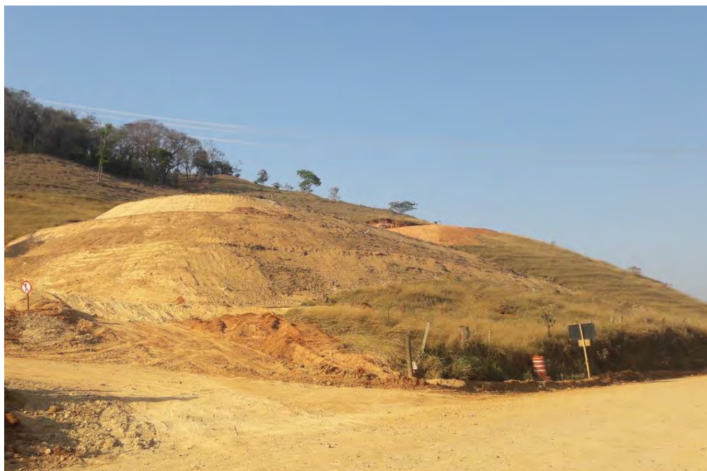
Foto 205 – Bota-fora IV Margem Direita. (Foto:28.08.2019)
