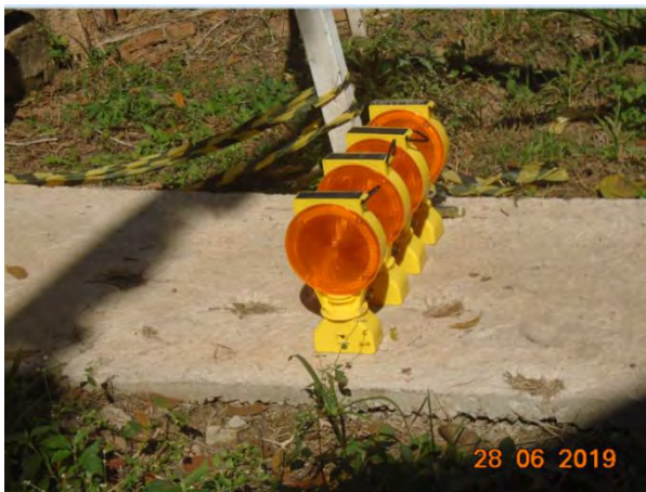
Foto 45- Sinalizadores com utilização de placas de energia solar.
