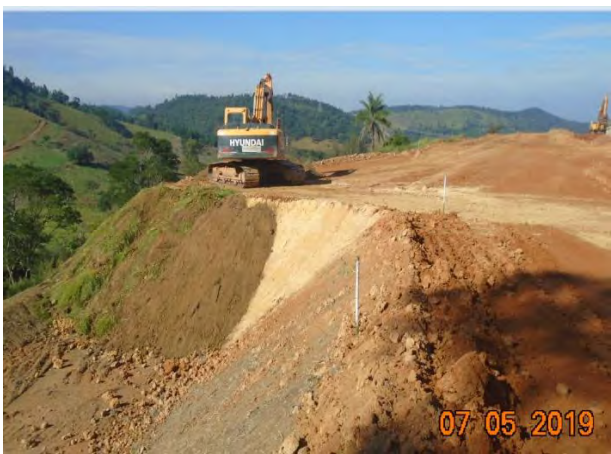
Foto 119 - Instalação de solo com material vegetal para proteção do talude.
