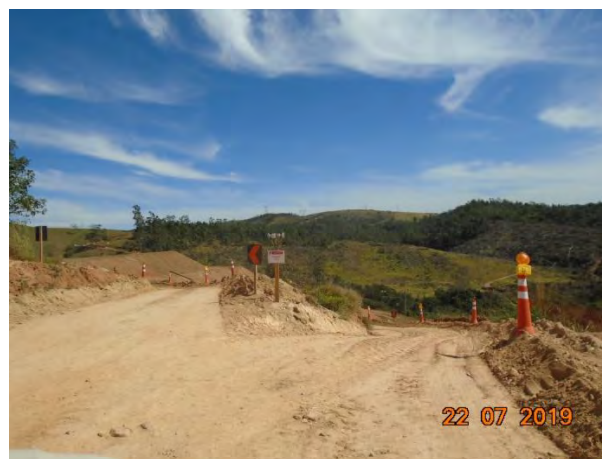
Foto 112 - Sinalização nas vias internas da obra.
