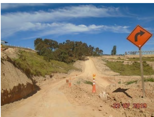
Foto 110 - Sinalização nas vias internas da obra.
