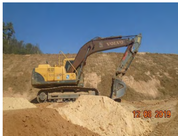
Foto 200 – Registro de terraplenagem próximo à área de escavação.
