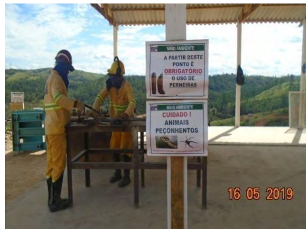
Foto 32- Sinalização para uso de perneiras devido a presença de animais peçonhentos no canteiro operacional.
