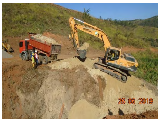
Foto 189 - Escavação obrigatória da margem direita.
