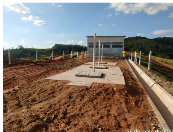
Foto 158 - Filtros anaeróbicos instalados no canteiro operacional.
