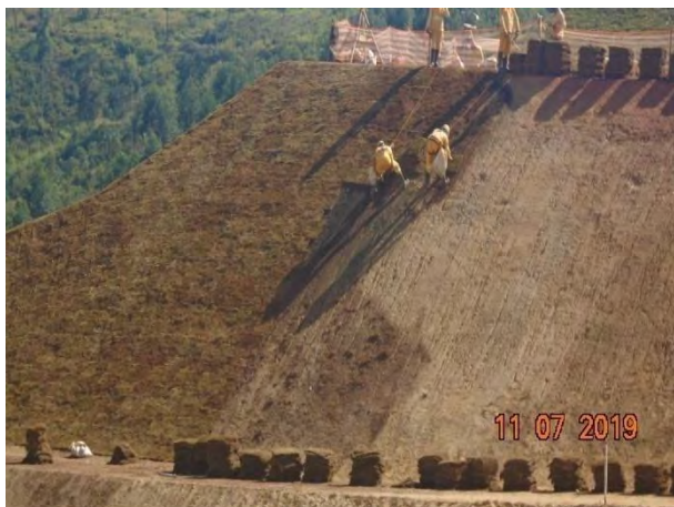
Foto 129 - Instalação de grama em placa no talude definitivo.
