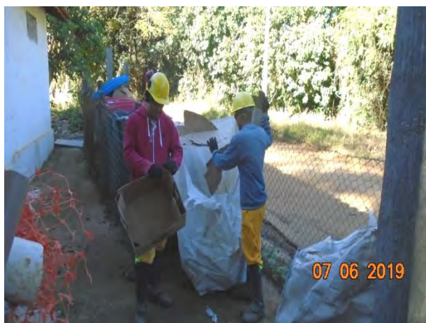
Foto 33- Limpeza e organização no canteiro administrativo.
