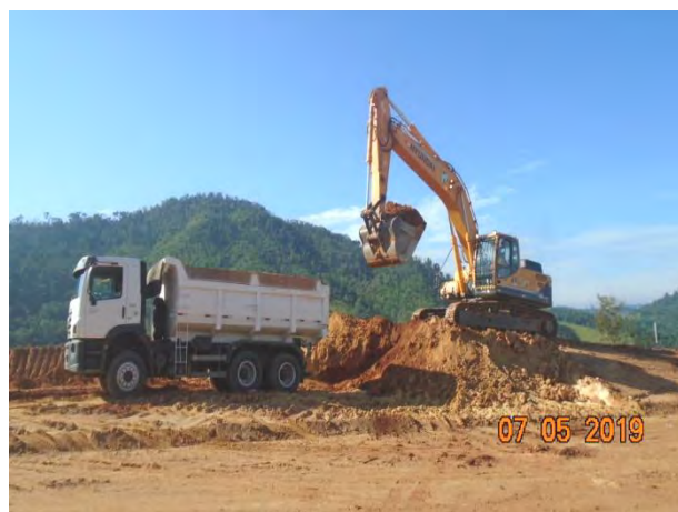
Foto 183 - Escavação na área do canteiro operacional.
