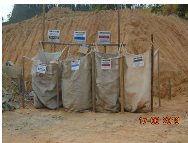
Foto 177 - Segregação de resíduos recicláveis presentes no canteiro operacional.
