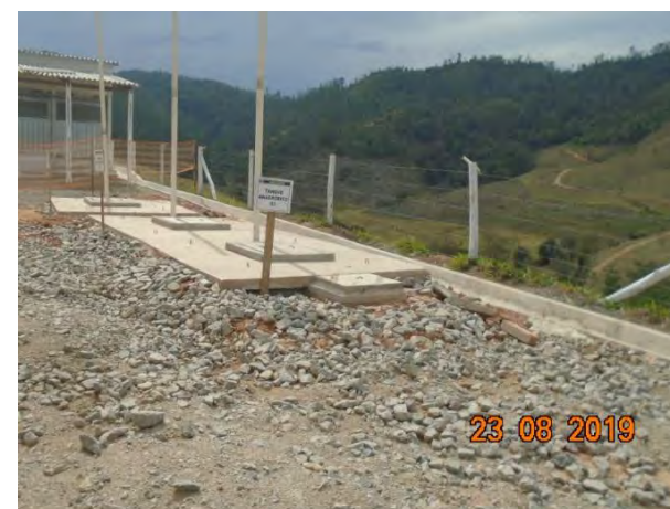
Foto 160 - Filtros anaeróbicos instalados no canteiro operacional.
