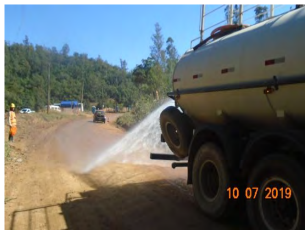
Foto 168 - Umectação das vias externas de acesso à obra na margem direita.
