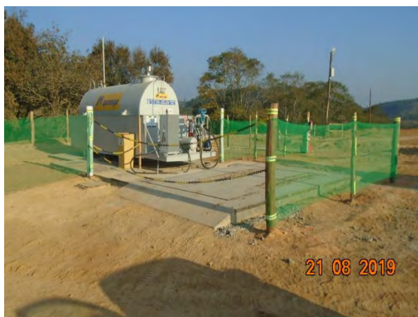
Foto 21 – Área de instalação do futuro posto de abastecimento no canteiro operacional.
