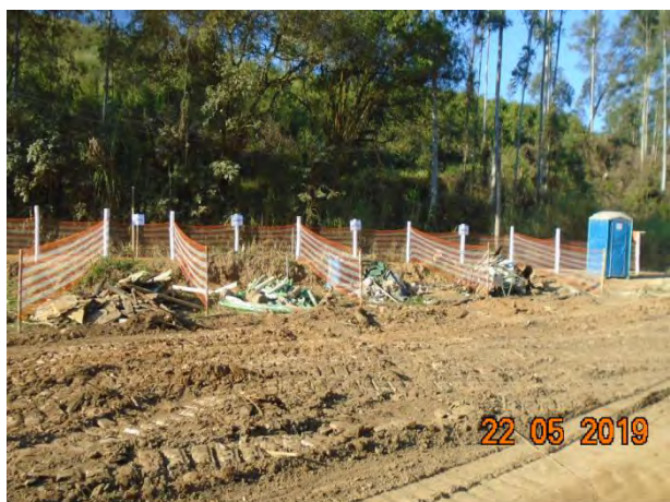
Foto 31- Segregação de resíduos na frente de serviço da ensecadeira J0 na margem direita.
