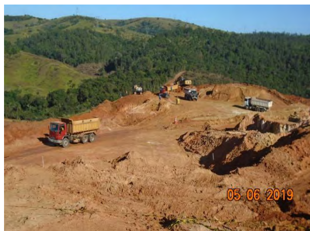
Foto 185 - Escavação obrigatória da margem direita.
