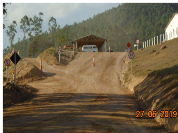
Foto 106 - Sinalização para acesso de veículos ao canteiro operacional.
