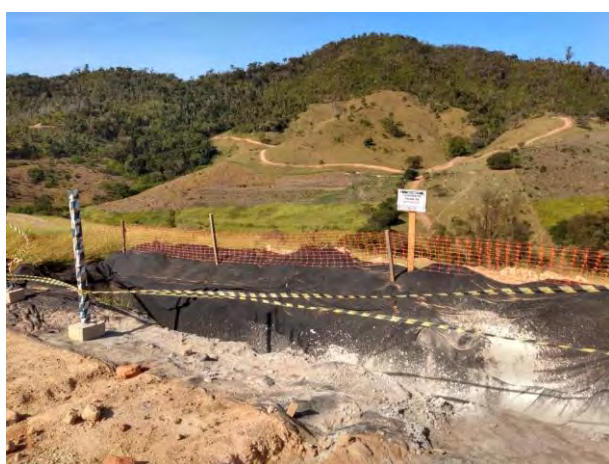
Foto 139 - Registro de contenção ambiental para lavagem de calha de betoneira. (Foto: 28/05/2019)
