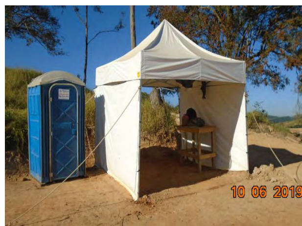
Foto 34- Frente de serviço de supressão vegetal, margem esquerda.
