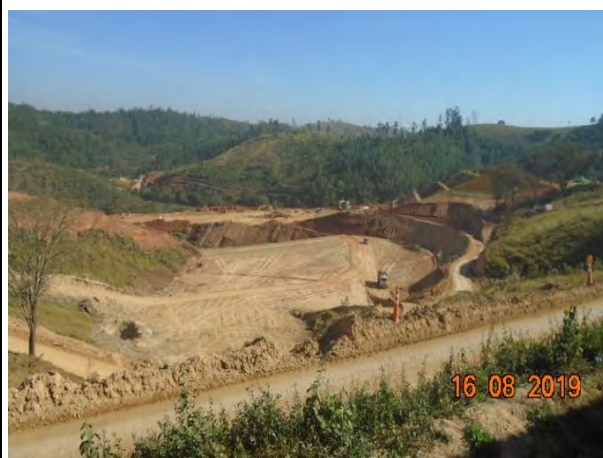
Foto 202 - Movimentação de terra na área do canteiro operacional.
