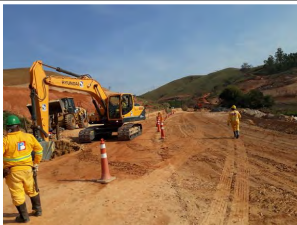
Foto 100 - Sinalização para isolar atividade da obra. (Foto:29/08/2019)
