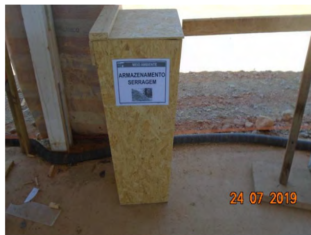
Foto 52 – Coletor para armazenar a serragem gerada na carpintaria, a fim de reutilizar na obra.
