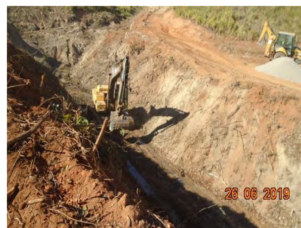
Foto 190 - Escavação obrigatória da margem direita.
