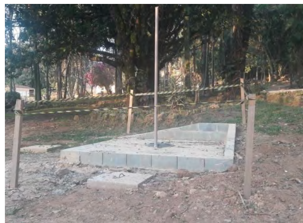
Foto 152 - Instalação do segundo biodigestor no canteiro administrativo. (Foto:30/08/2019)
