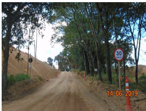
Foto 107 - Sinalização no acesso da estrada municipal para o canteiro operacional.
