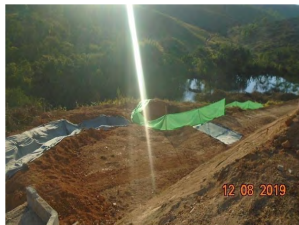
Foto 134 - Dando continuidade ao sistema de direcionamento duas cacimbas para reter os sedimentos.
