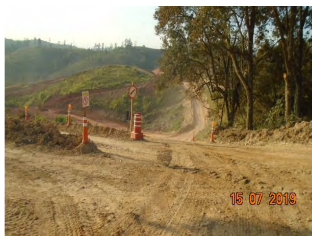
Foto 109 - Sinalização nas vias internas da obra.
