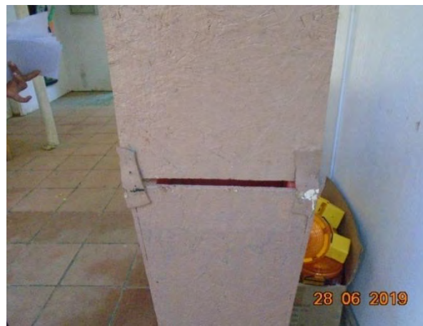
Foto 48- Dobradiça produzida com sobras de pneu.
