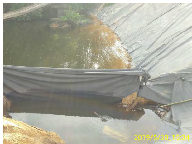
Foto 124 - Implantação de dispositivos para controle de escorregamento de encostas e taludes.
