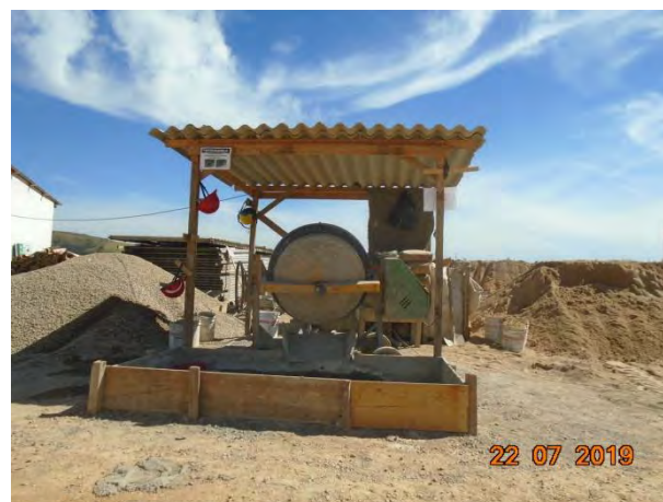
Foto 20 – Betoneira na área do canteiro industrial com a devida contenção.
