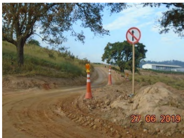
Foto 105 - Sinalização na saída da escavação obrigatória margem direita.
