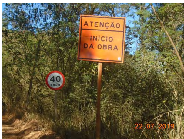
Foto 98 - Sinalização informativa sobre início de trecho de obra e velocidade máxima permitida.
