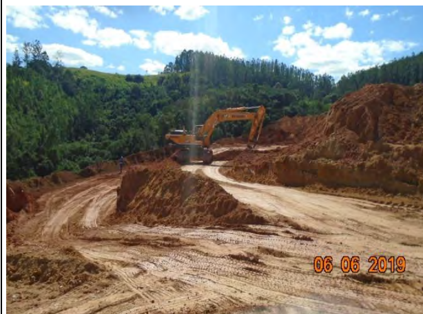
Foto 186 - Escavação obrigatória da margem direita.
