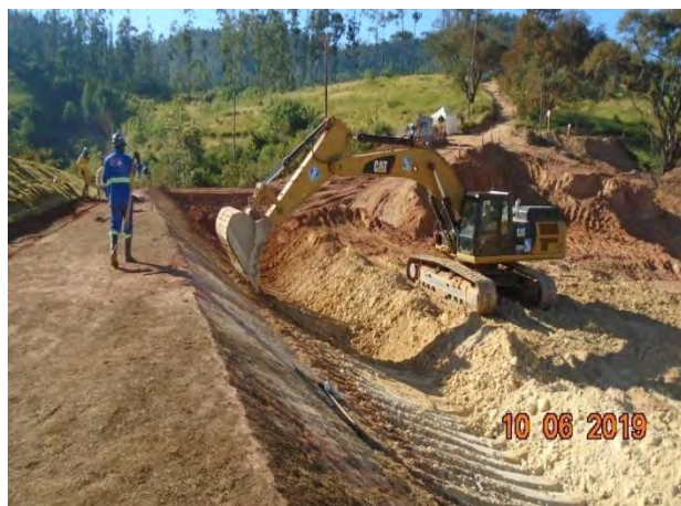
Foto 126 - Escavação de canaleta de drenagem provisória.
