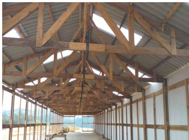
Foto 54 – Telhas translúcidas utilizadas na estrutura do futuro almoxarifado, permitindo a passagem de iluminação solar, economia de energia. (Foto: 30.08.2019)
