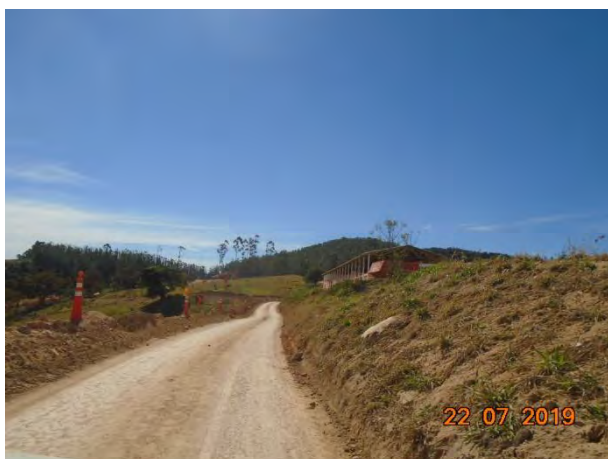
Foto 111 - Sinalização nas vias internas da obra.
