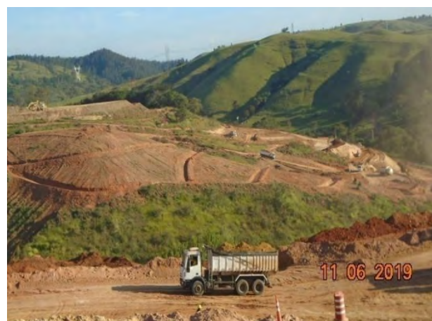
Foto 187 - Escavação obrigatória da margem direita.
