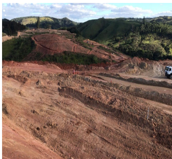
Foto 3- 06/06/2019 Escavação do eixo Margem Direita
