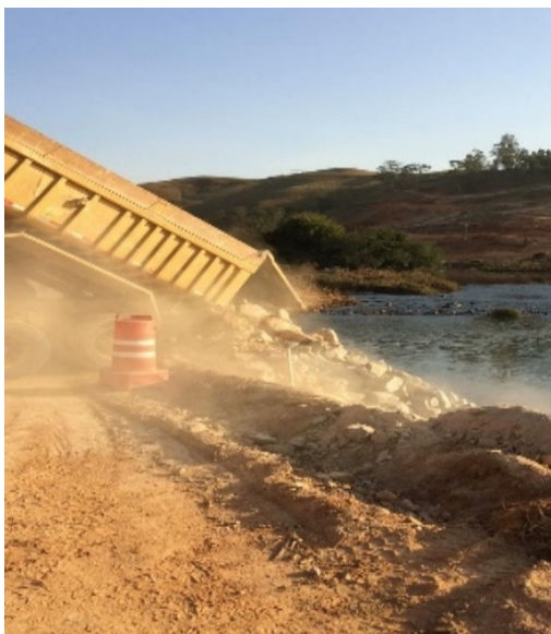
Foto 33: Avança da Construção da ensecadeira M1 30/08/2019
