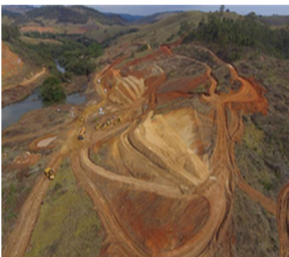
Foto 19- 31/08/2019-Limpeza da região do Bota- Fora I e Canal de Desvio - ME
