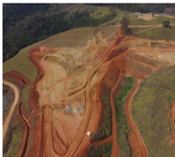
Foto 20- 31/08/2019-Escavação da Ombreira Direita e Bota-Fora II – MD
