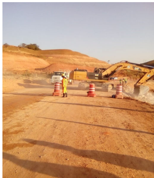
Foto 34: Avança da Construção da ensecadeira M1 30/08/2019
