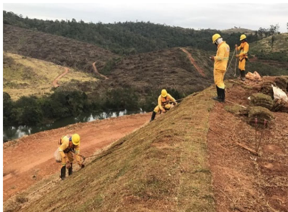
Foto 7- 20/08/2019-Proteção de talude – Bota Fora 1
