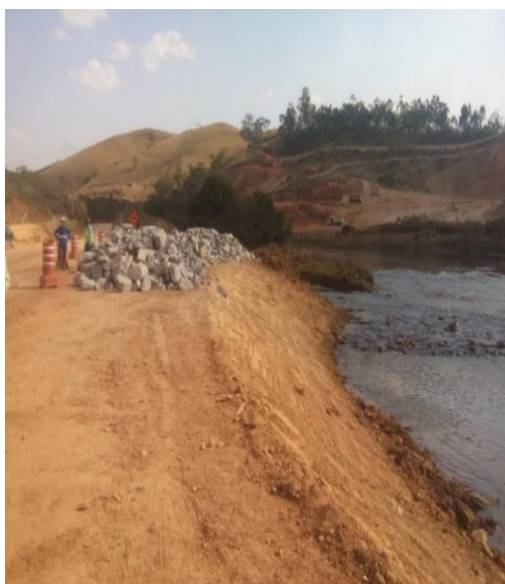
Foto 31: Aviação da Construção da ensecadeira M1 30/08/2019
