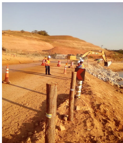
Foto 32: Aviação da Construção da ensecadeira M1 30/08/2019
