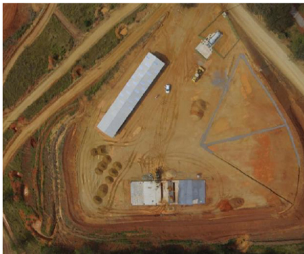
Foto 17- 31/08/2019 -Canteiro Industrial - Construção do Posto de Abastecimento, Almoxarifado e Oficina
