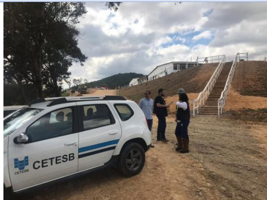
Foto 46-Vistoria o novo layout do canteiro industrial. 17/07/2019
