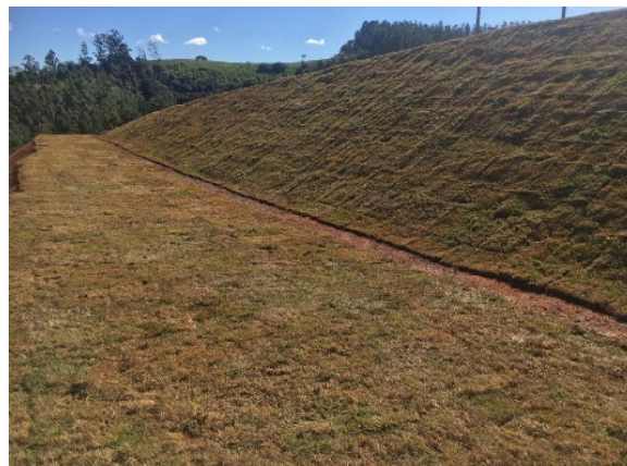
Foto 8- 07/07/2019-Proteção de talude – Ombreira Direita
