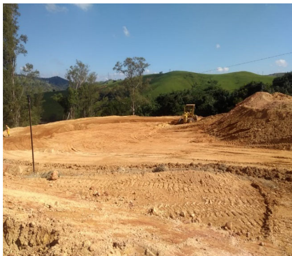
Foto 1- 20/05/2019 – Terraplenagem canteiro industrial
