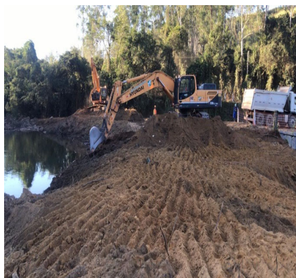
Foto 4- 06/06/2019 Escavação para implantação da ensecadeira de jusante J0
