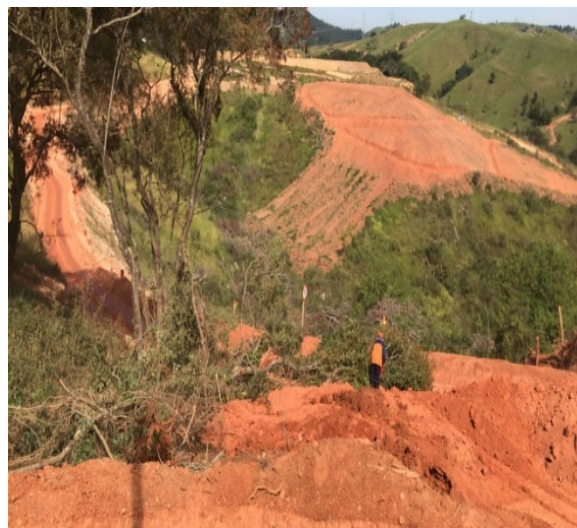
Foto 2- 27/05/2019 -Escavação da ombreira direita (jusante)
