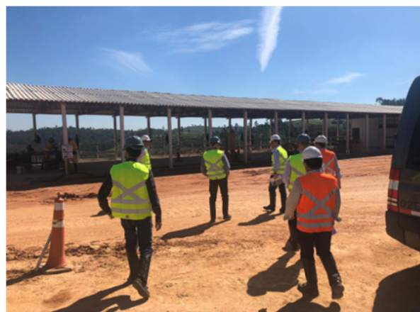
Figura 18- Visita dos executivos da CAF ao canteiro de obras da Barragem Pedreira. 22/05/2019
