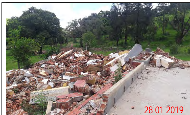
Foto 1: Vista geral do desmonte da estrutura – realizado Lote 4
