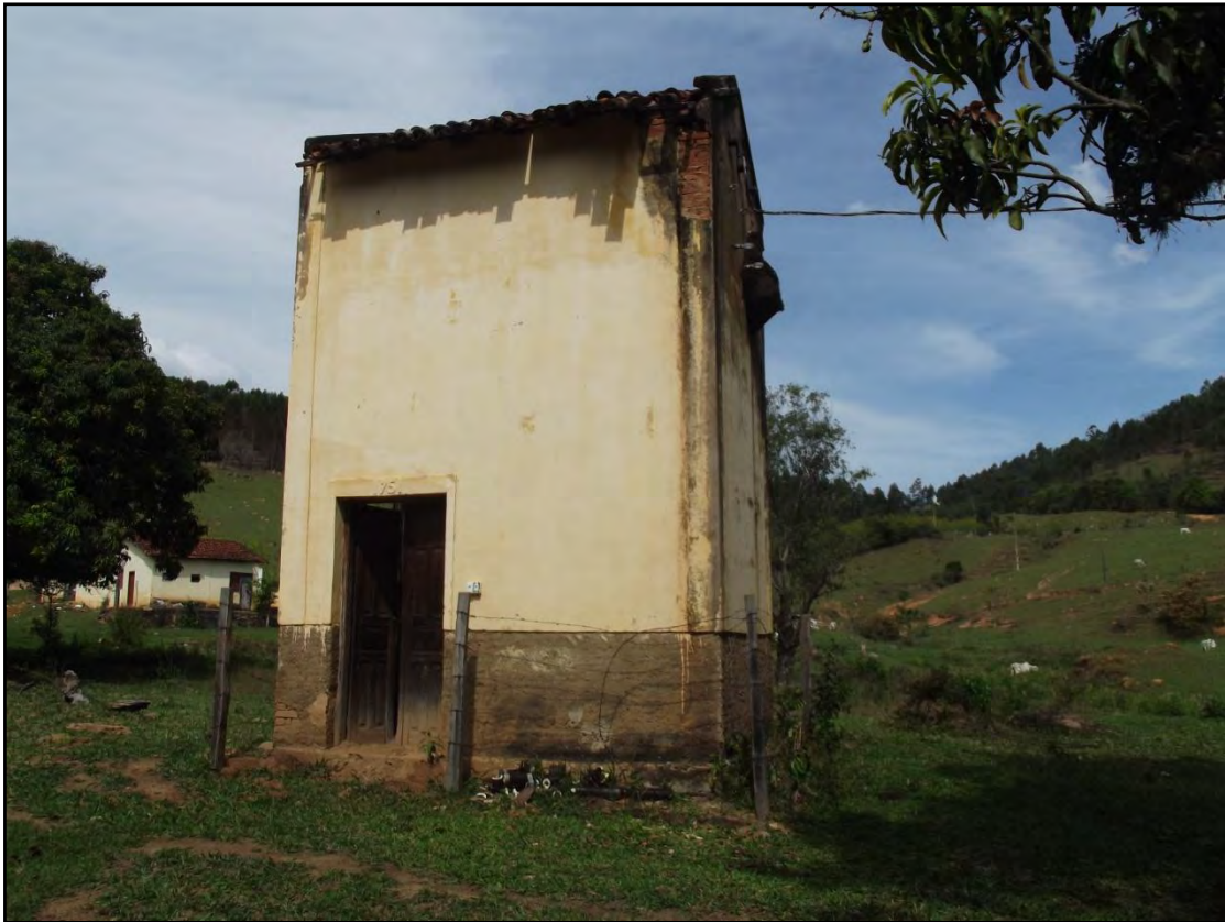
Figura 73: Edificação para sistema de energia elétrica
