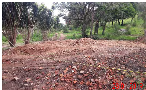
Foto 2: Vista geral da área com a estrutura demolida - Lote 4
