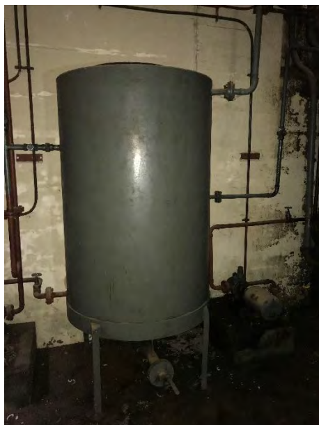
Figura 11.5-8: Filtro de óleo diesel utilizado, na parte inferior do local.
