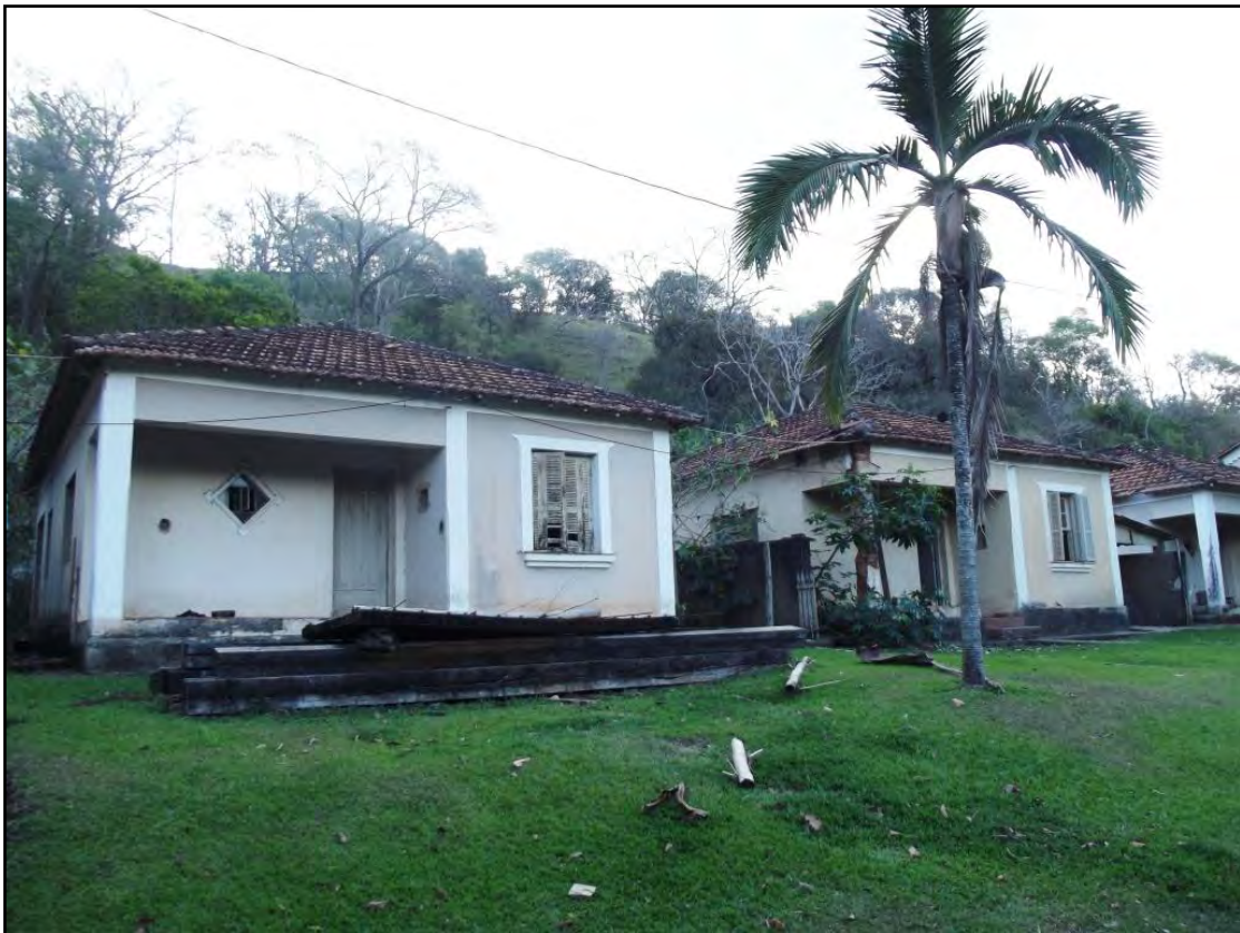
Figuras 91 e 92: Casa de máquinas e residências operárias – Usina Macaco Branco
