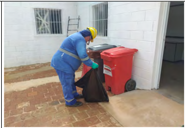
Foto 17 – Monitoramento da coleta seletiva no canteiro de obras – 10/02/2019
