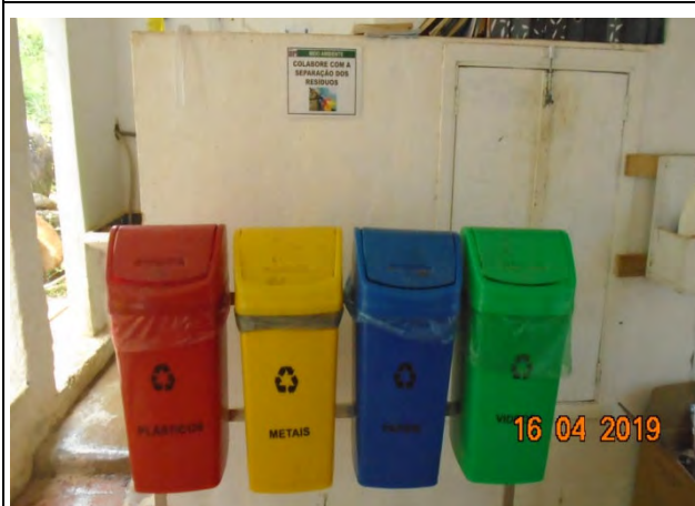
Foto 32 – Coletores seletivos na área interna do canteiro de obras, realização de monitoramento
