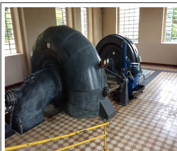
Figura 11.5-12: Motor de geração desligado.
