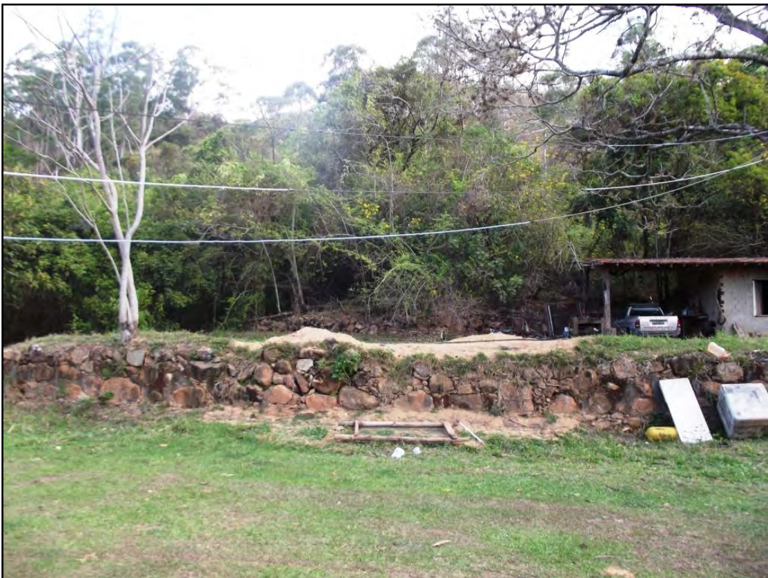
Figura 87: Embasamento em pedra de possível edificação laboral
