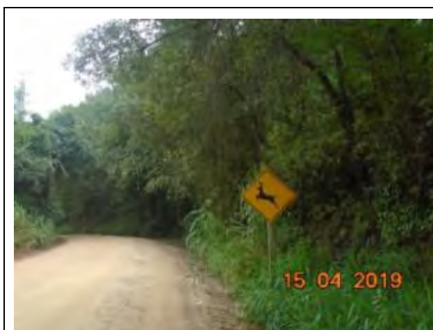
Foto 51: Sinalização obras no caminho de serviço.
