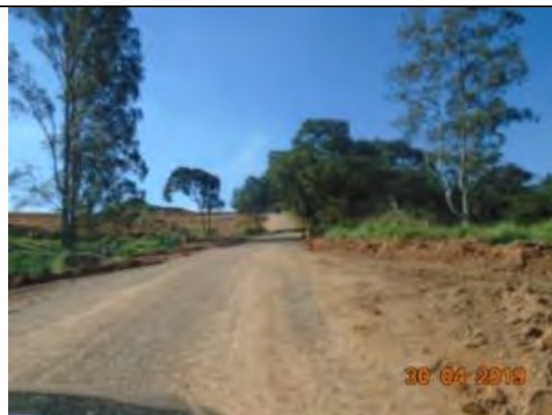
Foto 94: Percurso percorrido – Acesso interno às obras.
