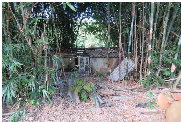
2.1 - Busca ativa sob entulhos e possíveis abrigos.
