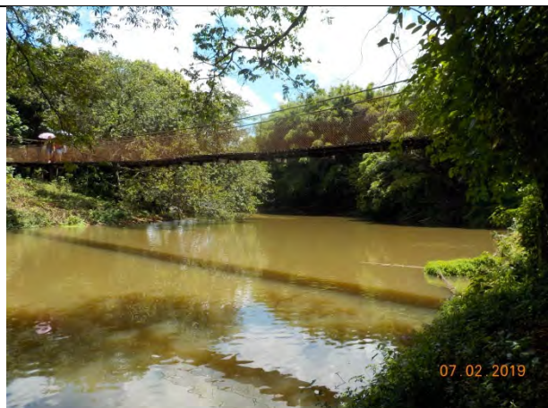
Foto 9: Ponto P06 - rio Jaguari, na Cidade de Pedreira, na Captação de Água para Abastecimento.
