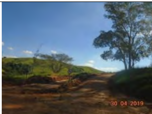
Foto 93: Percurso percorrido – Acesso interno às obras.
