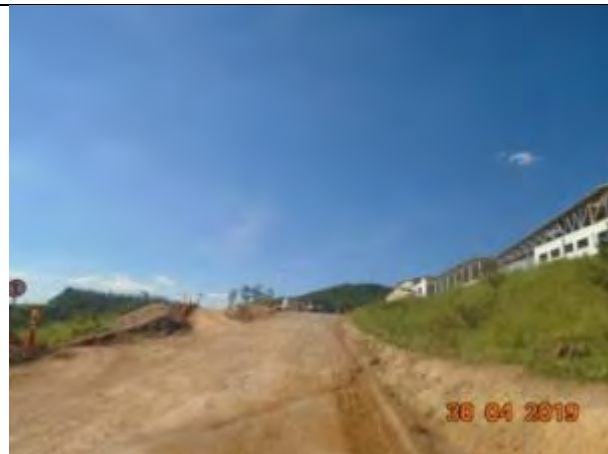
Foto 96: Percurso percorrido – Acesso interno às obras.
