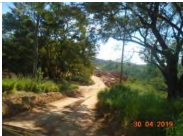
Foto 97: Percurso percorrido – Acesso interno às obras.
