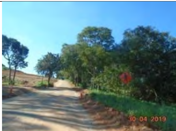
Foto 95: Percurso percorrido – Acesso interno às obras.
