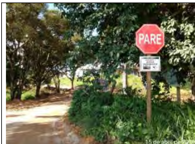
Foto 53: Placas educativas e placa de regulamentação instalada na estrada interna às obras.
