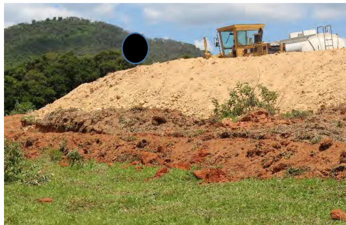
2.2 - Execução de terraplenagem
