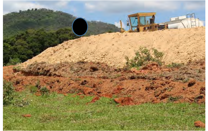
2.2 - Execução de terraplenagem
