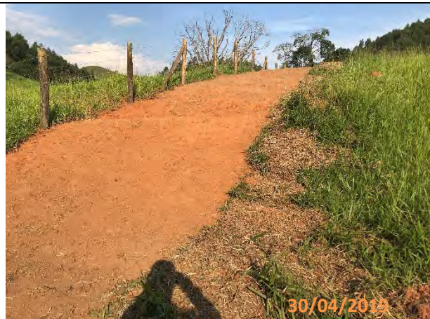
Foto 64: Aceiro de 5 metros realizado no Pátio de Estocagem.
