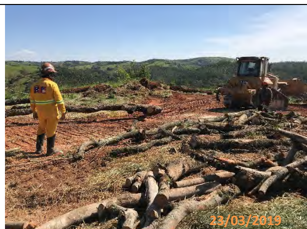
Foto 21: Trator de Esteira realizando a atividade de arraste do material florestal (lenha).
