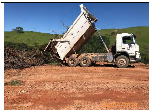
Foto 69: Caminhão Basculante na atividade de transporte dos resíduos florestais.
