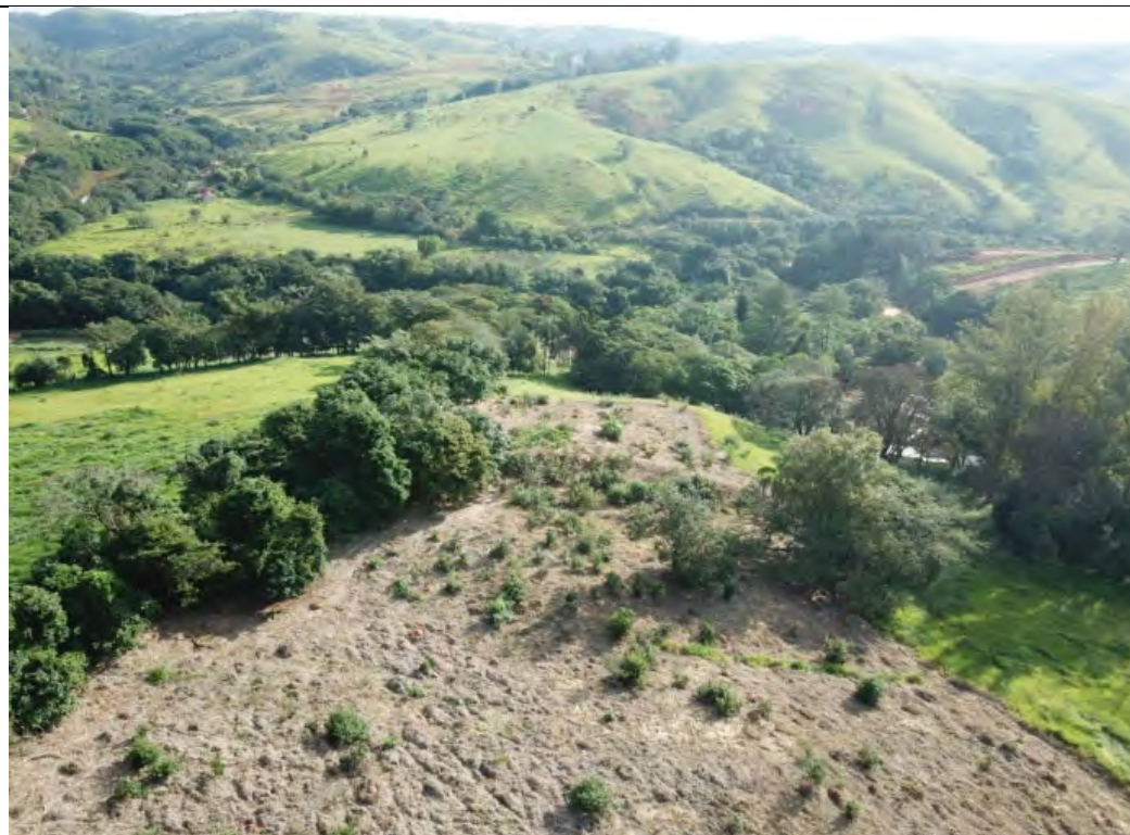
Foto 28: Vista área do Sub lote 1.11, com regeneração natural adjacente a área de plantio..
