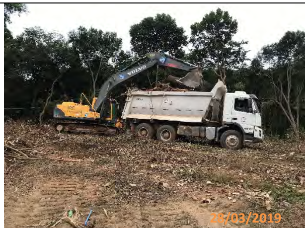
Foto 26: Caminhão basculante aguardando o carregamento de produtos florestais (lenha).
