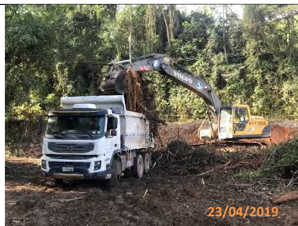
Foto 68: Caminhão Basculante na atividade de Transporte dos resíduos florestais
