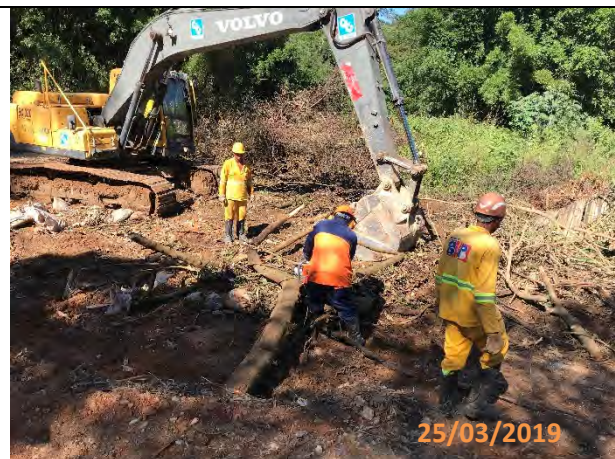
Foto 23: Colaboradores realizando o carregamento de lenhas na escavadeira concha.
