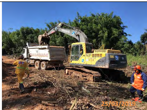
Foto 24: Escavadeira concha realizando carregamento de madeiras no caminhão casculante.
