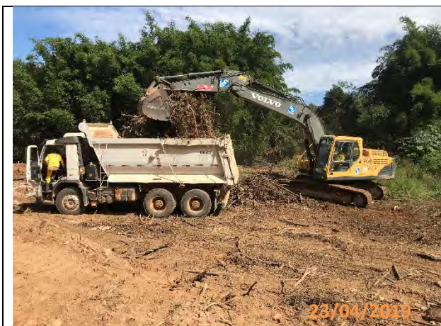
Foto 67: Escavadeira Concha realizando o carregamento dos resíduos florestais
