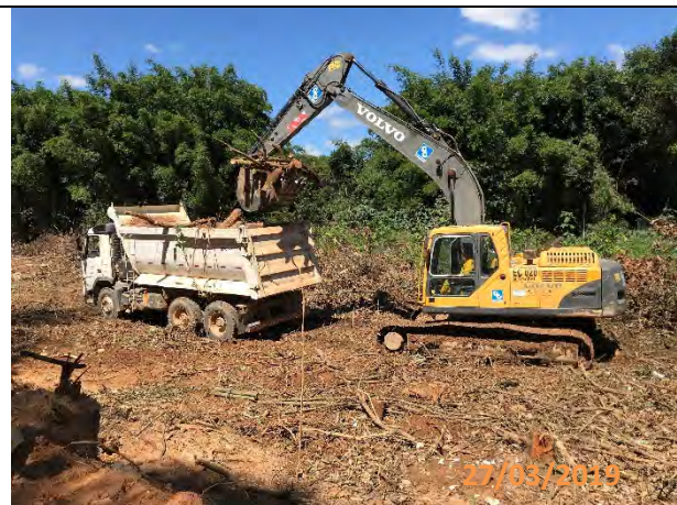
Foto 25: Caminhão casculante e escavadeira concha na atividade de transporte.
