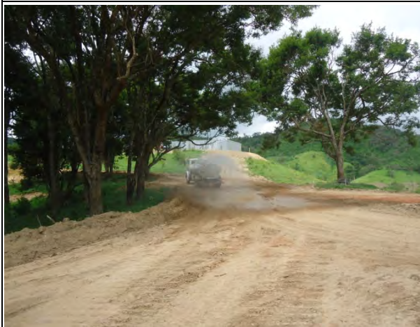
Foto 141 – Umectação das vias internas. (Foto: 04/02/2019)
