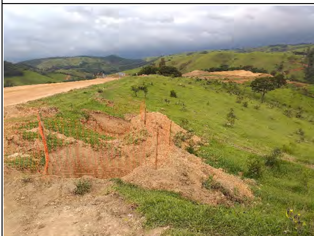
Foto 101 - Implantação de drenagem provisória, com disciplinamento das águas pluviais para cacimbas de decantação, sinalizadas. (Foto:06.02.2019).
