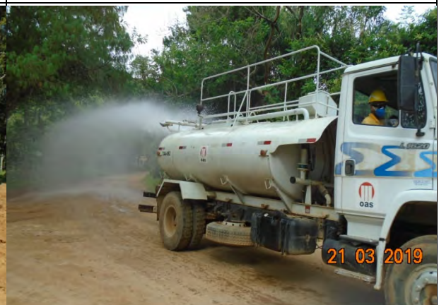
Foto 144 – Umectação das vias de acesso para a obra. (Foto: 21/03/2019)
