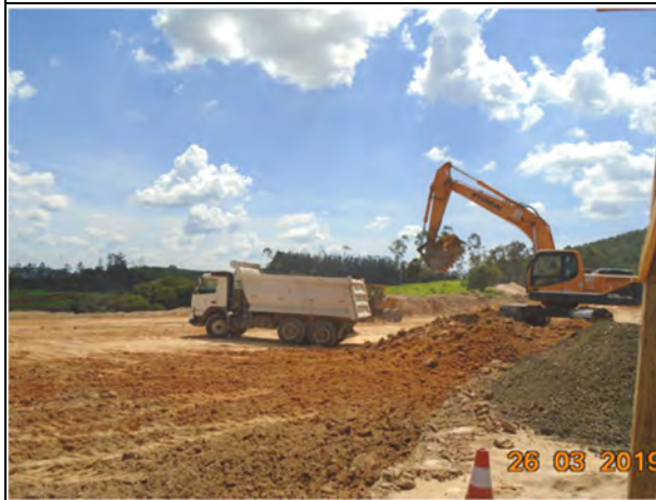
Foto 173 - Movimentação de solo na área do canteiro industrial.
