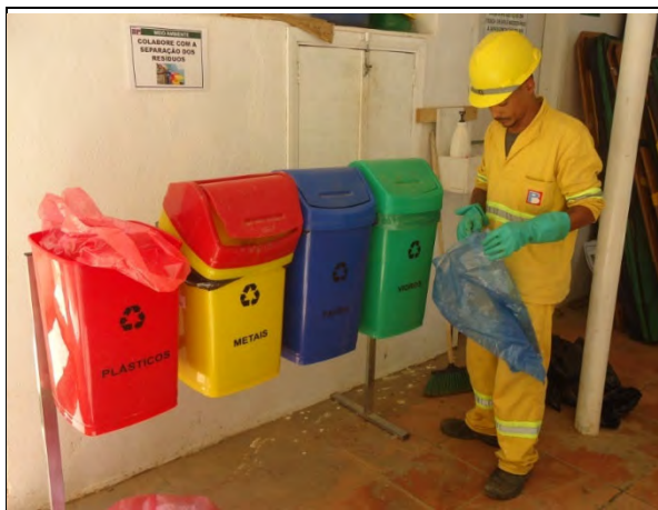
Foto 155 —Coletores de resíduos para triagem de materiais antes do descarte. (Foto: 30.01.2019)
