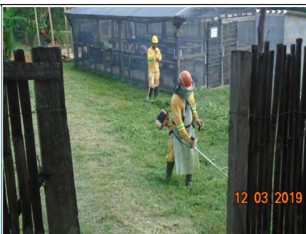
Foto 32 –Manutenção e limpeza do canteiro administrativo.
