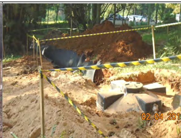
Foto 133 – Instalação do segundo biodigestor no canteiro administrativo.
