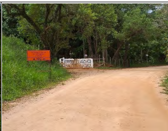
Foto 66 – Sinalização de entrada e saída de veículos presente no acesso a obra. (Foto:04.02.2019)
