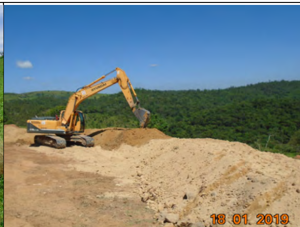
Foto 94 - Inclinação adequada na plataforma.
