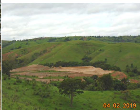
Foto 170 - Área de aterro no canteiro industrial.
