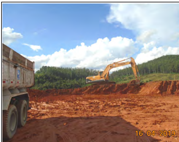
Foto 177 - Vista da escavação obrigatória na margem direita.
