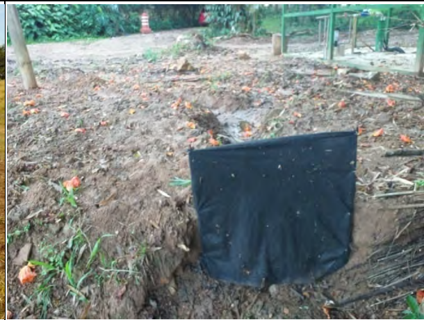
Foto 98 - Instalação de telas-filtro com manta geotêxtil para contenção de sedimento. (Foto: 28.01.2019)
