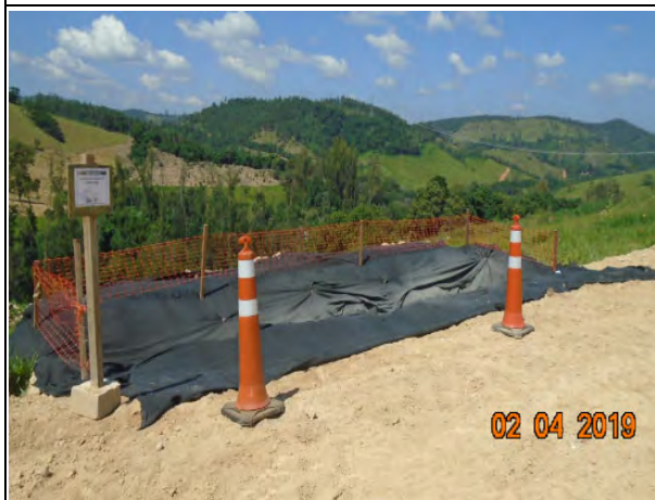
Foto 35 – Sinalização de área para lavagem da calha de caminhão betonera.
