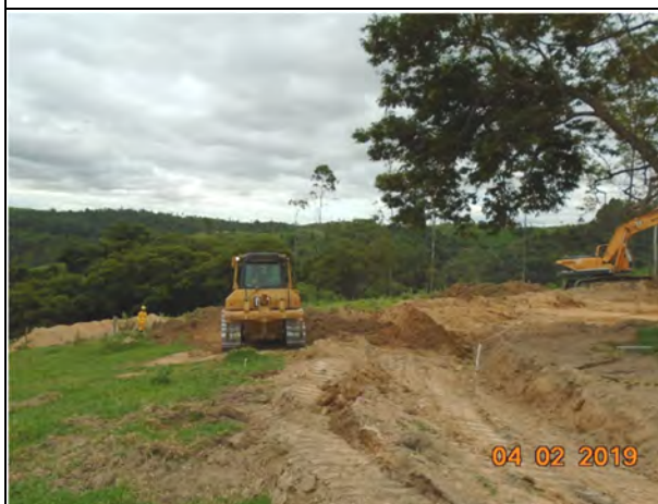
Foto 169 - Terraplenagem para acesso ao futuro canteiro industrial.
