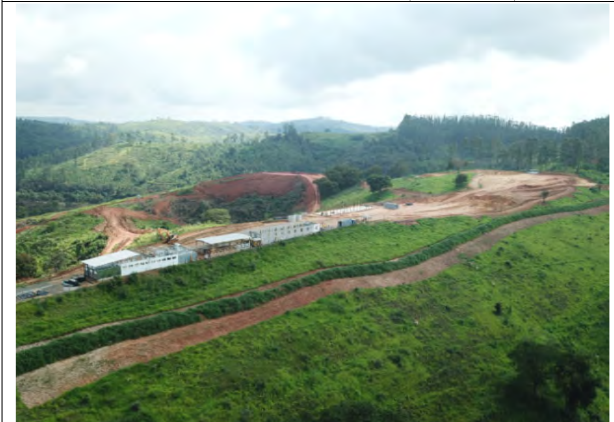
Foto 112 - Drenagem provisória, próximo área do canteiro industrial, vista aérea. (Foto:17.04.2019)
