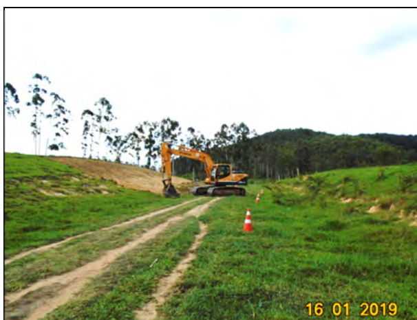
Foto 113 - Início das atividades de regularização topográfica na área do canteiro industrial.
