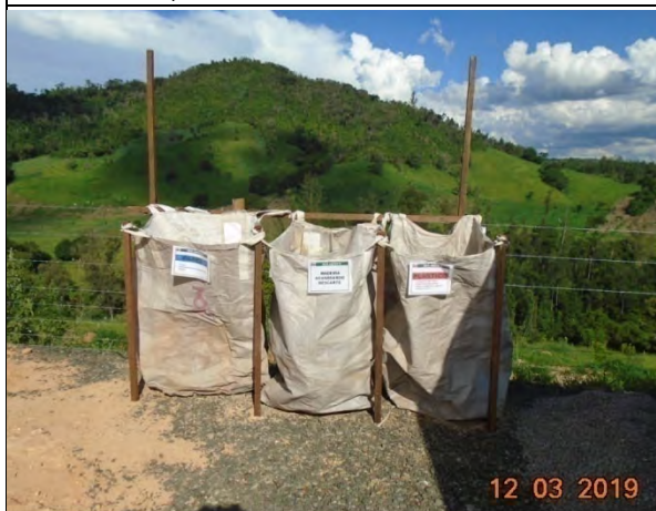
Foto 157 – Segregação temporária de resíduos na frente de serviço.
