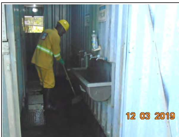
Foto 31 – Limpeza do vestiário instalado no Canteiro administrativo.
