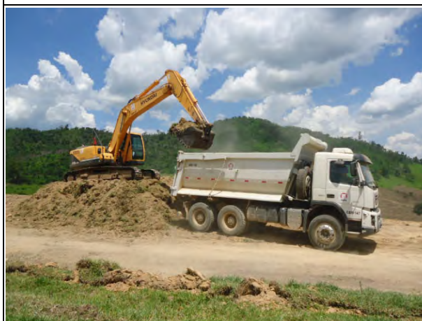
Foto 167 - Movimentação de solo da área do canteiro industrial. (Foto: 18.01.2019)
