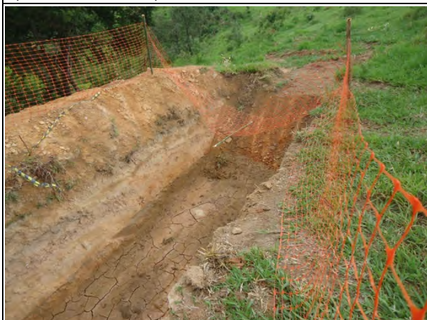
Foto 103 - Cacimba instalada. (Foto: 06.02.2019).
