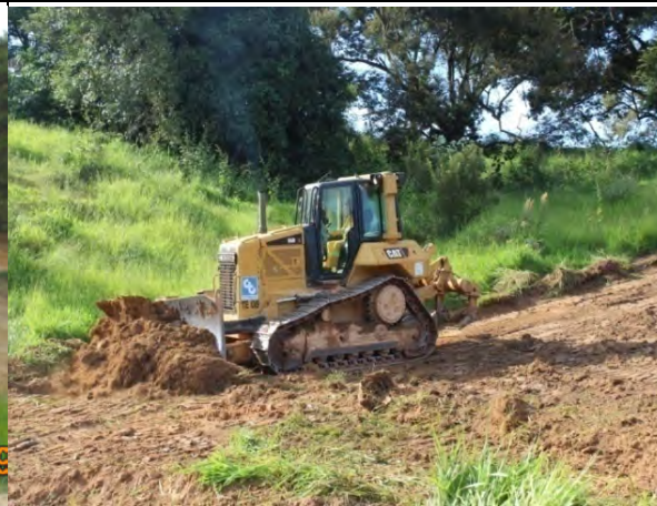
Foto 176 - Registro de atividades de implantação de acesso interno. (Foto: 12.04.2019)
