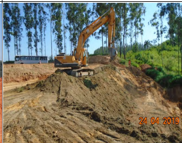
Foto 180 - Terraplenagem em area de implantação do futuro canteiro industrial
