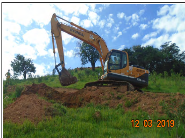
Foto105 - Implantação de cacimba a jusante da estrada de acesso ao canteiro.
