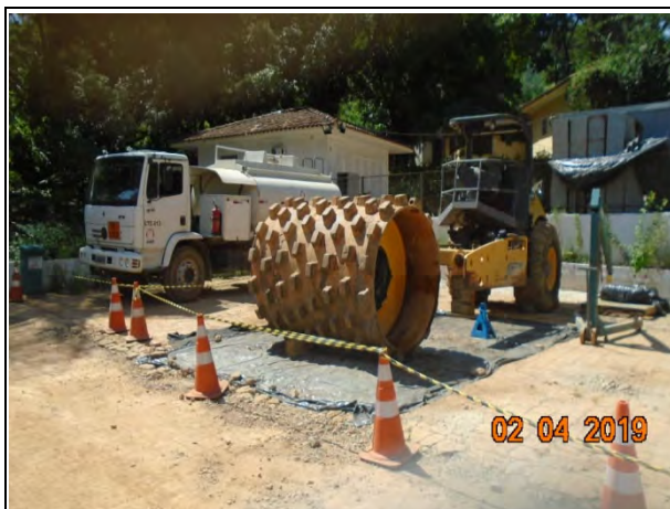
Foto 145 – Manutenção de equipamentos. (Foto: 02/04/2019)
