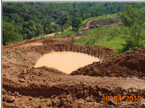
Foto 107 - Cacimba implantada na área de escavação obrigatória com a retenção de sedimentos.
