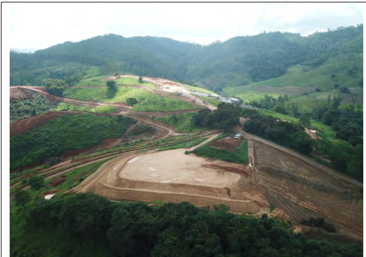
Foto 111 - Curva de nível na área de aterro do canteiro industrial. (Foto: 17.04.2019)
