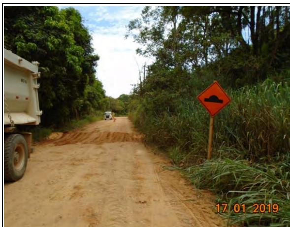
Foto 65 – Implantação de redutor de velocidade, com a devida sinalização na via externa.
