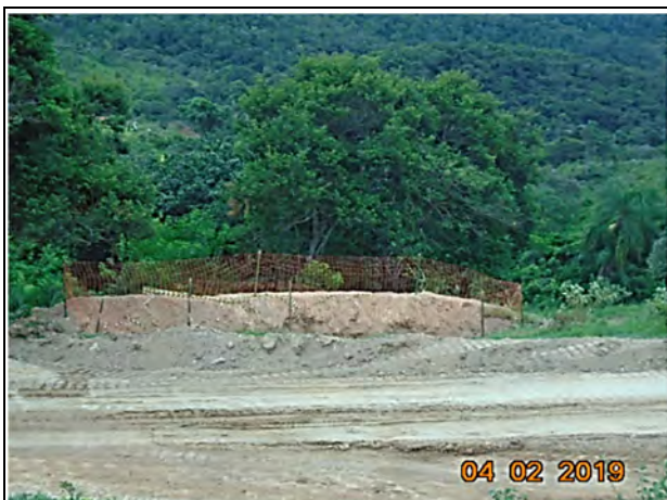
Foto 99 - Cacimba implantada ao longo da obra, sinalizada.
