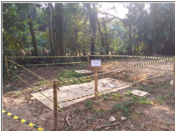
Foto 132 – Área do primeiro biodigestor, devidamente isolada e sinalizada no canteiro administrativo. (Foto: 02.04.2019)
