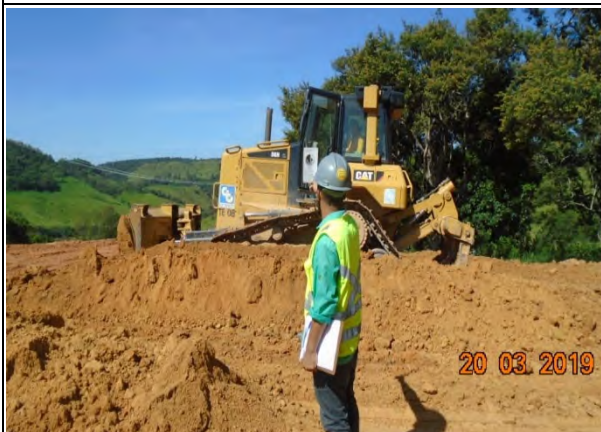
Foto 143 – Monitoramento de fumaça preta utilizando a escala Ringelmann. (Foto:20/03/2019)
