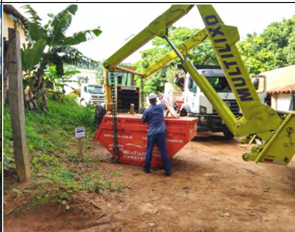
Foto 158 – Substituição de caçamba de resíduo de comum. (Foto: 12.03.2019)
