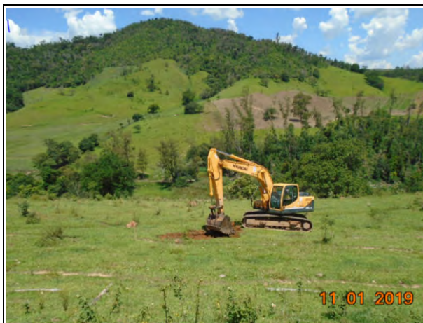
Foto 165 - Início das atividades de terraplenagem no canteiro industrial de Pedreira.
