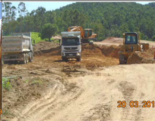
Foto 174 - Escavação na área do canteiro industrial.
