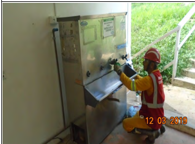
Foto 41 – Instalação de novo bebedouro no canteiro administrativo. (Foto: 12.03.2019)
