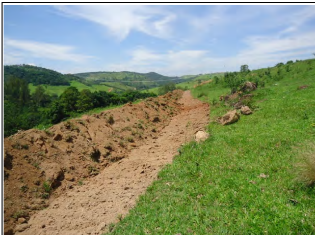
Foto93 - Instalação de curva de nível na área do futuro canteiro industrial. (Foto: 14.01.2019)
