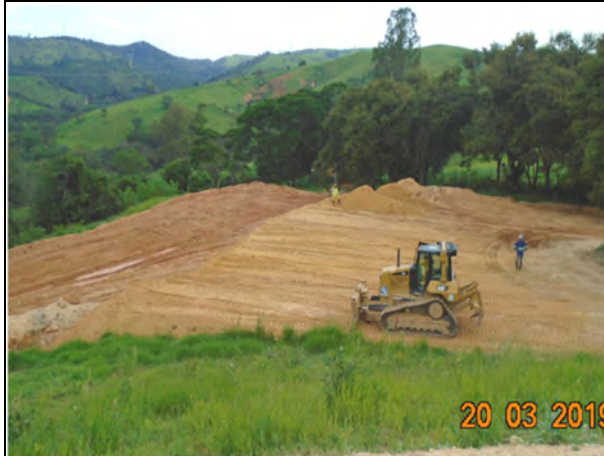
Foto 175 - Movimentação de solo na área de aterro do canteiro industrial.
