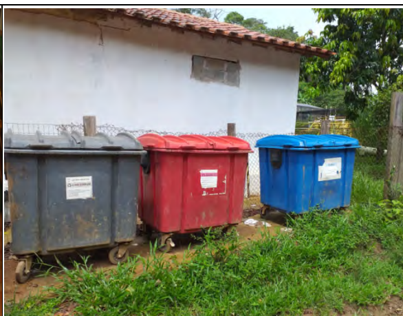
Foto 156 — Central de armazenamento temporário de resíduo sólido. (Foto: 27.02.2019)
