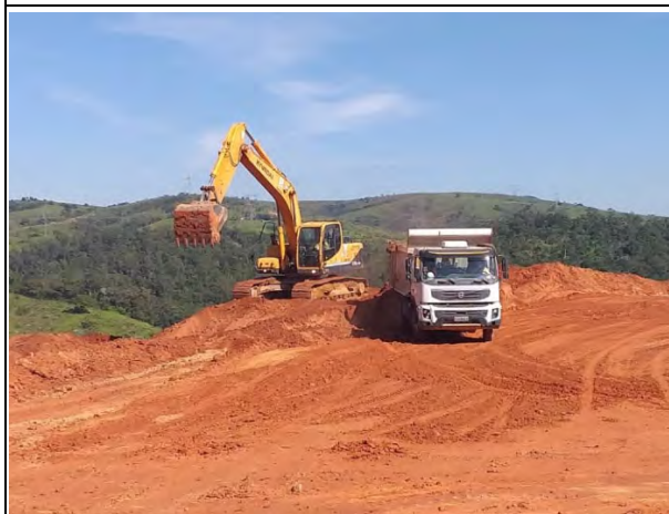
Foto 179 - Detalhe da escavação na margem direita. (Foto 20.04.2019)
