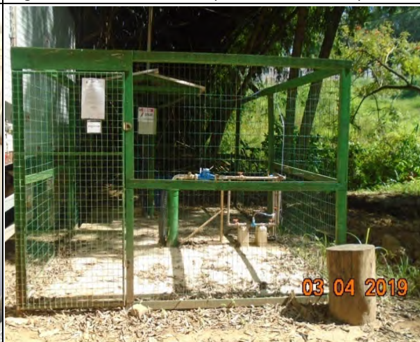
Foto 44 – Poço artesiano instalado no canteiro administrativo. (Foto: 03.04.2019)
