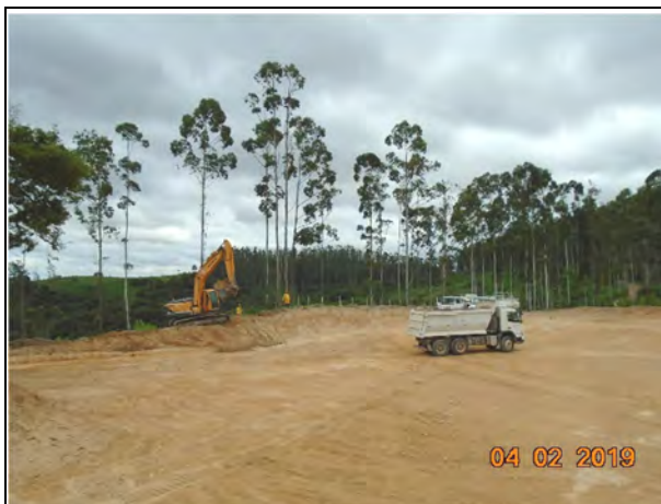
Foto 171 - Movimentação de solo na área do canteiro industrial.
