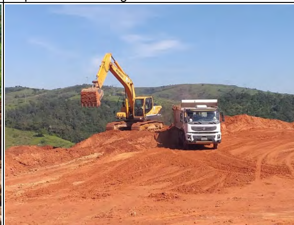
Foto 108 - Registro de atividades de terraplenagem no canteiro industrial. (Foto: 20.04.2019)
