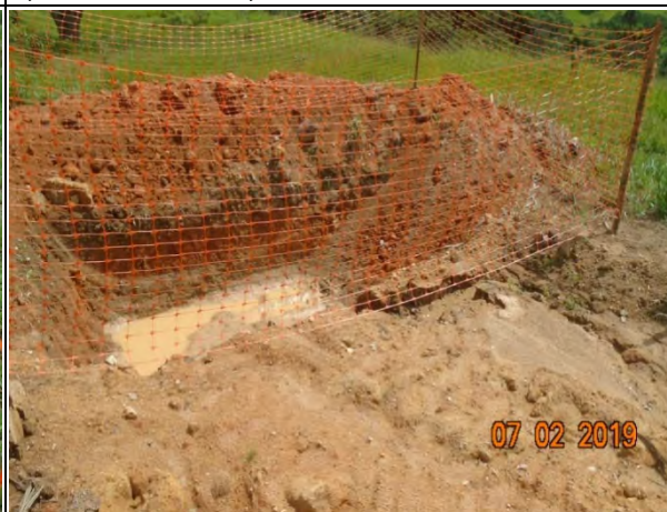
Foto 104 - Instalação de cacimba, sinalizada.
