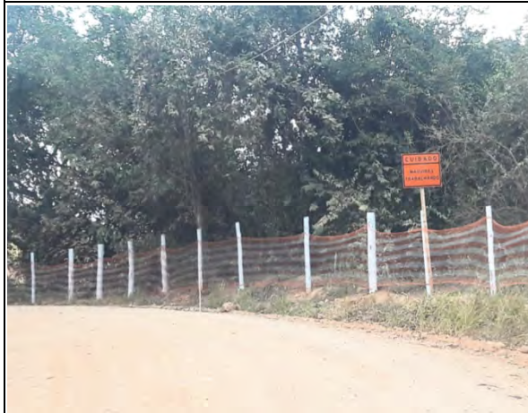
Foto 75 – Sinalização de alerta de máquinas trabalhando em via externa da obra. (Foto: 25.04.2019)
