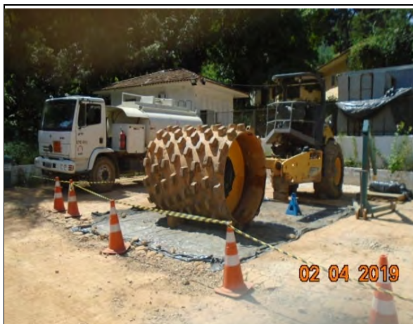
Foto 27 – Manutenção de equipamento com as contenções provisórias implantadas. (Foto:02.04.2019).
