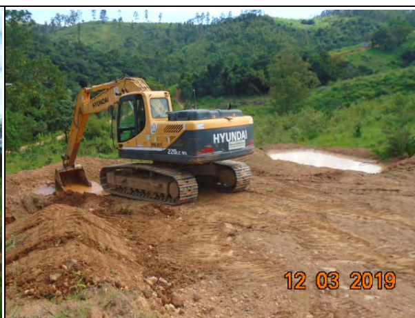
Foto 106 - Manutenção das cacimbas implantadas ao longo da obra.
