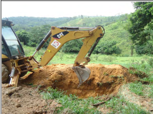
Foto 95 - Implantação de cacimba a jusante do canteiro industrial. (Foto: 24.01.2019)
