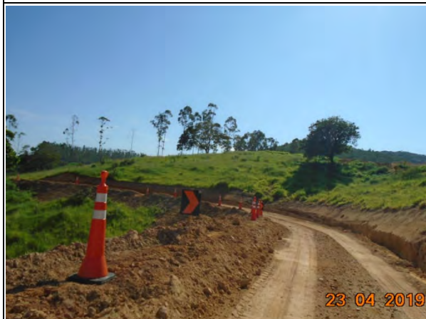
Foto 85 – Sinalização ao longo da via interna no sentido escavação
