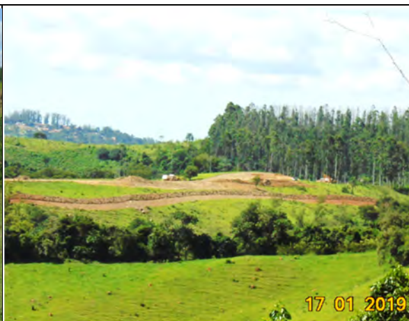
Foto 166 - Drenagem provisória implantada próxima área do futuro canteiro industrial.
