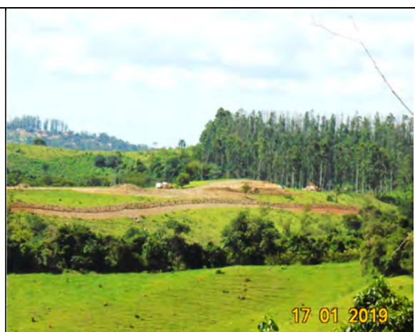
Foto 114 - Instalação da drenagem provisória, próxima área do canteiro industrial, vista aérea.
