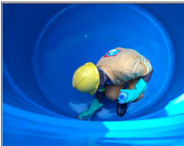
Foto 37 - Limpeza e higienização da Caixa d'água conforme procedimento. (Foto: 12.01.2019)
