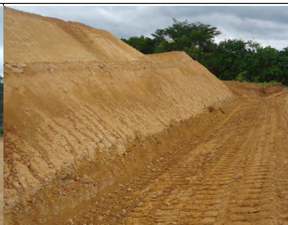
Foto 172 - Aterro canteiro industrial, futura oficina mecânica. (Foto: 06.02.2019)
