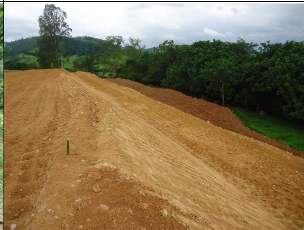
Foto 96 - Vista da compactação do talude. (Foto: 24.01.2019)
