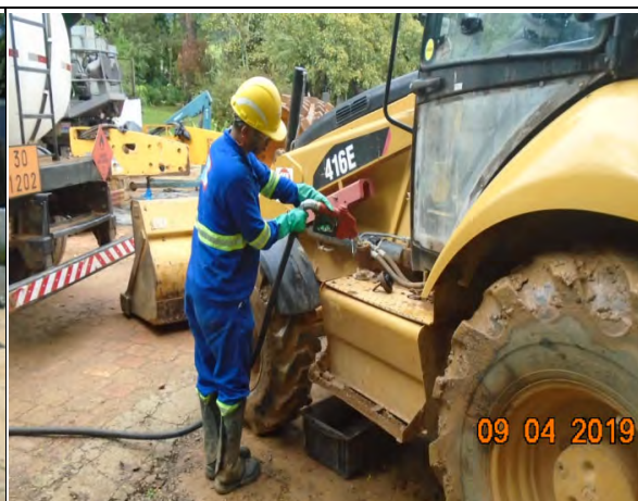
Foto 28 – Operador de abastecimento utilizando a bandeja de contenção durante o abastecimento (Foto:09.04.2019).
