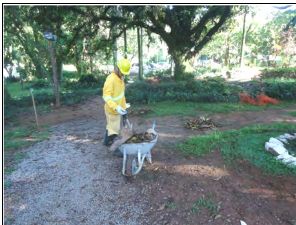
Foto 29 –Organização e limpeza do canteiro. (Foto: 07/01/2019)
