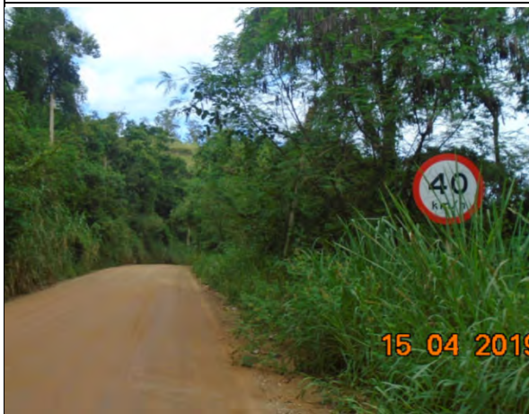
Foto 73 – Sinalização de velocidade máxima permitida na via externa.
