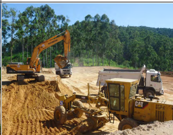
Foto 168 - Movimentação de solo dentro da área do canteiro industrial. (Foto: 29.01.2019)
