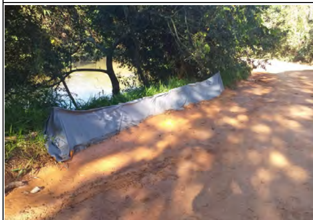
Foto 109 - Instalação de telas-filtro com manta geotêxtil para contenção de sedimento. (Foto:30.04.2019)
