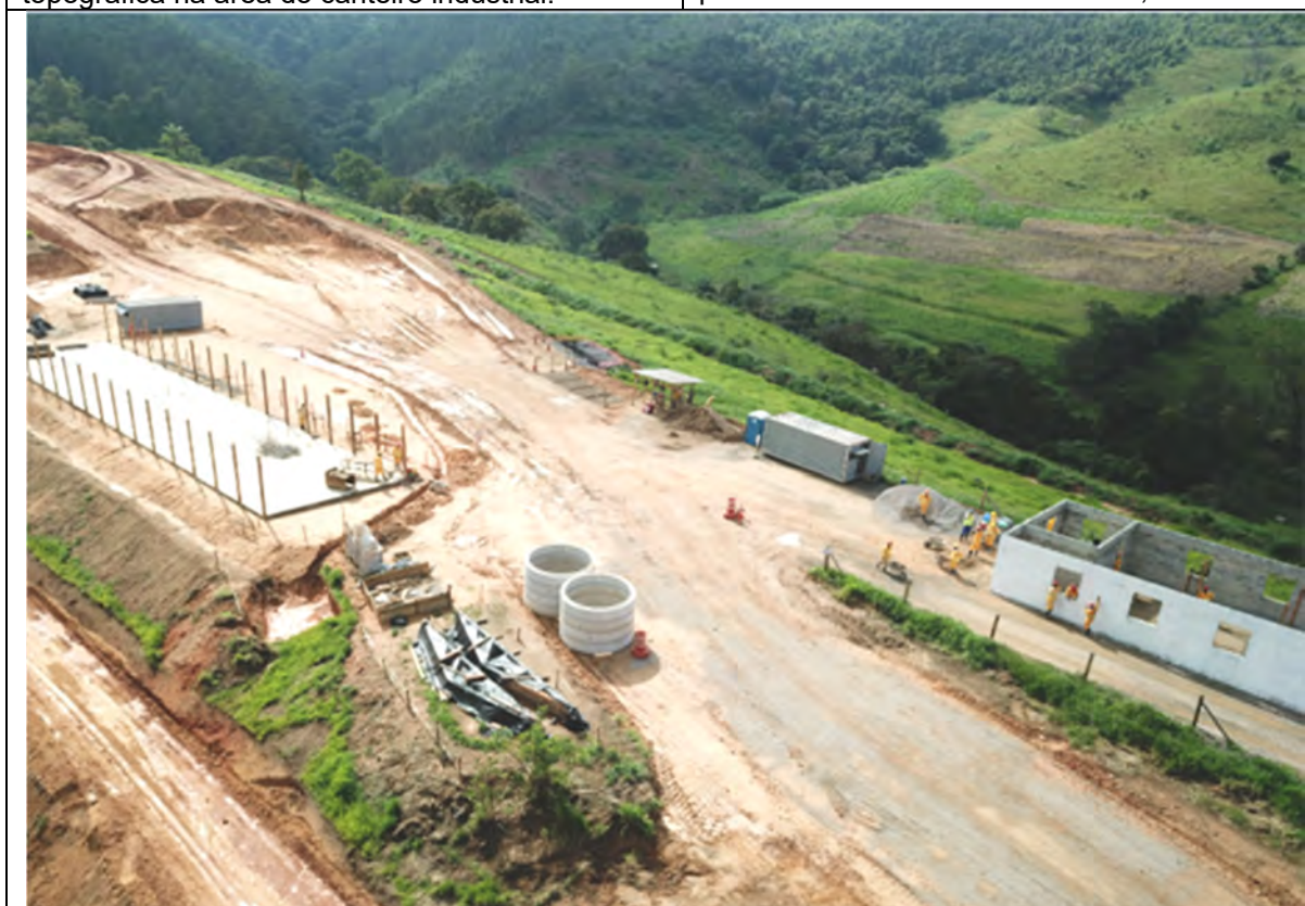
Foto 115 - Avanço da construção das edificações no canteiro industrial. (Foto:17.04.2019)
