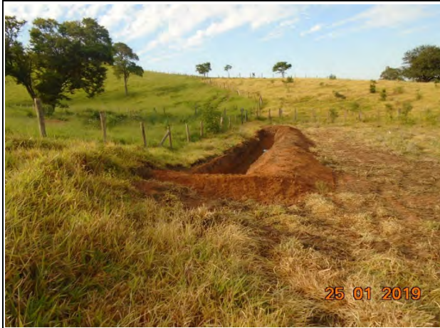
Foto 97 - Instalação de cacimba a montante da área de plantio.
