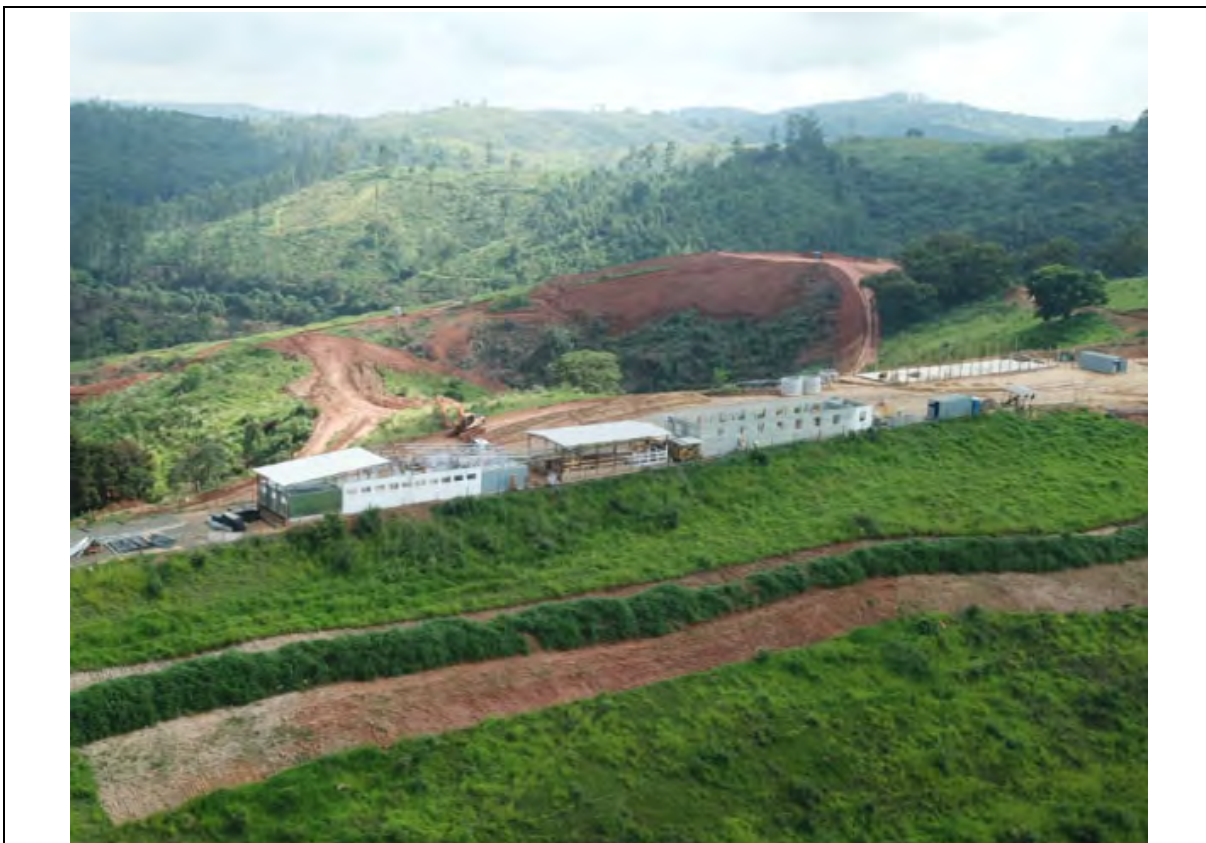
Foto 116 - Avanço da construção das edificações no canteiro industrial, vista aérea. (Foto:17.04.2019)
