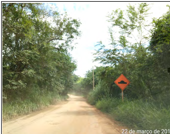
Foto 71 – Redutor de velocidade, com a devida sinalização na via externa.
