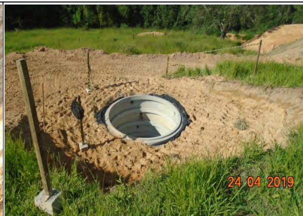
Foto 138 - Registro de instalação do sumidouro no canteiro industrial.
