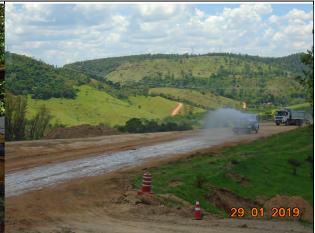
Foto 140 - Umectação das vias internas da obra. (Foto: 29 01 2019)
