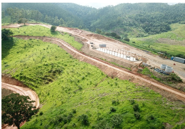
Foto 19. Canteiro industrial - Carpintaria
