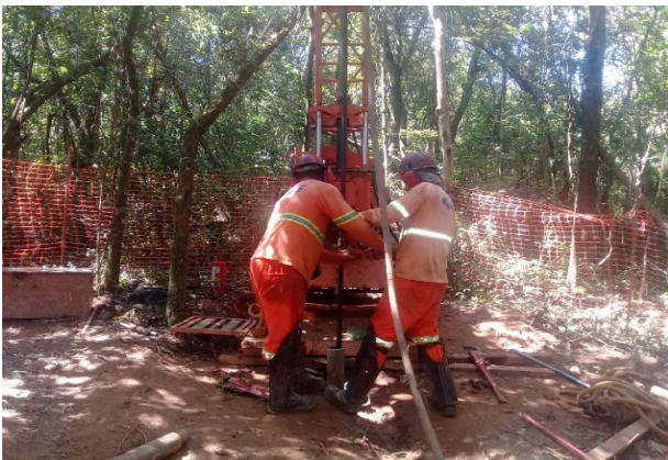
Foto 11. Sondagem mista - margem esquerda.
