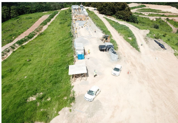
Foto 13. Vista do canteiro industrial
