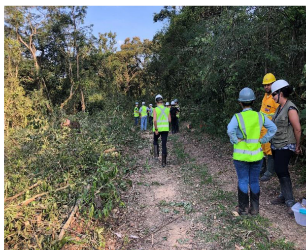
Foto 30. Vistoria do DAE nas obras - Supressão - Dia 04/04/2019.
