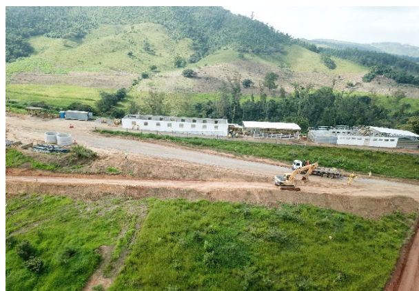
Foto 20. Canteiro industrial - Área de vivência/refeitório
