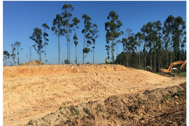
Foto 2. Canteiro Industrial – Terraplenagem
