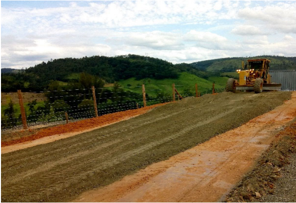
Foto 7. Camada de regularização para estruturas de apoio.
