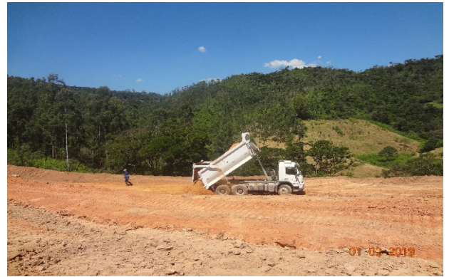
Foto 10. Canteiro industrial - terraplenagem.
