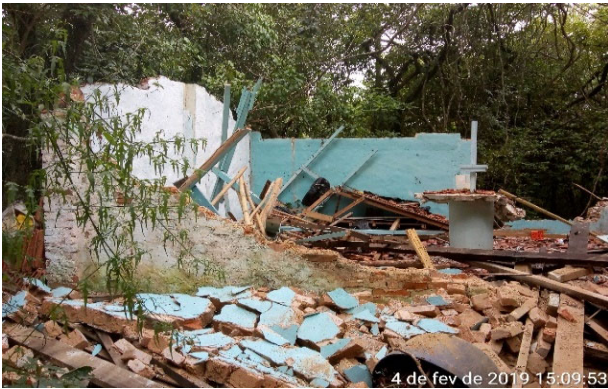
Foto 9. Demolição de edificações
