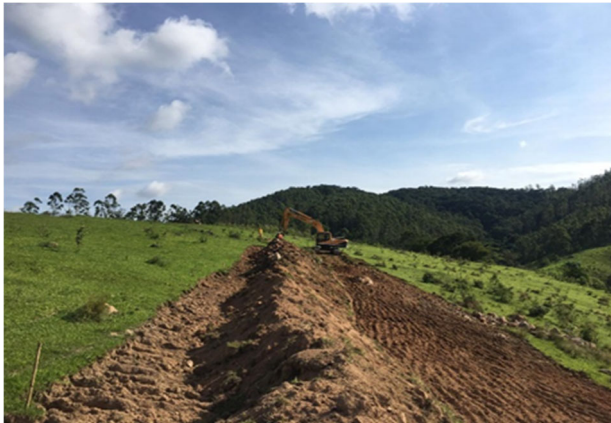
Foto 1 Canteiro industrial - limpeza, roçada e capina.
