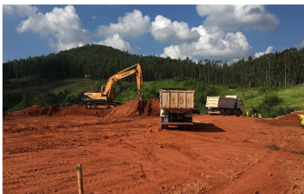
Foto 23. Escavações obrigatórias - margem direita.
