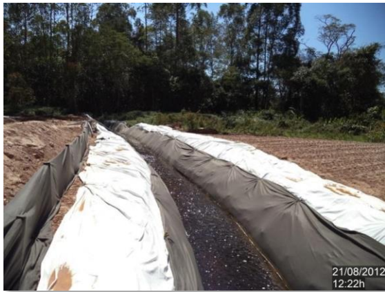
Fotos 7.4.4.1-13 e 7.4.4.1-14: Exemplo de corta-rios implantados para proteção de cursos d'água
