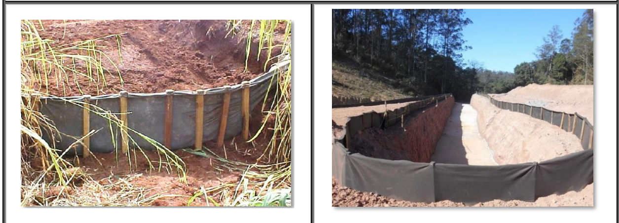
Fotos 7.4.4.1-23 e 7.4.4.1-24: Exemplo de cerca de retenção de sólidos com utilização de manta geotêxtil.
