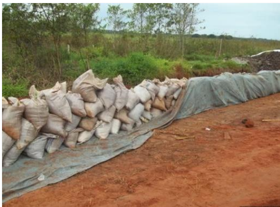
Fotos 7.4.4.1-21 e 7.4.4.1-22: Exemplo de cacimbas recobertas com manta geotêxtil para retenção de solo nas frentes de trabalho.
