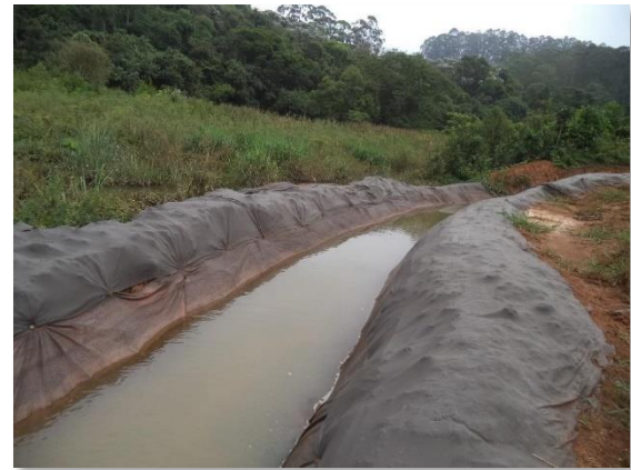
Fotos 7.4.4.1-13 e 7.4.4.1-14: Exemplo de corta-rios implantados para proteção de cursos d'água
