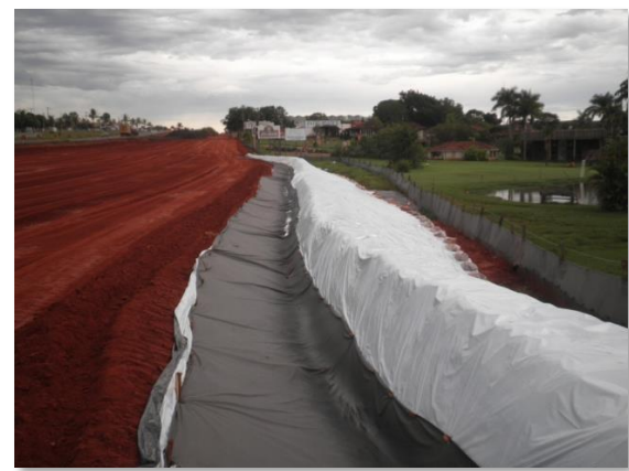
Fotos 7.4.4.1-9 e 7.4.4.1-10: Exemplo leiras composta de manta geotêxtil e lona plástica implantadas para controle de velocidade e escoamento em áreas com solo exposto
