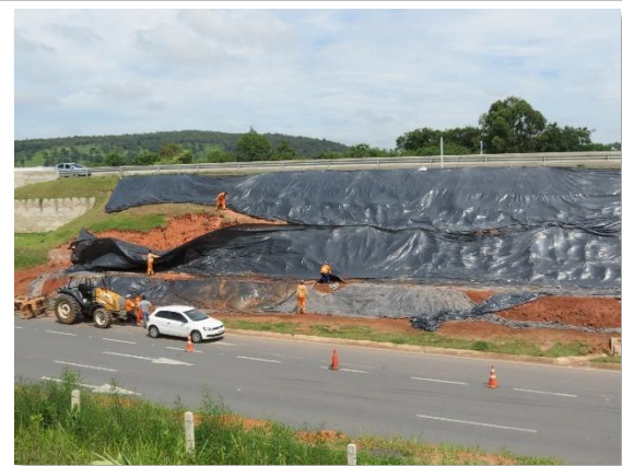
Fotos 7.4.4.1-11 e 7.4.4.1-12: Exemplo de coberturas superficiais de áreas instáveis com utilização de lona plástica de proteção, evitando impacto direto de águas pluviais na estrutura
