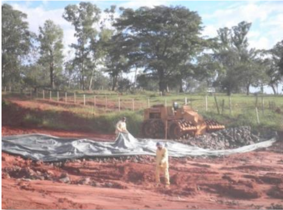
Fotos 7.4.4.1-25 e 7.4.4.1-26: Exemplo de cacimbas recobertas com manta geotêxtil para retenção de solo nas frentes de trabalho.
