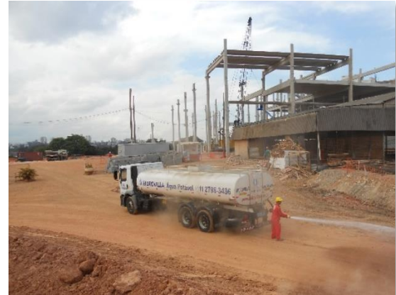
Fotos 7.6.4-1 e 7.6.4-2 – Exemplo de umectação de área de apoio por meio de caminhão pipa com aspersor.
