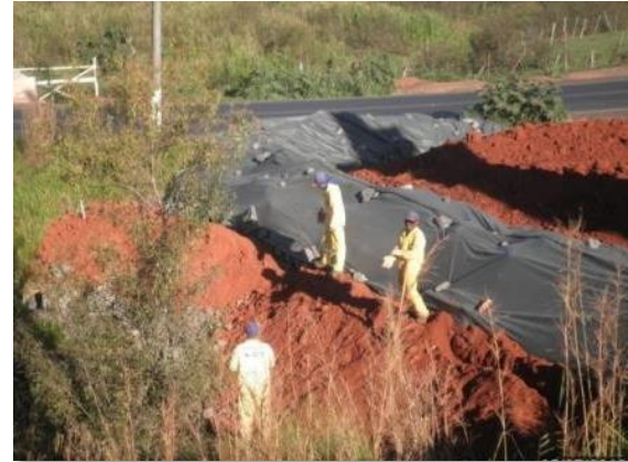
Fotos 7.4.4.1-25 e 7.4.4.1-26: Exemplo de cacimbas recobertas com manta geotêxtil para retenção de solo nas frentes de trabalho.
