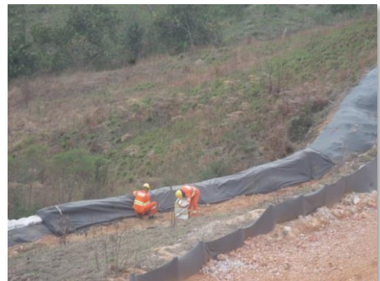
Fotos 7.4.4.1-21 e 7.4.4.1-22: Exemplo de cacimbas recobertas com manta geotêxtil para retenção de solo nas frentes de trabalho.
