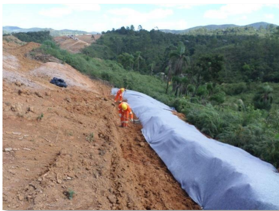
Fotos 7.4.4.1-9 e 7.4.4.1-10: Exemplo leiras composta de manta geotêxtil e lona plástica implantadas para controle de velocidade e escoamento em áreas com solo exposto
