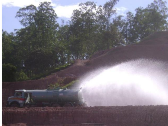
Fotos 7.6.4-1 e 7.6.4-2 – Exemplo de umectação de área de apoio por meio de caminhão pipa com aspersor.
