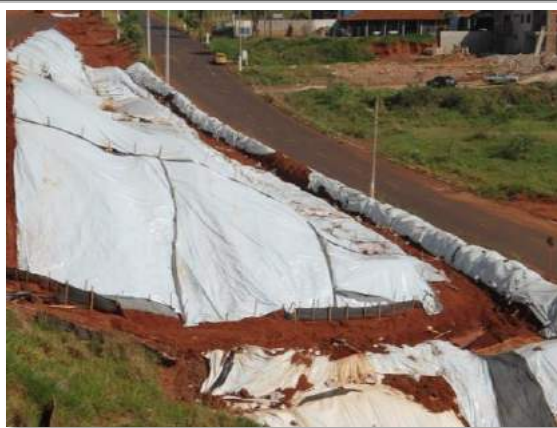
Fotos 7.4.4.1-11 e 7.4.4.1-12: Exemplo de coberturas superficiais de áreas instáveis com utilização de lona plástica de proteção, evitando impacto direto de águas pluviais na estrutura
