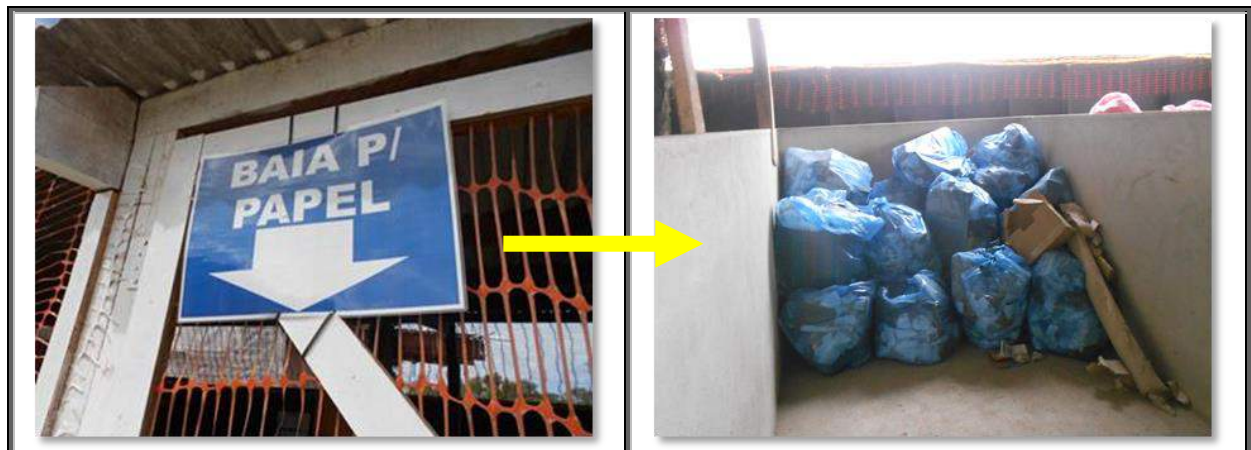
Fotos 5.2-1 e 5.2-2: Exemplo de identificação (sinalização) e acondicionamento adequados dos resíduos de papel. Detalhe para utilização de saco plástico azul, na mesma cor de origem do resíduo.
