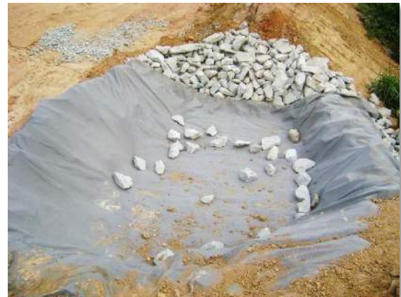
Fotos 7.4.4.1-19 e 7.4.4.1-20: Exemplo de cacimbas recobertas com manta geotêxtil para retenção de solo nas frentes de trabalho.
