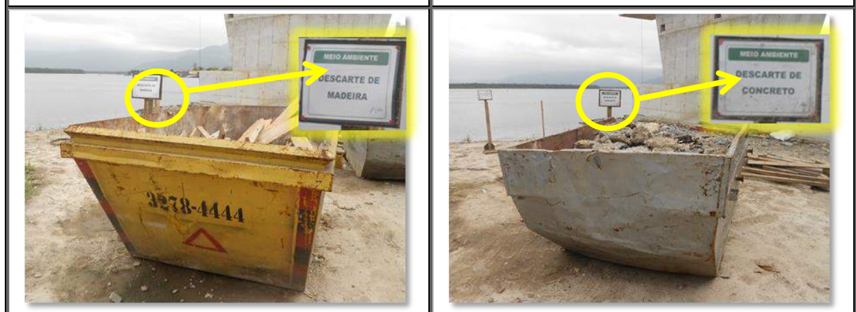
Fotos 5.2-13 e 5.2-16: Exemplos de identificações e local (recipientes e caçambas) adequados ao acondicionamento de resíduos gerados nas frentes de obra.
