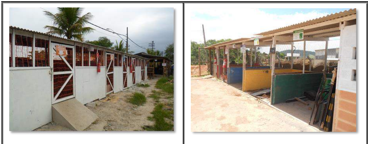
Fotos 5.3-1 e 5.3-2 – Vista geral de locais (baias) destinados para o acondicionamento correto de resíduos gerados nas frentes de trabalho.
