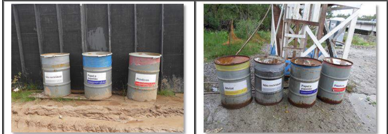
Fotos 5.2-11 e 5.2-12: Exemplos de identificação (sinalização) e acondicionamento adequados dos resíduos ambulatoriais gerados no canteiro de obras.
