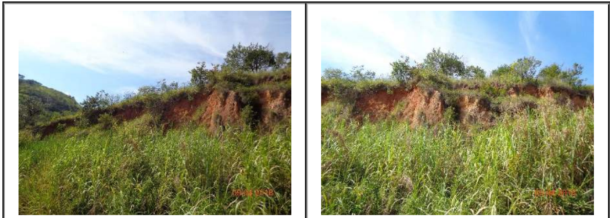
Fotos 5.2-1 e 5.2-2: Exemplo de processos erosivos em solo residual de granito, encontrado na área de inundação e/ou marginal a mesma.
