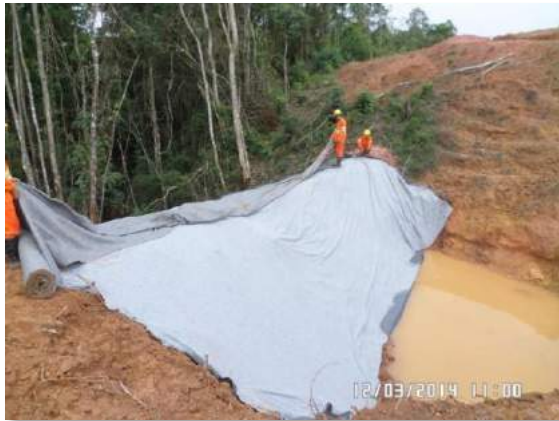
Fotos 7.4.4.1-19 e 7.4.4.1-20: Exemplo de cacimbas recobertas com manta geotêxtil para retenção de solo nas frentes de trabalho.
