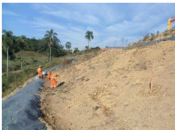
Fotos 7.4.4.1-7 e 7.4.4.1-8: Exemplo de leiras de solo implantadas para controle de velocidade e escoamento em áreas com solo exposto
