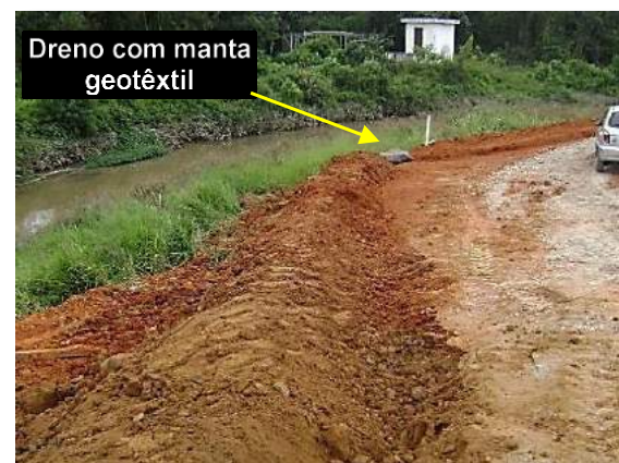
Fotos 7.4.4.1-7 e 7.4.4.1-8: Exemplo de leiras de solo implantadas para controle de velocidade e escoamento em áreas com solo exposto
