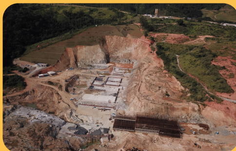
Visão geral da obra. Data: 14/05/22
