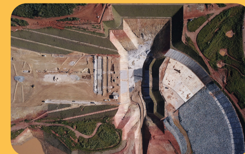
Visão geral da obra. Data: 14/05/22
